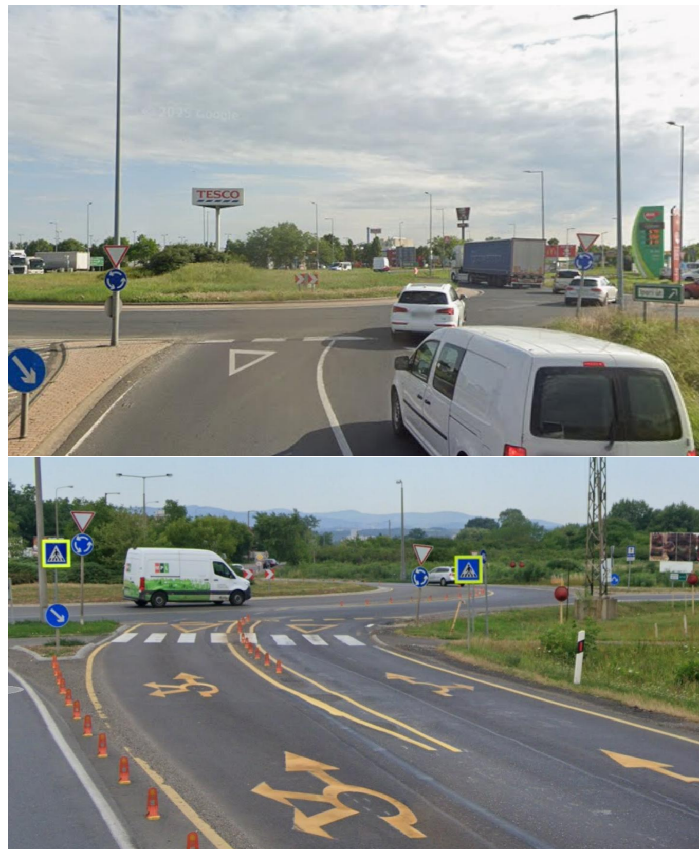
62. ábra: A Zanati úti körforgalom mai kialakítása, és a 3-as és a 37-es főutak körforgalmú csomópontja az ideiglenes átépítés után, jó példa a körforgalmak kapacitásbővítésére és biztonságosabbá tételére kis költségből (Fotó: Együd Marcell)
