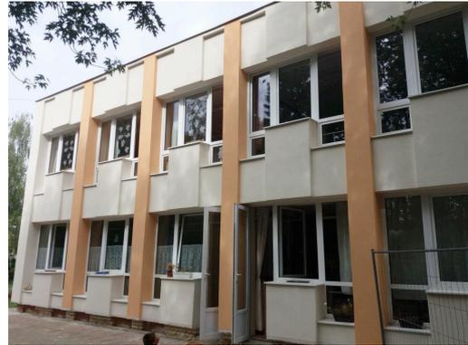
Az óvoda felújítása kiterjedt a homlokzati hőszigetelésre, vízszigetelésre, nyílászáró cserékre, tetőszigetelésre, valamint az épület gépészeti berendezéseinek (radiátorok, elszívó berendezés stb.) cseréjére is.
