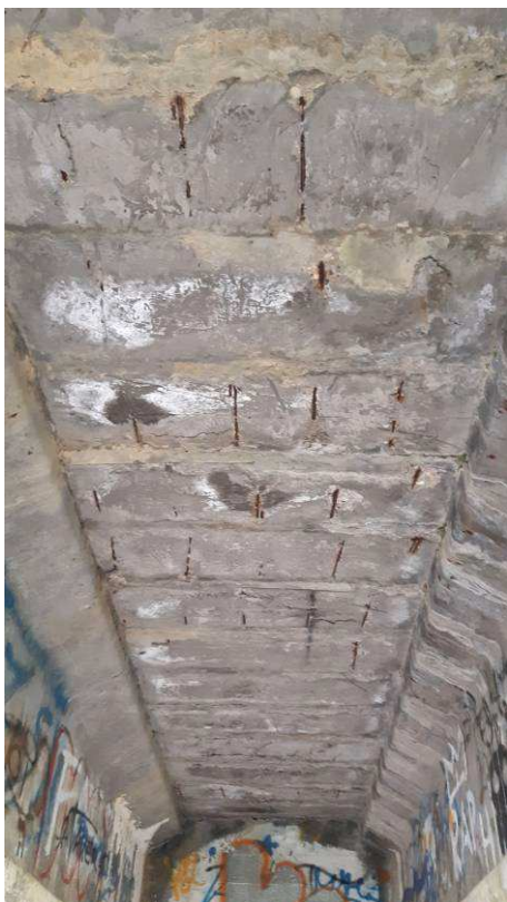
3, 4 képek: Keresztirányú előregyártott pályatáblák alsó felületén beton leválás, kilátszó vasak. Szegélyek oldalán hosszirányú repedés, megtelepedett moha, helyenként leválások.
