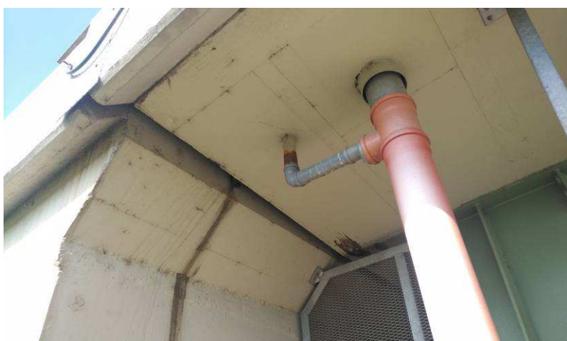
26. kép: Hídfő előtt a vasbeton lemez alsó síkján meszes kiválási csík alakult ki.
