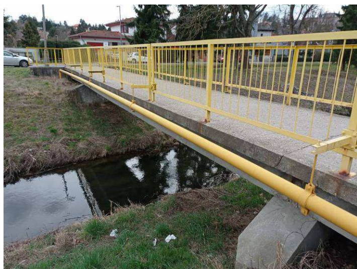
4. kép: A pályalemez irányított repedése tömítetlen, szigetelés nincs, korláttalpagnál korrózió alakult ki. A híd másik szélén a felfüggesztések korróziósak.
