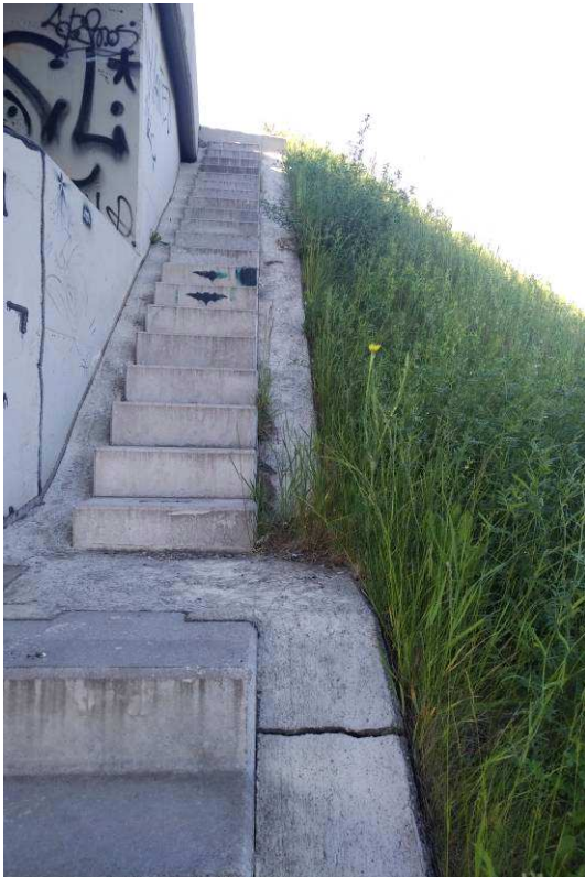
30,31 képek: A lépcső megtámasztó bordája egy helyen eltört, a pótpadka kissé megsüllyedt.
