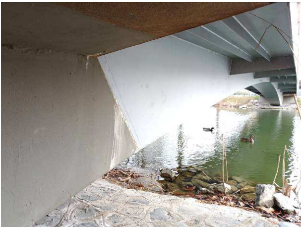
5. 6. képek: Az acéltartó és a vasbeton tartó csatlakozásánál vízlefolyás, vasbeton és acél korrózió mindkét hídvégen. A vasbeton főtartó alsó részén hosszirányú repedés rajzolódik ki meszes kifolyással a híd mindkét végén.
