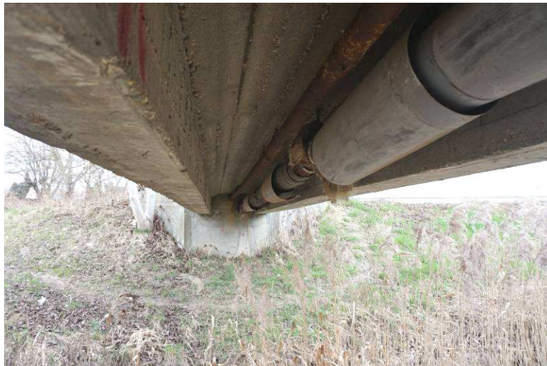
3. 4. képek: Főtartós helyenként cementpép hiányosak, pontszerű korrózió, közmű csatlakozás tömítetlen, szárnyfal mellett fa nő.
