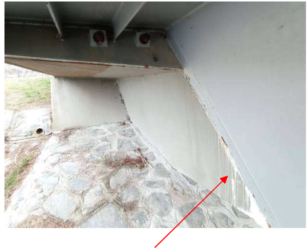
5. 6. képek: Az acéltartó és a vasbeton tartó csatlakozásánál vízlefolyás, vasbeton és acél korrózió mindkét hídvégen. A vasbeton főtartó alsó részén hosszirányú repedés rajzolódik ki meszes kifolyással a híd mindkét végén.
