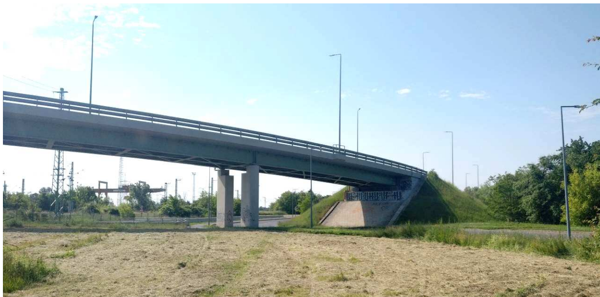
25. kép: Ny-i híd.
