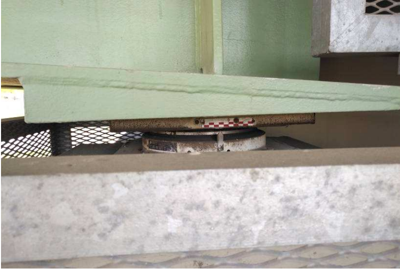
7. kép: Saru állapota megfelelő.
