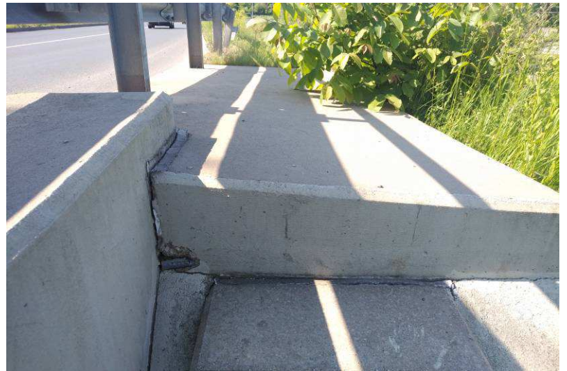
30,31 képek: A lépcső megtámasztó bordája egy helyen eltört, a pótpadka kissé megsüllyedt.
