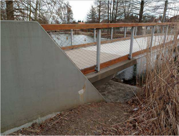
3. 4. képek: Mellvédfalak alsó sarkán ferde repedéskép és meszes lefolyás látható. (Vb. pályalemez becsatlakozásánál.) A sziget felőli mellvédfalakon ezek jelentősebbek. A híd környezete rendezett.
