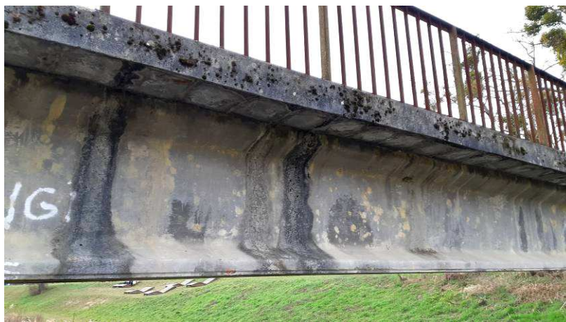
3, 4 képek: Keresztirányú előregyártott pályatáblák alsó felületén beton leválás, kilátszó vasak. Szegélyek oldalán hosszirányú repedés, megtelepedett moha, helyenként leválások.
