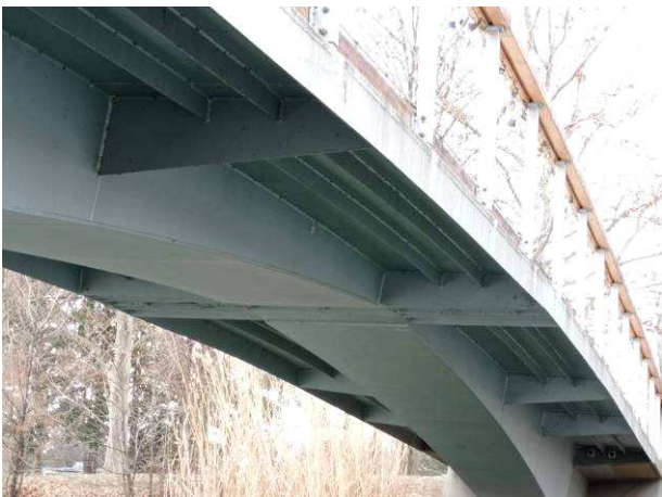
5. 6. képek: Az acéltartó és a vasbeton tartó csatlakozásánál vízlefolyás, vasbeton és acél korrózió mindkét hídvégen. A vasbeton főtartó alsó részén hosszirányú repedés rajzolódik ki meszes kifolyással a híd mindkét végén.
