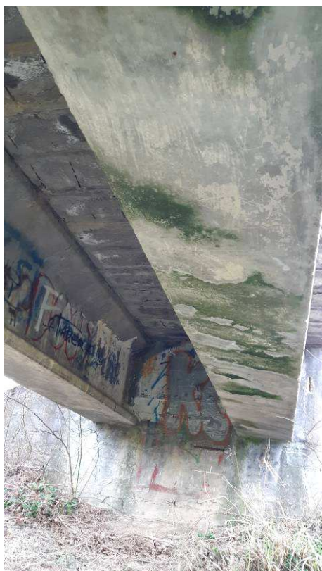
6. kép: Hídfőn felületi hámlás, fészkes betonfelület, kilátszó korróziós betonacélok. Főtartók alsó síkján moha telepedett meg.
