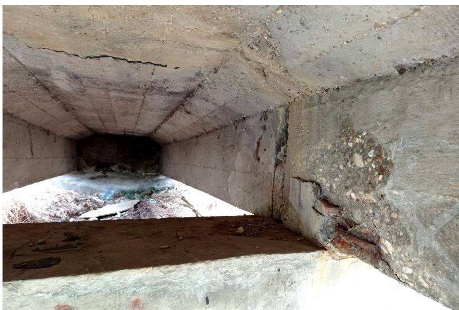
3. kép: Támaszok felett gerendavégeknél repedések, a repedések mentén meszes leázások melyek az alépitményre folynak. Konzolvégeken betonleválások, acélkorrózió.
