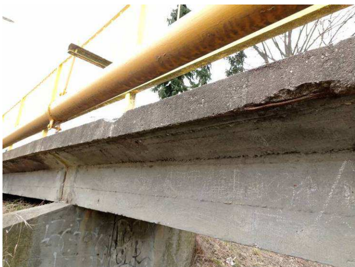
3. kép: Támaszok felett gerendavégeknél repedések, a repedések mentén meszes leázások melyek az alépitményre folynak. Konzolvégeken betonleválások, acélkorrózió.
