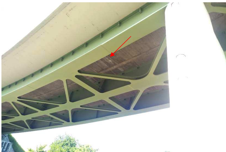
26. kép: Hídfő előtt a vasbeton lemez alsó síkján meszes kiválási csík alakult ki.
