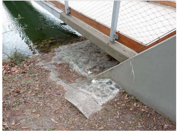
3. 4. képek: Mellvédfalak alsó sarkán ferde repedéskép és meszes lefolyás látható. (Vb. pályalemez becsatlakozásánál.) A sziget felőli mellvédfalakon ezek jelentősebbek. A híd környezete rendezett.
