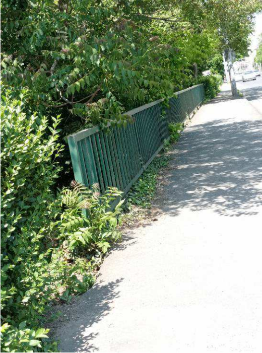
7. kép: a korlát több helyen korróziós, a növényzet teljesen benövi a széleket, a gyalogos forgalmat akadályozva. A járda aszfaltburkolata nem szakszerű javítás a hidakon, mert a szükséges szigetelést nem látja el a tartószerkezetek felett.
