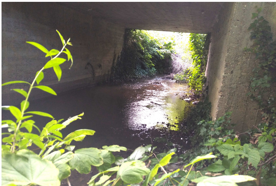
6. 7. képek: A patakmeder hordalékkal telt. A befolyási oldalon az odahordott kerti hulladék akadályozza a vízlefolyást.
