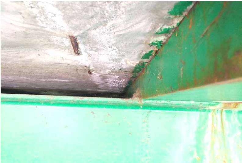
8. kép: Felszerkezet felületén mészkiválás, látszódnó korróziós betonacél, betonfedés nem megfelelő.
