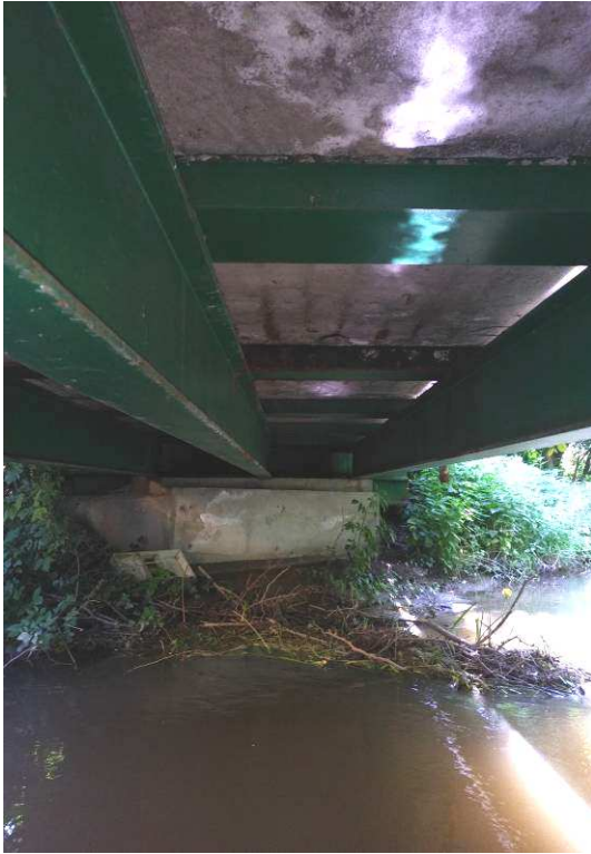
8. kép: Felszerkezet felületén mészkiválás, látszódnó korróziós betonacél, betonfedés nem megfelelő.
