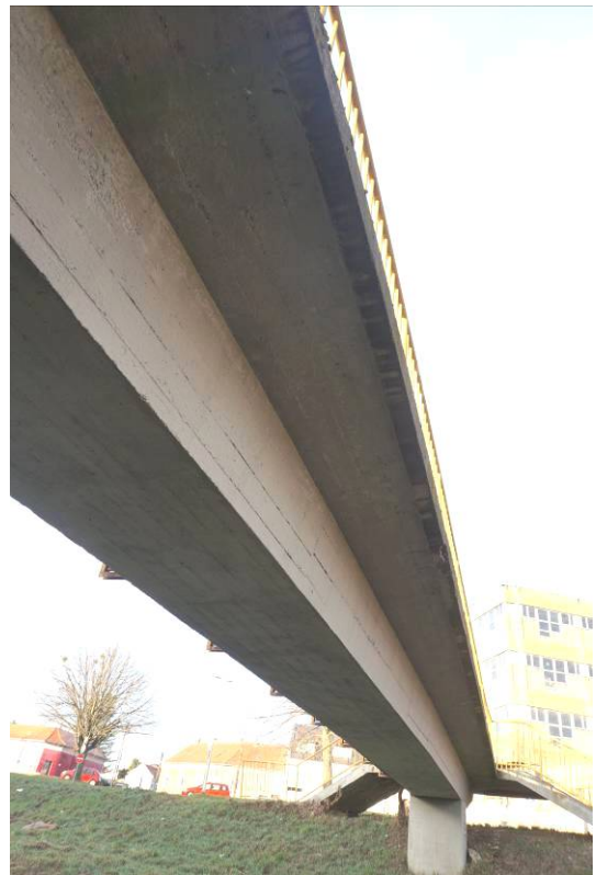
8. 9. képek: A főtartó megfelelő állapotú, a támaszok mögötti konzolos szakaszain repedések láthatók. A konzolok alsó síkján elszórtan korróziós pontok és cementpéphiány látható. A konzolvégeken sok helyen betonleválás és korróziós foltok ill. betonacélok láthatók.
