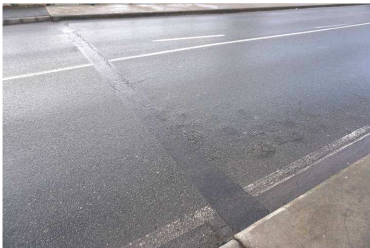
5. kép: Az aszfalt dilatáció megsüllyedt, a környezete repedezett, vízzárósága nem biztosított. A pályaburko-
