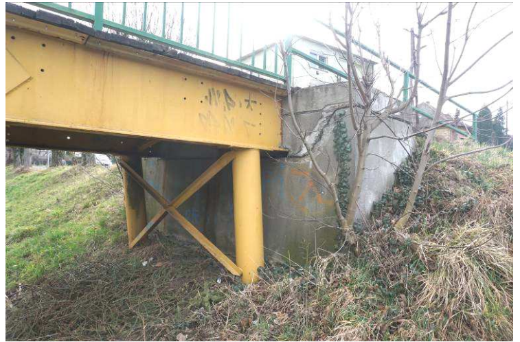
4. kép: Hídfőkön a szerkezeti gerenda erőteljesen megrepedt, ami az acél főtartók dilatációs mozgásának következménye.
