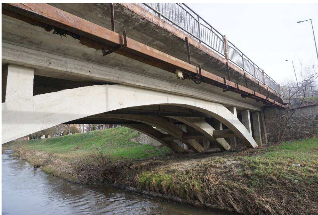
11. kép: Kifolyási oldal. Az ívgerendán sarokrepedések, a konzolon keresztirányú repedések, átázások nyomai, a fémlemez borítás és a közműfelfüggesztések korrodáltak.
