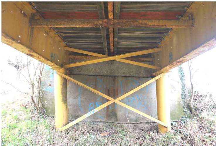
5. 6. képek: A szerkezeti gerenda mögül a hídfőkre folyik a csapadék, azokat áztatja. A hídfő tövében erőteljes növényzet. Az acél gerendák és egyéb acélszerkezetek korróziósak. A faanyag védelme nem megfelelő.
