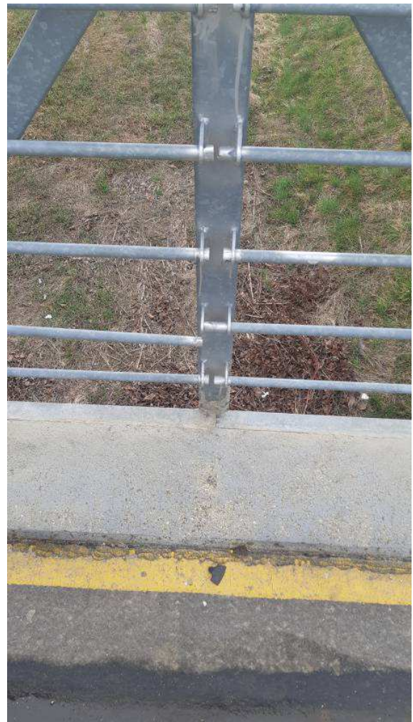
4. 5. képek: Eltömődött víznyelő, szennyezett, korrodált dilatáció. Több korlátcső kicsúszott a helyéről. A korlátcsövek kicsúszását semmi nem akadályozza meg.
