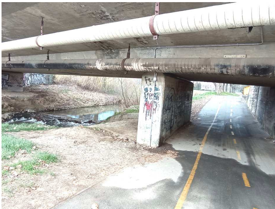
17. kép: A híd alatti útburkolat vízelvezetése nem megoldott. A lefolyó víz a pillérnél kimosódást okoz és annak környezetét errodálja.
