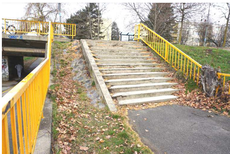
17. kép: A híd alatti útburkolat vízelvezetése nem megoldott. A lefolyó víz a pillérnél kimosódást okoz és annak környezetét errodálja.
