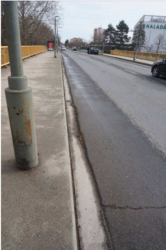
6. 7. képek: A járdák bevonata lekopott, a korlátoszlopok talpai korrodáltak. A járdákhoz csatlakozó ellenesésű öntöttaszfalt ék rugalmas tömitései megsüllyedtek, a víz a szerkezetbe jut.
