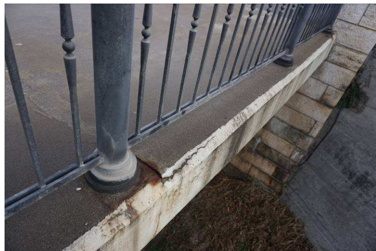
6. kép: A járdaszegélyen repedések, bevonatleválás, korlátoszlop tövében korrózió. lat aszfaltja több helyen repedezett, felhólyagosodott.
