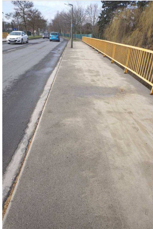
6. 7. képek: A járdák bevonata lekopott, a korlátoszlopok talpai korrodáltak. A járdákhoz csatlakozó ellenesésű öntöttaszfalt ék rugalmas tömitései megsüllyedtek, a víz a szerkezetbe jut.
