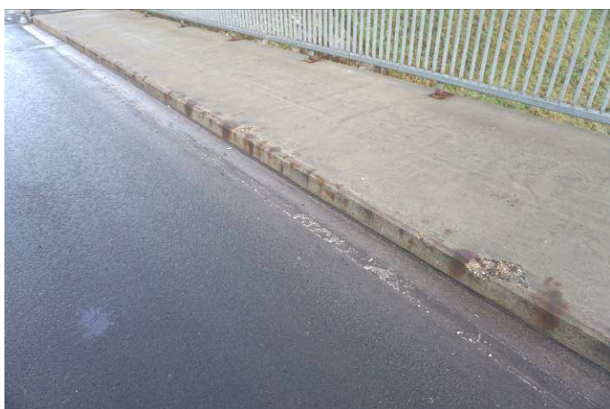
5. 6. képek: A járdán keresztirányú repedések, a beton és a bevonat hámlik, erőteljes acélkorrózióra utaló foltok vannak. A korláttalpknál erőteljes korrózió figyelhető meg. Áruház felőli háttöltés erőteljesen megsüllyedt, a két csatlakozó járdával együtt. A csatlakozó aszfaltburkolat tönkre ment. Az útburkolat a hídon hosszirányban repedezett.
