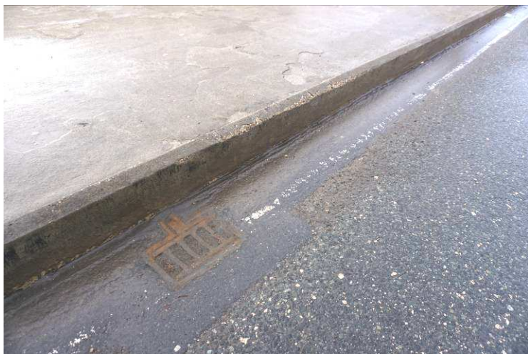
3. 4. képek: Víznyelők eltömődtek, a járdaszegélyről a bevonat erőteljesen hámlik, a járdafelületen a víz több helyen megáll.
