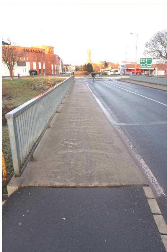
3.4. képek: A híd mindkét végén és mindkét oldalán a csatlakozó járda megsüllyedt. A csatlakozási vonalak mentén nyitott hézagok vannak. A járdafelületekről a járható szigetelés nagyrészt lekopott.
