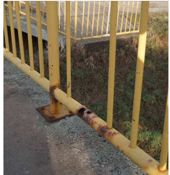
6. 7. képek: A főtartó konzolvégén vízszintes repedés és ferde repedések, a közművezetékek védőcsövei és felfüggesztései erősen korróziósak. Korlát több helyen erősen korrodált, több helyen hiányzó pálcák, a talpak korróziósak, a korlát instabil, balesetveszélyesek.
