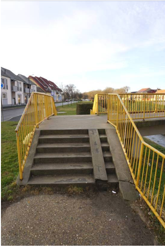
3. kép: Befolyási oldalon a feljárati lépcső tönkrement rámpája.
