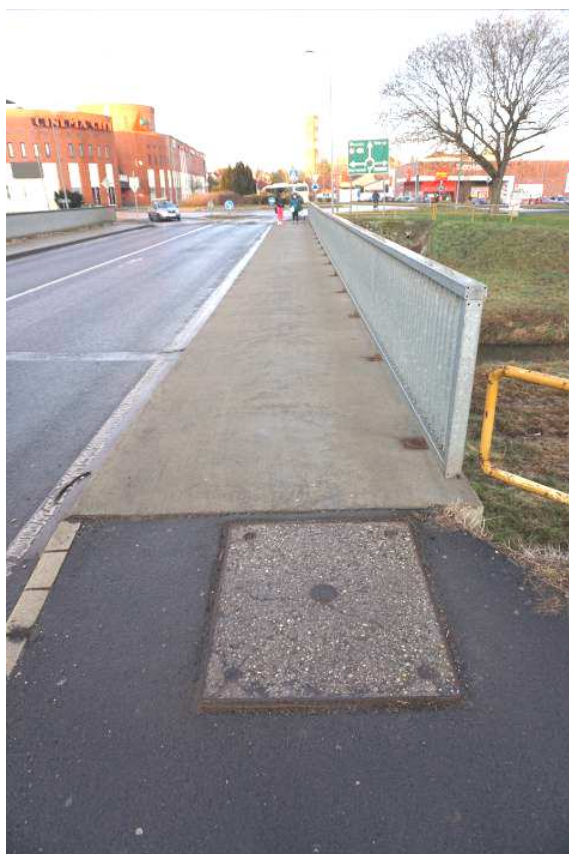
3.4. képek: A híd mindkét végén és mindkét oldalán a csatlakozó járda megsüllyedt. A csatlakozási vonalak mentén nyitott hézagok vannak. A járdafelületekről a járható szigetelés nagyrészt lekopott.
