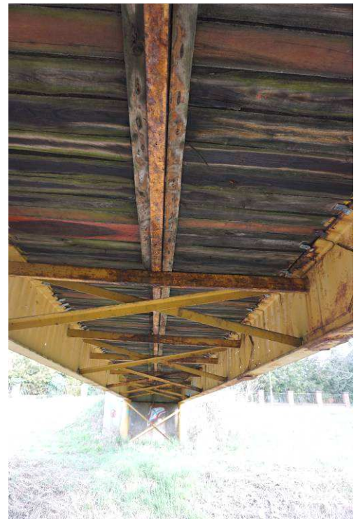
5. 6. képek: A szerkezeti gerenda mögül a hídfőkre folyik a csapadék, azokat áztatja. A hídfő tövében erőteljes növényzet. Az acél gerendák és egyéb acélszerkezetek korróziósak. A faanyag védelme nem megfelelő.
