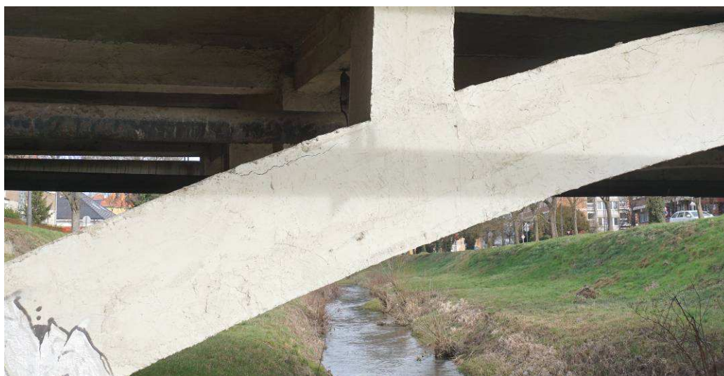
13. kép: A szerkezeteket testközelből vizsgálva több repedés válik láthatóvá, melyeket az előző vizsgálat is leírt.
