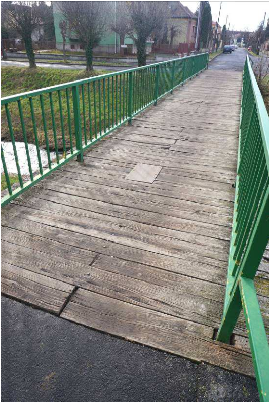
4. kép: Hídfőkön a szerkezeti gerenda erőteljesen megrepedt, ami az acél főtartók dilatációs mozgásának következménye.
