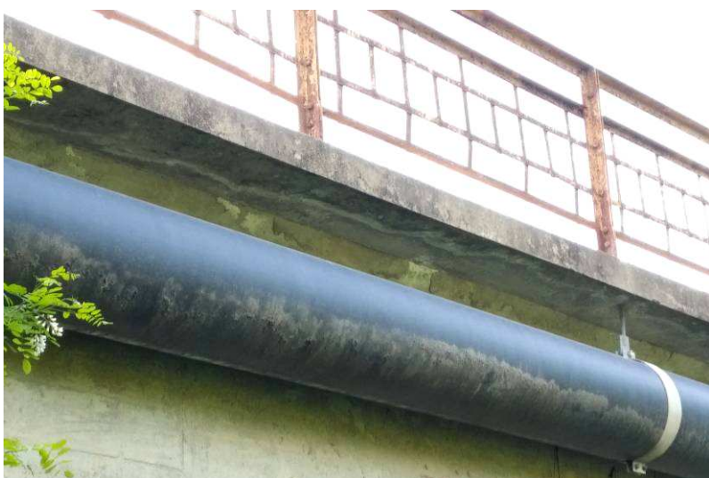
8. kép A járdakonzolra felfüggesztett közmű a híd karbantartását illetve felújítását akadályozza, mert túl közel van a szerkezethez. A járdakonzolon átfúrt rögzítések mentén a csapadék a szerkezetbe jut, károsodást okozva. A járdakonzolon nincs vízzel kiképzés, ezért a csapadék a konzol alsó síkjára és a felszerkezet aljára csorog.
