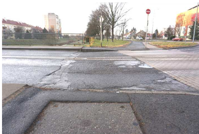
5. 6. képek: A járdán keresztirányú repedések, a beton és a bevonat hámlik, erőteljes acélkorrózióra utaló foltok vannak. A korláttalpknál erőteljes korrózió figyelhető meg. Áruház felőli háttöltés erőteljesen megsüllyedt, a két csatlakozó járdával együtt. A csatlakozó aszfaltburkolat tönkre ment. Az útburkolat a hídon hosszirányban repedezett.
