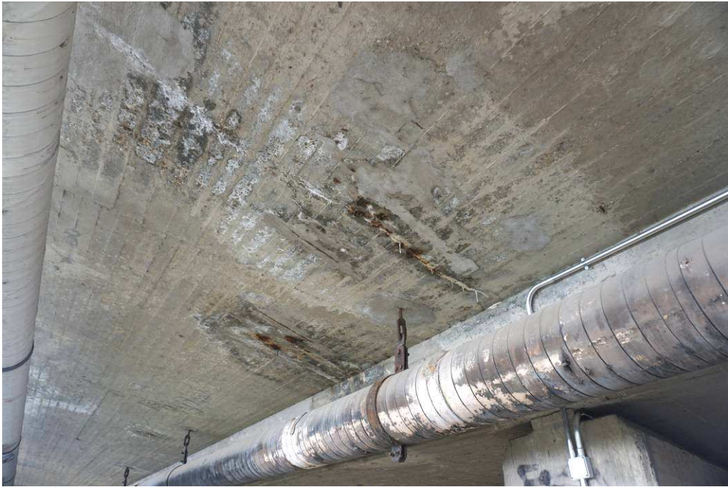
13. 14. képek: Lásd a 12. és 13. képeknél leírtakat. Az alépitmény – közműcsatlakozásnál vízfolyások nyomai vannak.
