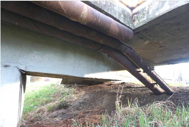
6. 7. képek: A főtartó konzolvégén vízszintes repedés és ferde repedések, a közművezetékek védőcsövei és felfüggesztései erősen korróziósak. Korlát több helyen erősen korrodált, több helyen hiányzó pálcák, a talpak korróziósak, a korlát instabil, balesetveszélyesek.
