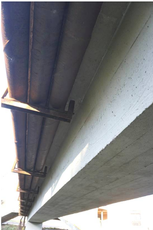
8. 9. képek: A főtartó megfelelő állapotú, a támaszok mögötti konzolos szakaszain repedések láthatók. A konzolok alsó síkján elszórtan korróziós pontok és cementpéphiány látható. A konzolvégeken sok helyen betonleválás és korróziós foltok ill. betonacélok láthatók.
