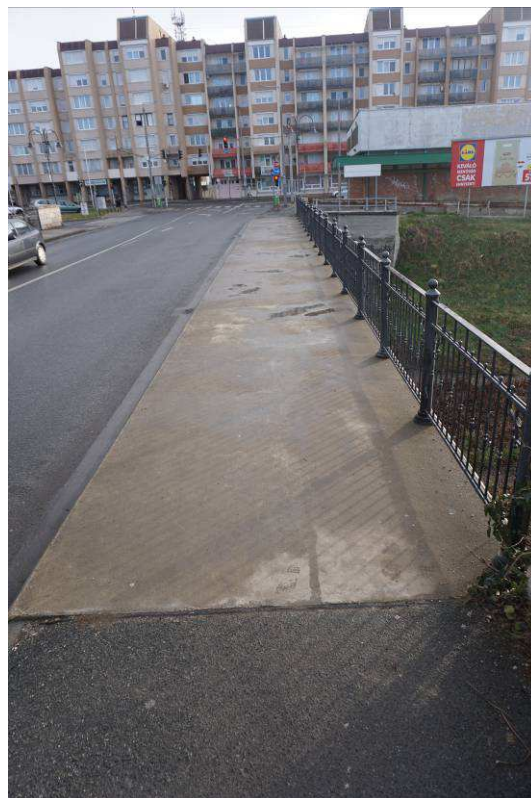
3. 4. képek: Víznyelők eltömődtek, a járdaszegélyről a bevonat erőteljesen hámlik, a járdafelületen a víz több helyen megáll.
