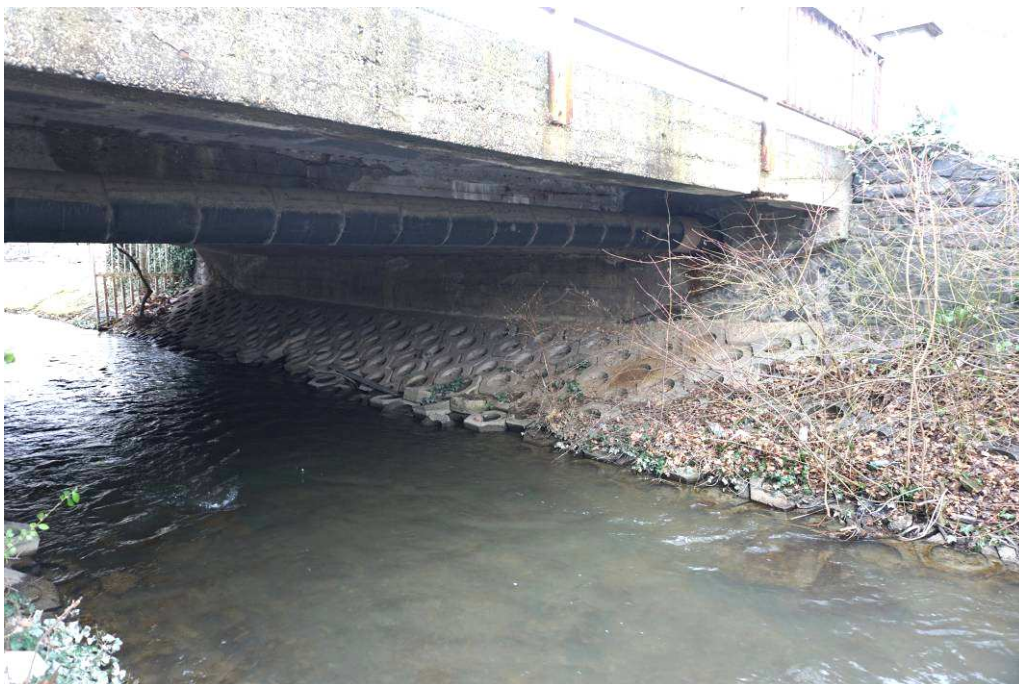
5. 6. 7. képek: A híd oldalán korróziós lefolyások, betonhámítások, korróziós betonacélok, cementpép hiányos felület, korróziós acélkorlát látható. A rézsűburkolat elemei kimozdultak.
