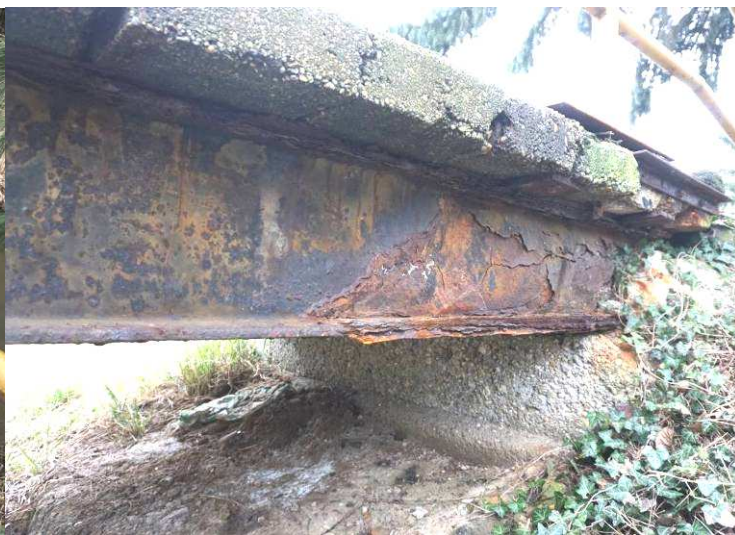
4. kép: Az acél főtartók korrodáltak, különösen a felfekvéseknél. A hídfők betonfelülete cementpép hiányos.
