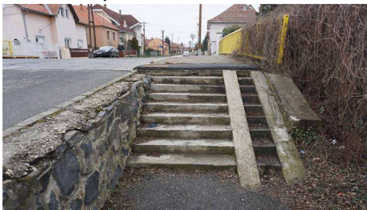
7. 8. képek: A híddal csatlakozó lépcső bevonata nagy felületen levált. A járdacsatlakozásnál megjelent a növényzet. A korlátra erősen ránőtt a futónövényzet. Kifolyási oldal.
