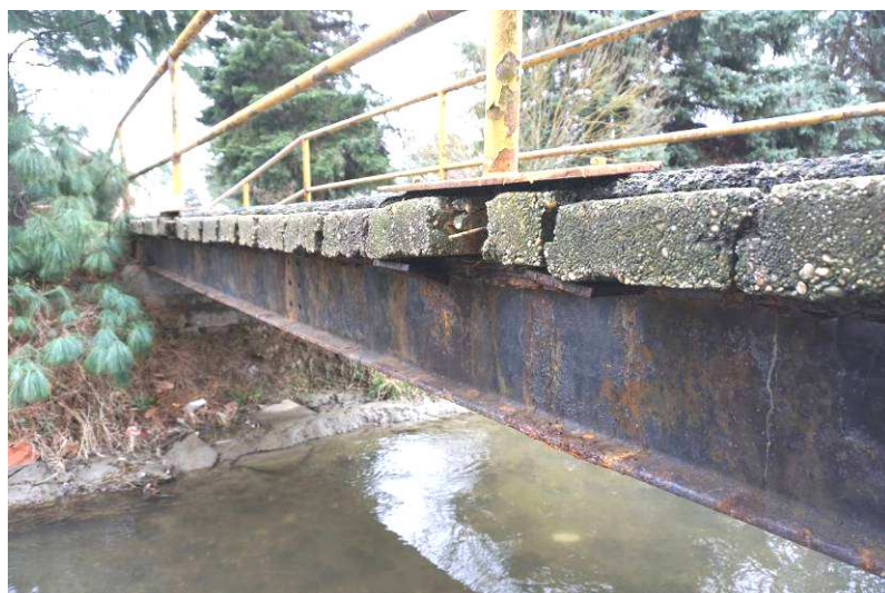
4. kép: Az acél főtartók korrodáltak, különösen a felfekvéseknél. A hídfők betonfelülete cementpép hiányos.
