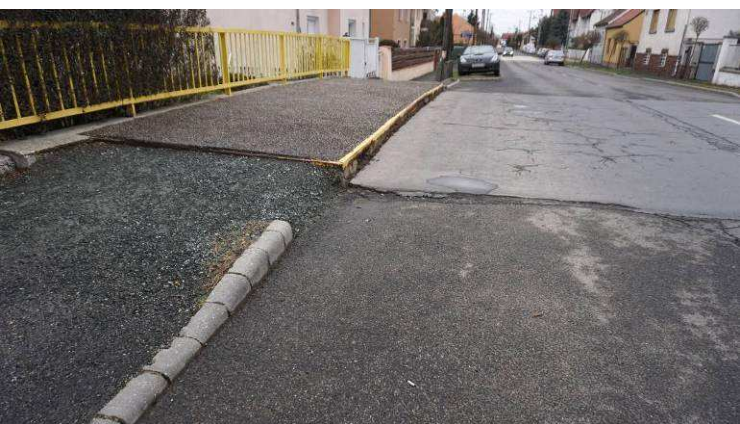
7. 8. képek: A híddal csatlakozó lépcső bevonata nagy felületen levált. A járdacsatlakozásnál megjelent a növényzet. A korlátra erősen ránőtt a futónövényzet. Kifolyási oldal.
