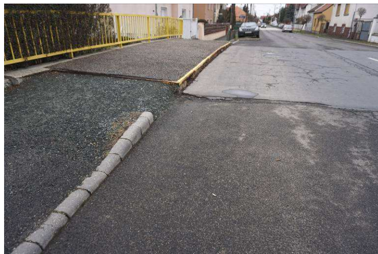
5. 6. képek: A szegély élvédő szögacéljai korróziósak, deformálódtak, a szegély tövében tömítés nem megfelelő, a víz a szerkezetbe jut. A csatlakozó járda aszfaltja morzsalékos, szegélye hiányos, nem egy szintben csatlakozik a híddal, balesetveszélyes. A háttöltés megsüllyedt. A korláttalpakon kezdődő korróziós nyomok. Befolyási oldal.
