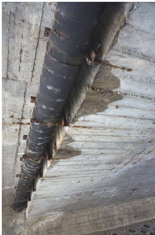
11. 12. kép: Kifolyási oldal szegélygerendán a leázások következtében nagy fokú betonleválás, acélkorrózió figyelhető meg. A járda alatti lemezen keresztirányú repedések, meszes kiválásokkal. A felszerkezet ezen az oldalon is koncentráltan leázik. A közmű szabálytalan átvezetése miatt a hídvizsgálat és a felszerkezet javítása ellehetetlenül. A csővezetékek rögzítései korrodáltak, hiányosak.
