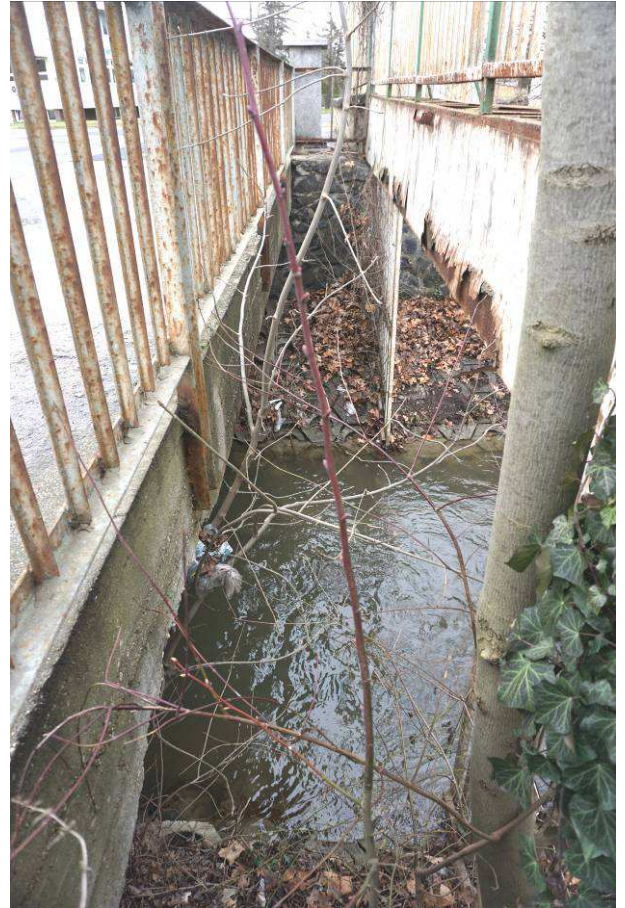
5. 6. 7. képek: A híd oldalán korróziós lefolyások, betonhámítások, korróziós betonacélok, cementpép hiányos felület, korróziós acélkorlát látható. A rézsűburkolat elemei kimozdultak.
