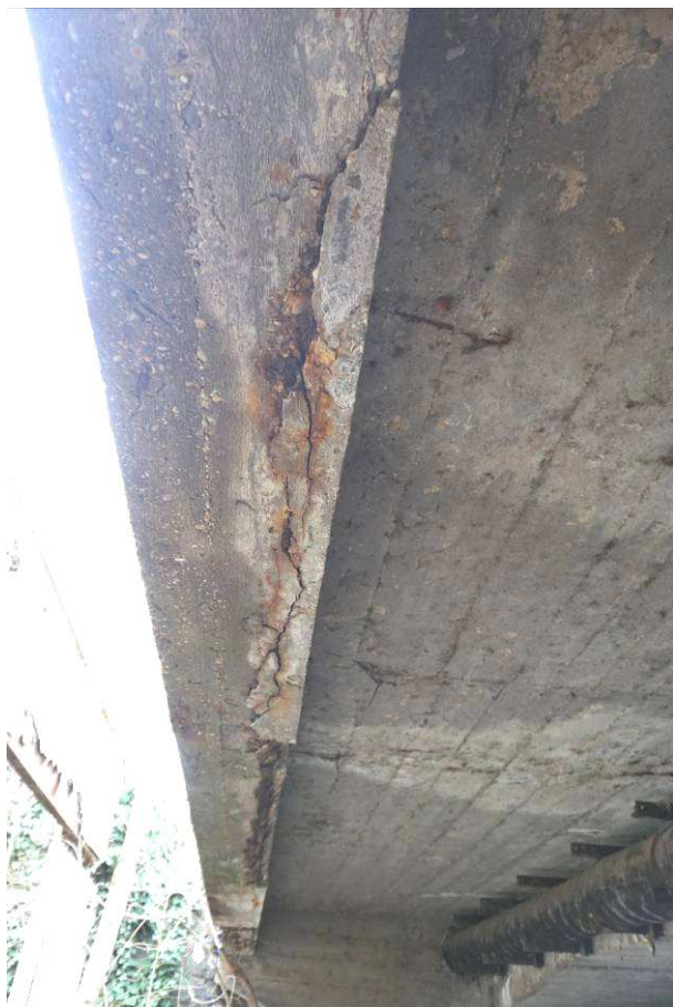
11. 12. kép: Kifolyási oldal szegélygerendán a leázások következtében nagy fokú betonleválás, acélkorrózió figyelhető meg. A járda alatti lemezen keresztirányú repedések, meszes kiválásokkal. A felszerkezet ezen az oldalon is koncentráltan leázik. A közmű szabálytalan átvezetése miatt a hídvizsgálat és a felszerkezet javítása ellehetetlenül. A csővezetékek rögzítései korrodáltak, hiányosak.
