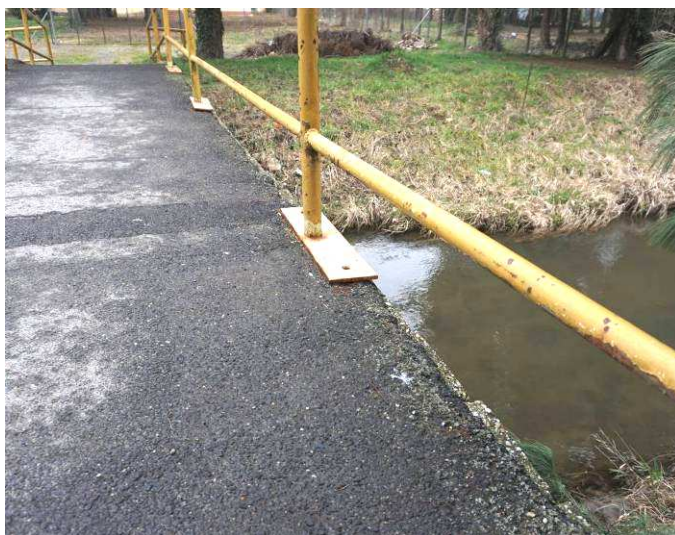
3. kép: A korlát rögzítése instabil, balesetveszélyes. Az aszfalt repedezett, vízáteresztő.
