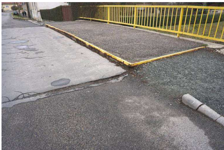
5. 6. képek: A szegély élvédő szögacéljai korróziósak, deformálódtak, a szegély tövében tömítés nem megfelelő, a víz a szerkezetbe jut. A csatlakozó járda aszfaltja morzsalékos, szegélye hiányos, nem egy szintben csatlakozik a híddal, balesetveszélyes. A háttöltés megsüllyedt. A korláttalpakon kezdődő korróziós nyomok. Befolyási oldal.
