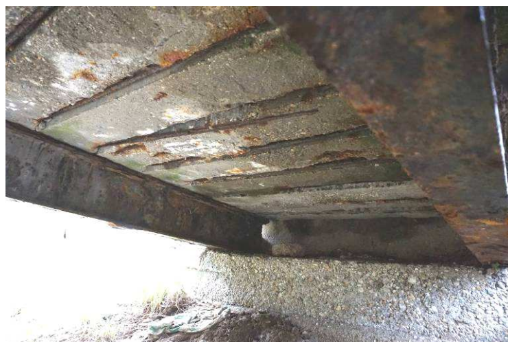
6. 7. kép: A pályalemez előregyártott elemei korróziósak, a betonfedés több helyen levált, kilátszanak a korróziós betonacélok. Az acél főtartók erősen korrodáltak. A hídfőkön vízfolyások nyomai vannak. A hídfők felülete fészkes, cementpép hiányos.
