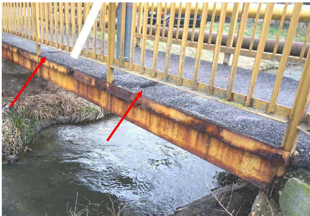
4. kép: A vizsgálat idején a beszakadás és aszfalthiányok helye a hídon. A főtartó és oldallemezek korróziója ezen az oldalon is jelentős.
