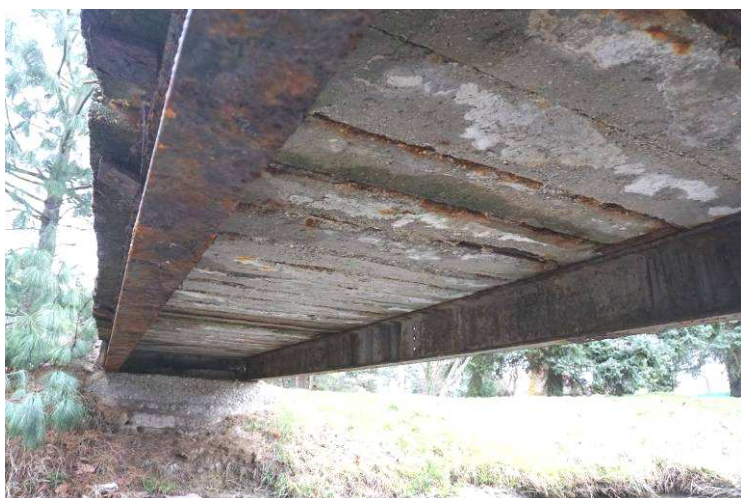
6. 7. kép: A pályalemez előregyártott elemei korróziósak, a betonfedés több helyen levált, kilátszanak a korróziós betonacélok. Az acél főtartók erősen korrodáltak. A hídfőkön vízfolyások nyomai vannak. A hídfők felülete fészkes, cementpép hiányos.
