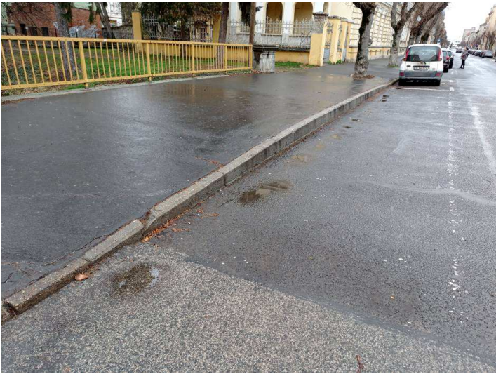
3. kép: Kocsipálya aszfaltburkolata jó állapotú, de a szegélyek mellett nincs öntött aszfalt ék, a rugalmas tömitések megsüllyedtek. A szegélyektől ~20cm-re helyi mélypontok vannak az aszfaltban. Járda öntött aszfalt felülete helyenként púpos és repedezett.
