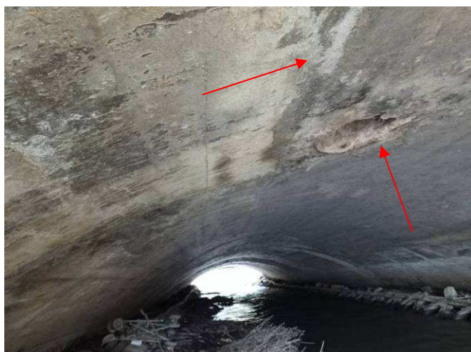
11. 12. képek: A boltívben erőteljes keresztirányú repedések és leázások jelentkeztek. A használaton kívüli közműejtőcsövek nyílásai a boltív teherbírását gyengítik. A nyílások környezetében repedések vannak.
