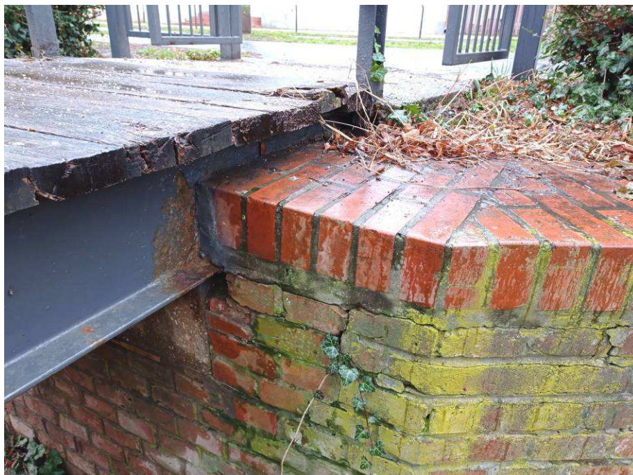
3. kép: Az I tartók a felfekvésénél korrodáltak, a pallók végei korhadásnak indultak, a töltéslezáró falon a növényzet megtelepedett, a fugák kiperegnek.
