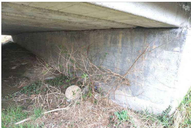
12. 13. képek: A Gyöngyös - patak nyílásában a hídfőn lefolyásnyomok, a kiegyenlítő lemezre lehajtott szigetelés tönkrement, így a szerkezetbe jut a csapadék. A mederburkolatot a növényzet helyenként erősen benőtte. A mederburkolat megbomlott, a leváló darabok akadályt képeznek, a hordalék lerakódott. A hídfő élvédő szögvasánál a beton megrepedt, mellette betonhiányos felület alakult ki.
