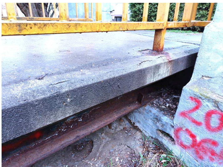
3. kép: A járófelület bevonatán lokális leválások és repedések láthatók. A korlátozszlopok alsó része erősen korróziósak, a korlát többi részén is foltokban korrózió tapasztalható.
