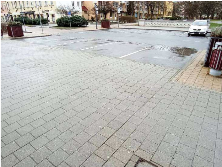
3. kép: A járdafelület állapota megfelelő, de a pályaszerkezet vízszigetelése kérdéses. A parkolóban nagy tócsában áll a víz, tehát a megfelelő vízvezetés nincs kialakítva.
