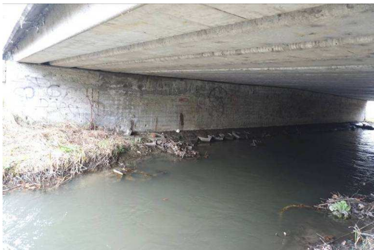
10. 11. képek: A Gyöngyös - patak nyílásában a mederburkolat megbomlott, a közbenső pilléren meszes lefolyásnyomok, kilátszó korrodált betonacélok láthatók.
