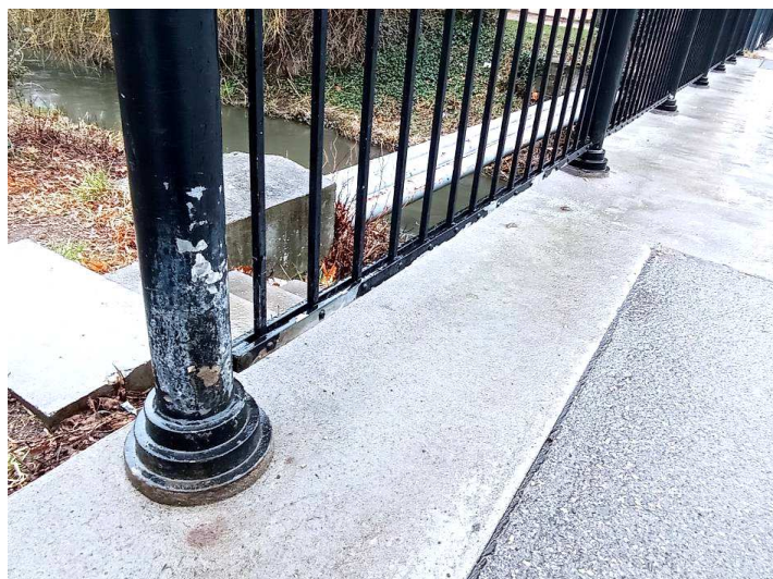
4. kép: Korlátan a mázolás kisebb-nagyobb mértékben kezd lekopni.
