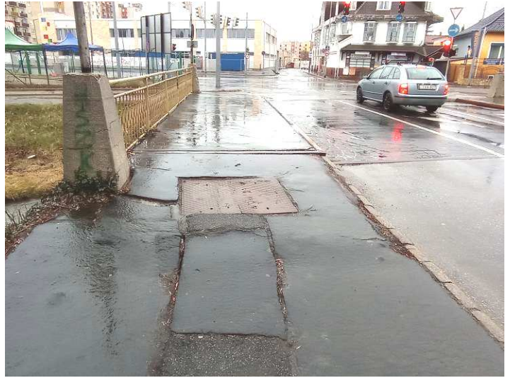
7. 8. képek: Csatlakozó szegélyek és burkolatok megsüllyedtek, repedezettek, hiányosak. A 8. képen a csatlakozó járdaburkolat alatt üregelődés tapasztalható! A közműfedlapok megsüllyedtek, nem vízzáró és botlásveszélyes. Az acélszerkezetek, élvédő szögacélok és korlátok erősen korrodáltak.
