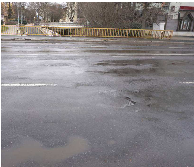
6. 7. képek: A közbenső támasz felett a kocspálya szélességében a burkolaton repedés jelent meg. Itt a csapadék a repedésen keresztül a szerkezetbe folyik. A korlát korróziója jelentős, ezáltal a korlát helyenként hiányos és balesetveszélyes.
