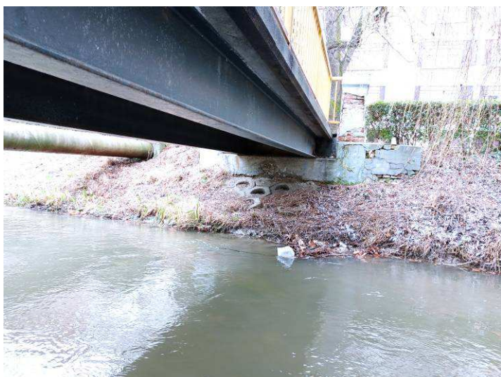
6. 7. kép: Az acél főtartókon kisebb acélkorróziós foltok, a hídfő felfekvéseknél viszont erős korrózió látható. A mederburkolat helyenként megbomlott és megsüllyedt, a hídfőn leázásnyomok, a csatlakozó támfalak tönkrementek. A posztamenseken nagy mértékű károsodás tapasztalható.
