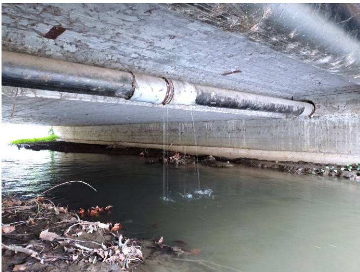
6. kép Felszerkezet alsó felülete jó állapotú. Patak sodorvonala a bal oldali hídfő felé tolódott. A vízközmű meghibásodása miatt a víz sugárban folyik a patakba.
