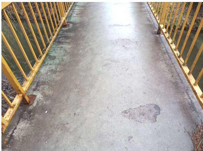
3. kép: A járófelület bevonatán lokális leválások és repedések láthatók. A korlátozszlopok alsó része erősen korróziósak, a korlát többi részén is foltokban korrózió tapasztalható.
