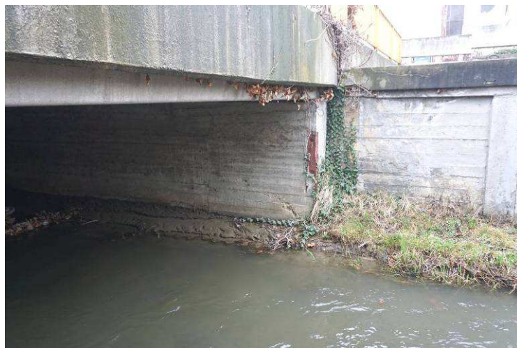
12. 13. képek: A Gyöngyös - patak nyílásában a hídfőn lefolyásnyomok, a kiegyenlítő lemezre lehajtott szigetelés tönkrement, így a szerkezetbe jut a csapadék. A mederburkolatot a növényzet helyenként erősen benőtte. A mederburkolat megbomlott, a leváló darabok akadályt képeznek, a hordalék lerakódott. A hídfő élvédő szögvasánál a beton megrepedt, mellette betonhiányos felület alakult ki.
