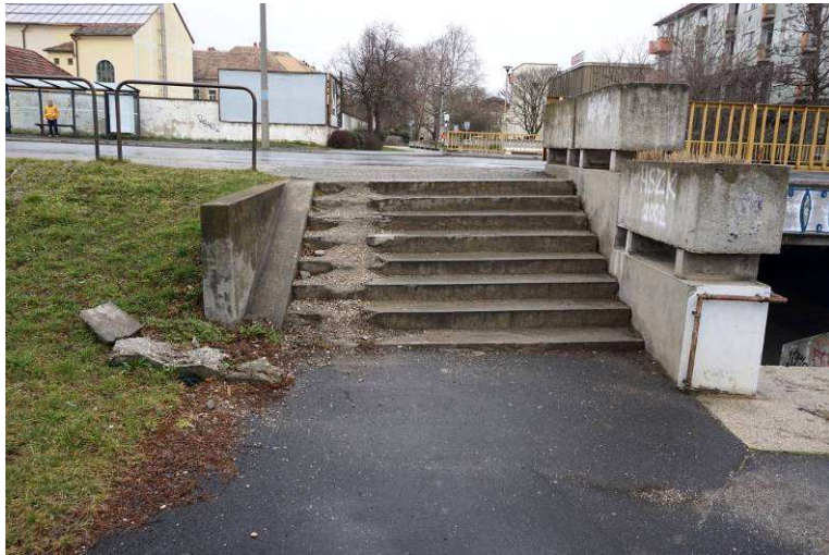
14. kép: A lépcső rámpa része tönkrement. A bontási törmelék a helyszínen maradt, így a lépcső balesetveszélyes.
