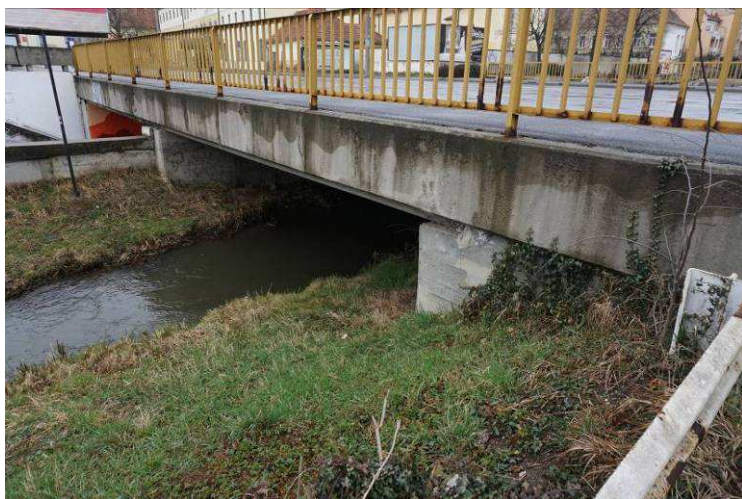
8. 9 képek: Kifolyási oldal. Az oldalszegélyen a bevonat hámlik, a szélső gerenda felfekvésnél lefolyásnyomok vannak, és betonleválások, korróziós betonacél látható. A szegélyeken függőleges repedések alakultak ki, melyek alján mészkőcsapok képződtek.
