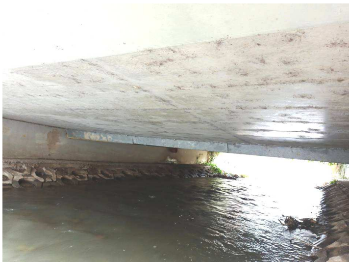
5. kép: A csapadékcsatorna bekötés vize a hídfőt nedvesíti. A rézsűburkolat helyenként megbomlott, hiányos.
