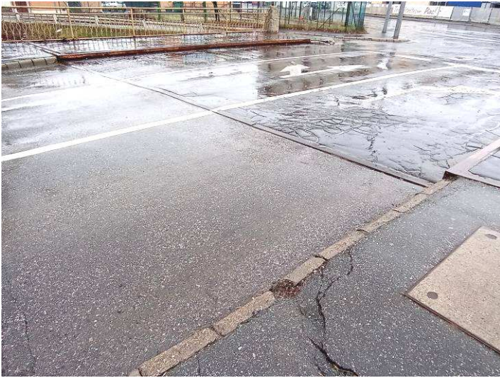
7. 8. képek: Csatlakozó szegélyek és burkolatok megsüllyedtek, repedezettek, hiányosak. A 8. képen a csatlakozó járdaburkolat alatt üregelődés tapasztalható! A közműfedlapok megsüllyedtek, nem vízzáró és botlásveszélyes. Az acélszerkezetek, élvédő szögacélok és korlátok erősen korrodáltak.
