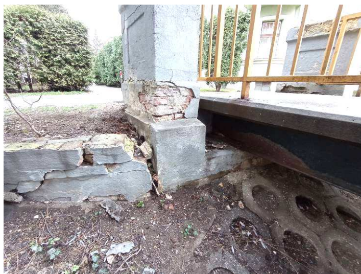
6. 7. kép: Az acél főtartókon kisebb acélkorróziós foltok, a hídfő felfekvéseknél viszont erős korrózió látható. A mederburkolat helyenként megbomlott és megsüllyedt, a hídfőn leázásnyomok, a csatlakozó támfalak tönkrementek. A posztamenseken nagy mértékű károsodás tapasztalható.
