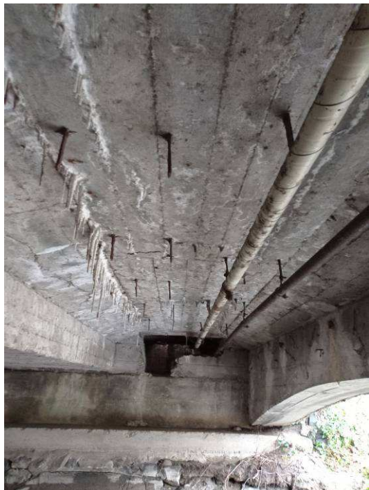
9. 10. képek: Hídfő felületén tömítetlen közműáttörés, monolit vasbeton pályalemez oldalsíkján vízfolyás, a betonfedés hiányos, a látszó betonacélok korrodáltak. Járdá monolit vasbeton lemez alsó síkja ázik, felületén jelentős a repedezettség és a mészkiválás, mészkőcsapok.
