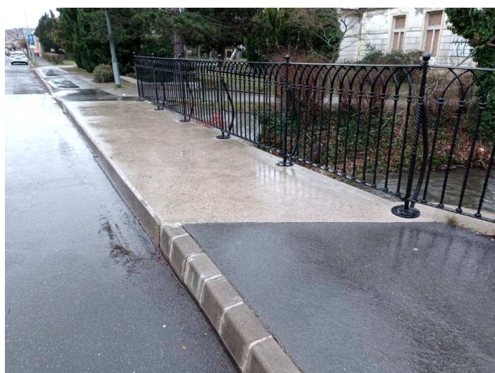
7. kép: A vágásban helyi mélypontok figyelhetők meg, ahol a víz egy része megáll. Korlátok állapota megfelelő.
