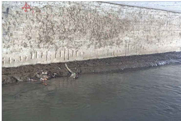
10. 11. képek: A Gyöngyös - patak nyílásában a mederburkolat megbomlott, a közbenső pilléren meszes lefolyásnyomok, kilátszó korrodált betonacélok láthatók.
