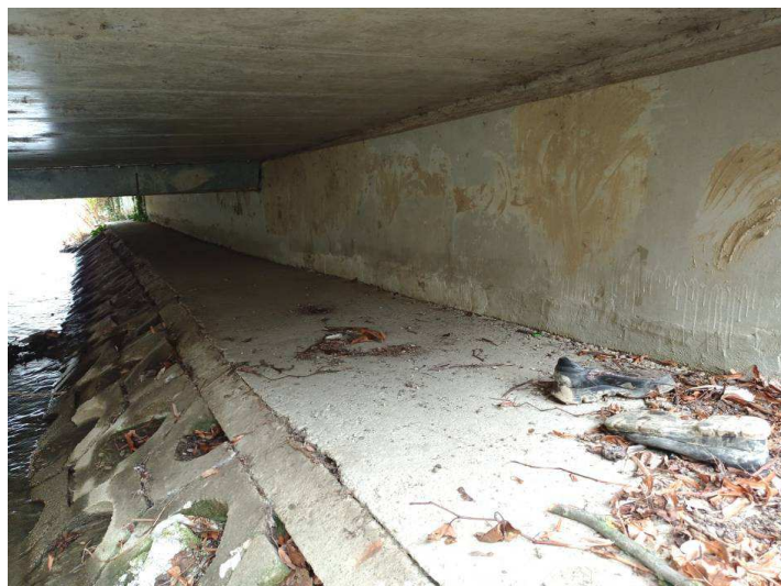
6. kép: A felszerkezet és a hídfő ép.
