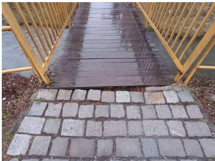
3. 4. kép: A hídhöz csatlakozó járdáknál a háttöltés megfelelő lezárása nincs megoldva, ezért a kockakövek megsüllyedtek, és elcsúsztak. A híd egyes járópallóin kezdődő korhadás indult meg az acél főtartók csatlakozása felett. A rögzítésük egy-két helyen meglazult, ezért a járósíkból kiemelkednek. A korlátoszlopok töveinél korrózió alakult ki.
