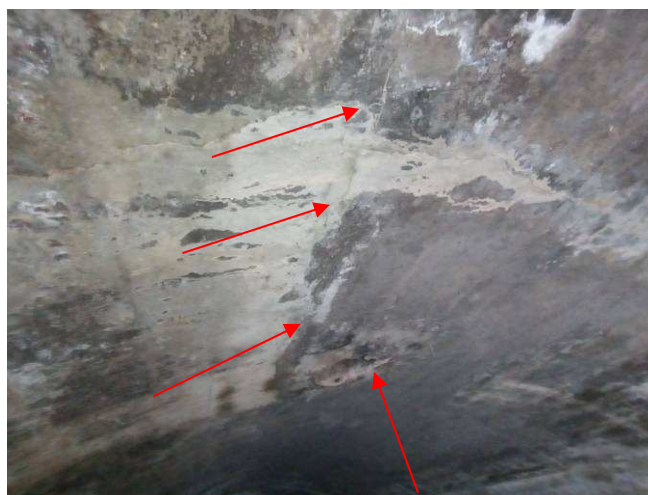
11. 12. képek: A boltívben erőteljes keresztirányú repedések és leázások jelentkeztek. A használaton kívüli közműejtőcsövek nyílásai a boltív teherbírását gyengítik. A nyílások környezetében repedések vannak.
