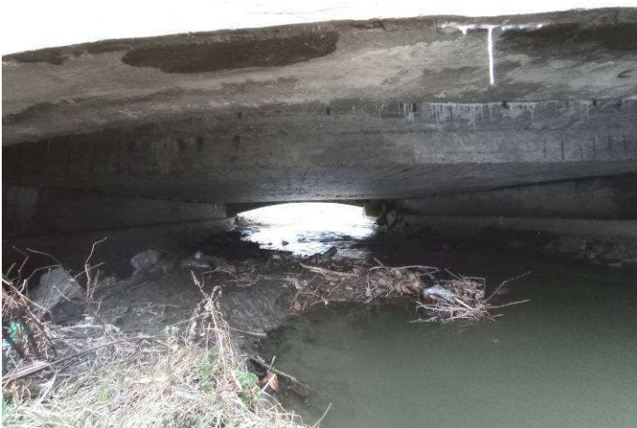
9. 10. képek: Hídfő felületén tömítetlen közműáttörés, monolit vasbeton pályalemez oldalsíkján vízfolyás, a betonfedés hiányos, a látszó betonacélok korrodáltak. Járdá monolit vasbeton lemez alsó síkja ázik, felületén jelentős a repedezettség és a mészkiválás, mészkőcsapok.
