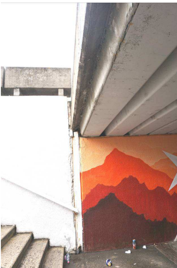
17. kép: A szélső gerendánál erőteljes leázás, betonleválás, bevonat leválás, mészköcsap képződés a vízorron.
