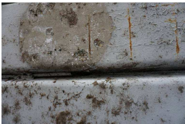
19. kép: A felszerkezet gerendáin a korróziós kengyelek átrajzolódnak. A gerenda alsó síkján Hosszirányú repedés rajzolódik ki.
