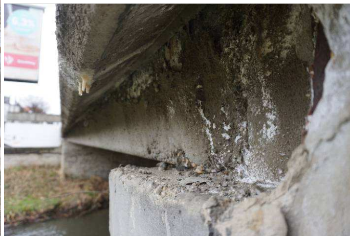
8. 9 képek: Kifolyási oldal. Az oldalszegélyen a bevonat hámlik, a szélső gerenda felfekvésnél lefolyásnyomok vannak, és betonleválások, korróziós betonacél látható. A szegélyeken függőleges repedések alakultak ki, melyek alján mészkőcsapok képződtek.
