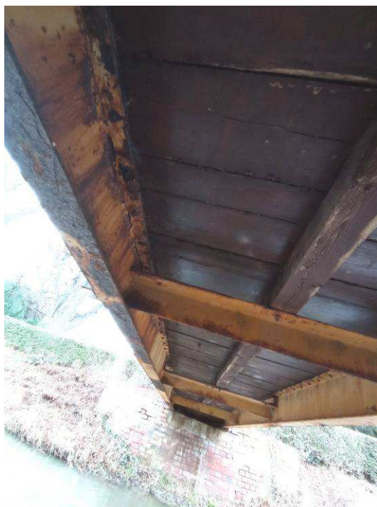
4. 5. kép: A csak külső oldalán átfestett I tartókon átüt a rozsda. Az alsó és belső felületek a felújítás során érintetlenek maradtak, így azokon erősen korróziós felületek láthatók.
