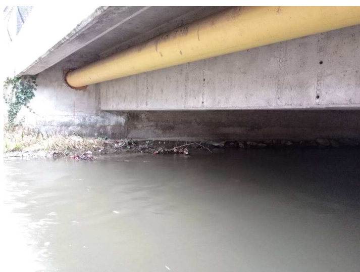
5. kép: A hídfők végein erőteljes leázások tapasztalhatók, melyek a munkahézagokon jelennek meg.
