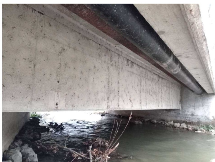
5. kép: Mederben uszadék van a híd alatt. A felszerkezet állapota jó.
