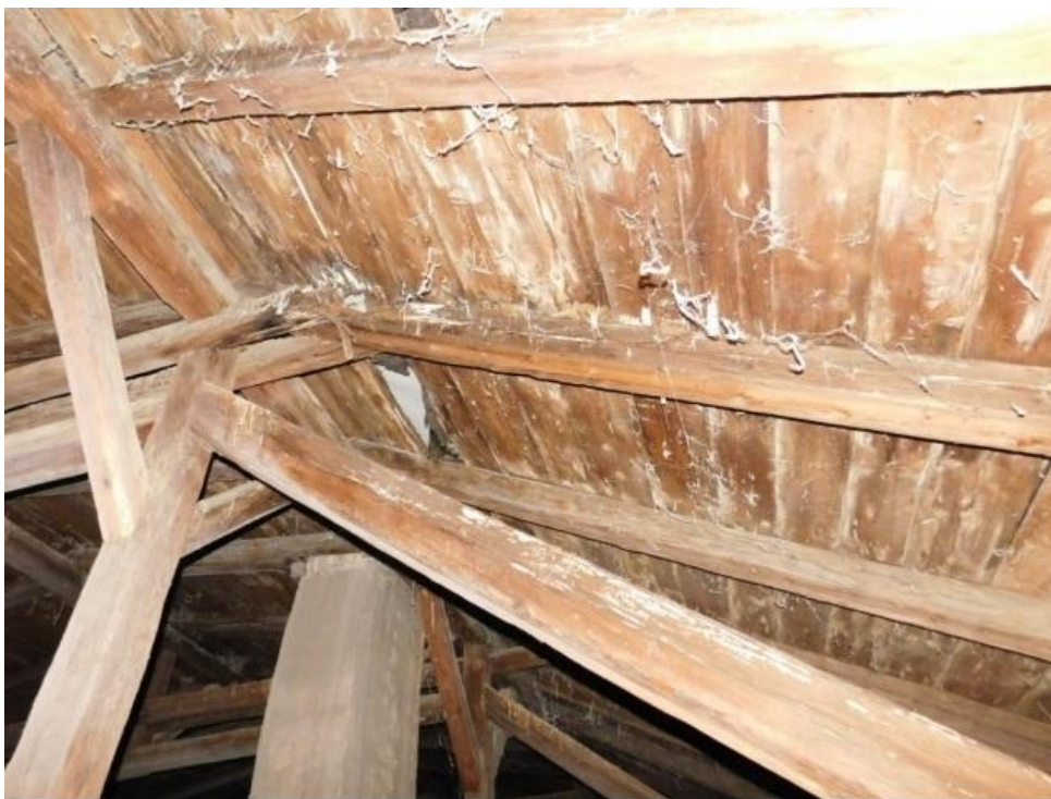
Tartósan beázó tetőszerkezet, aktív házi kéreggomba károsítások
