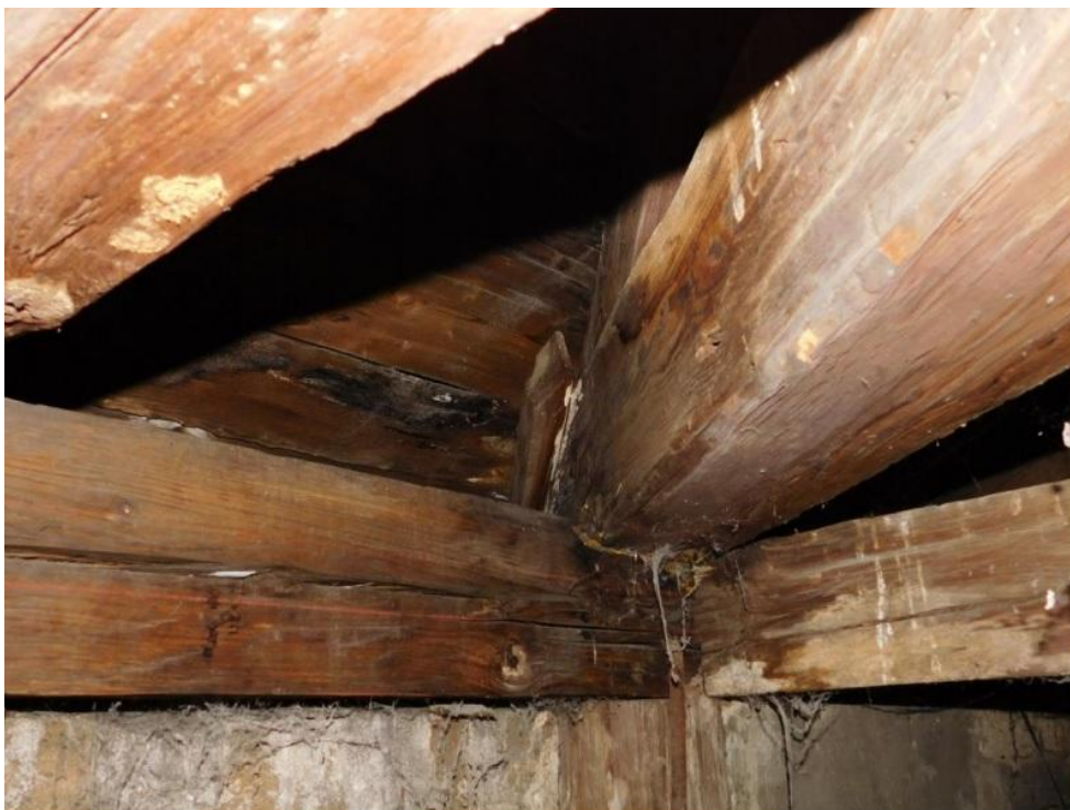
Beázás miatt teljesen szétkorhadt szerkezeti csomópont
