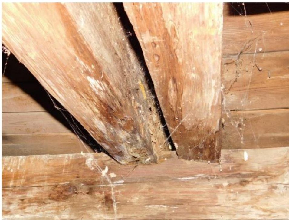
Komplex károsítás fogópárokon, fiókkötő-gerendán
