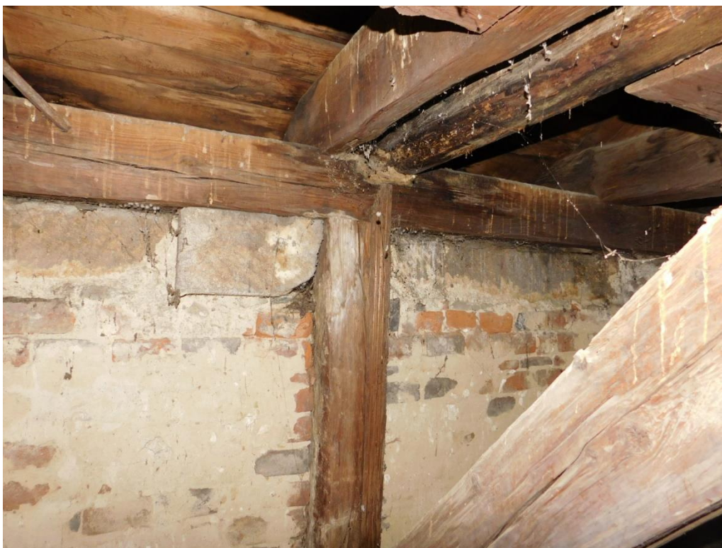
40. ábra: Komplex (gombafertőzés által előre korhasztott anyagot támadta meg a fakárosító rovar) károsítás szerkezeti csomópontban 1
