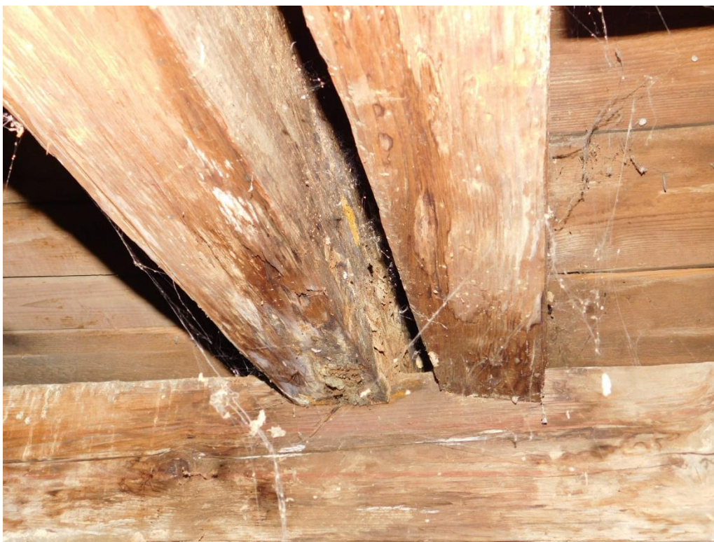
19. ábra: Komplex károsítás fogópárokon, fiókkötő-gerendán
