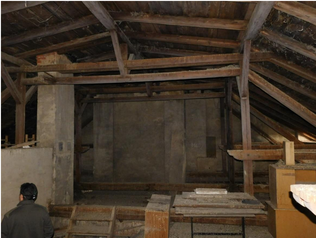
11. ábra: Az épület tetőszerkezetének általános részlete 1
