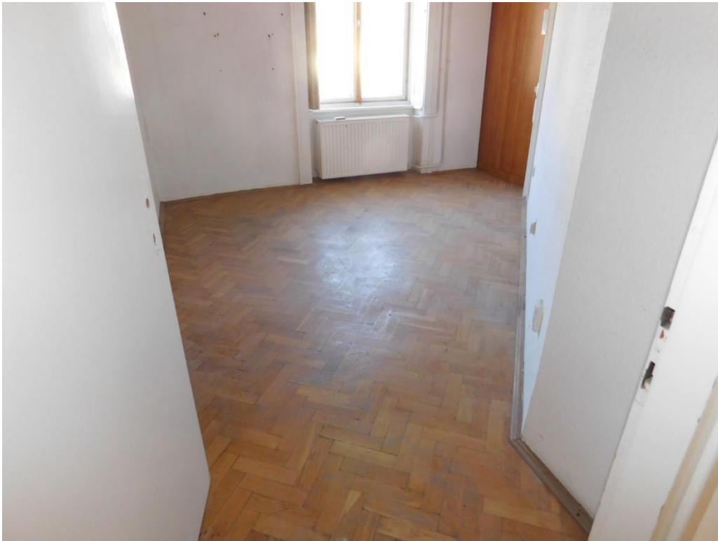
80. ábra: Ép emeleti helyiség enyhén deformált csaphornyos parkettával
