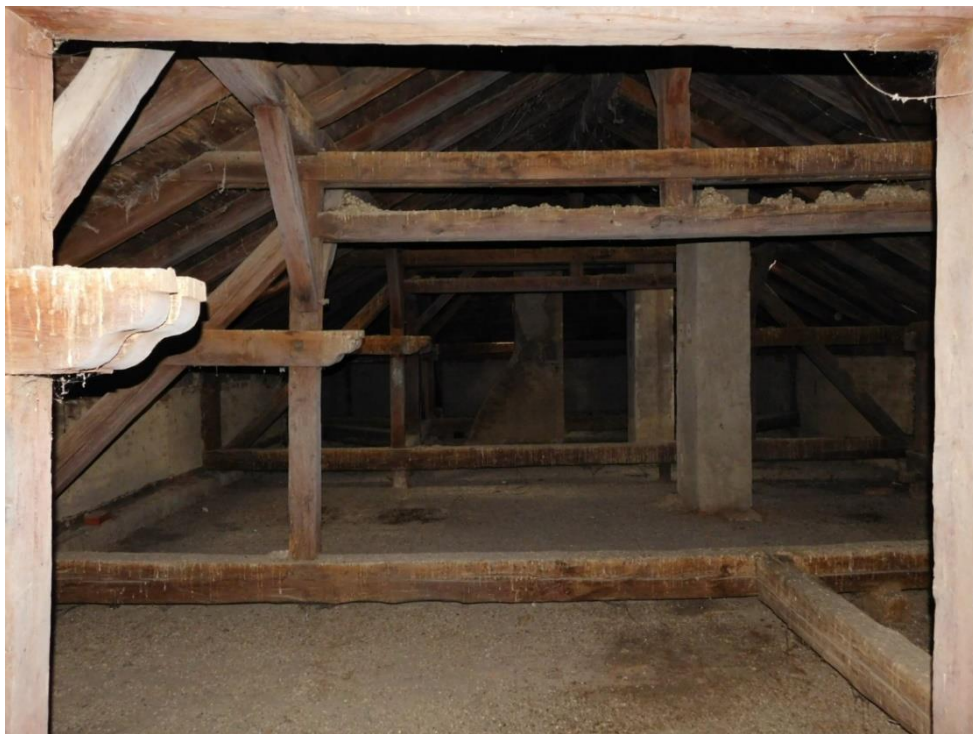
14. ábra: Az épület tetőszerkezetének általános részlete 4
