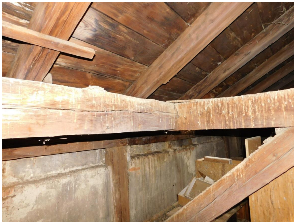
28. ábra: Repedt fiókkötőgerenda
