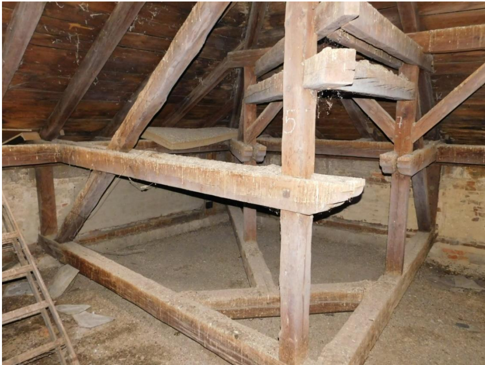
13. ábra: Az épület tetőszerkezetének általános részlete 3
