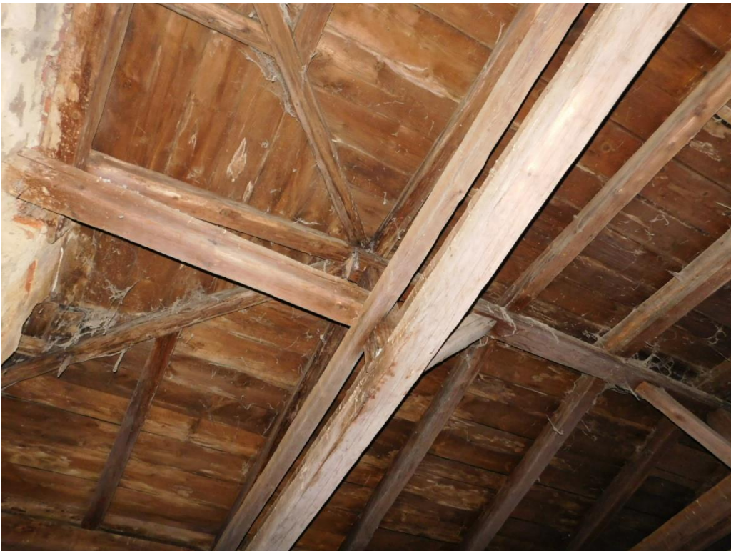
22. ábra: Beázó és korhadt szerkezeti csomópont
