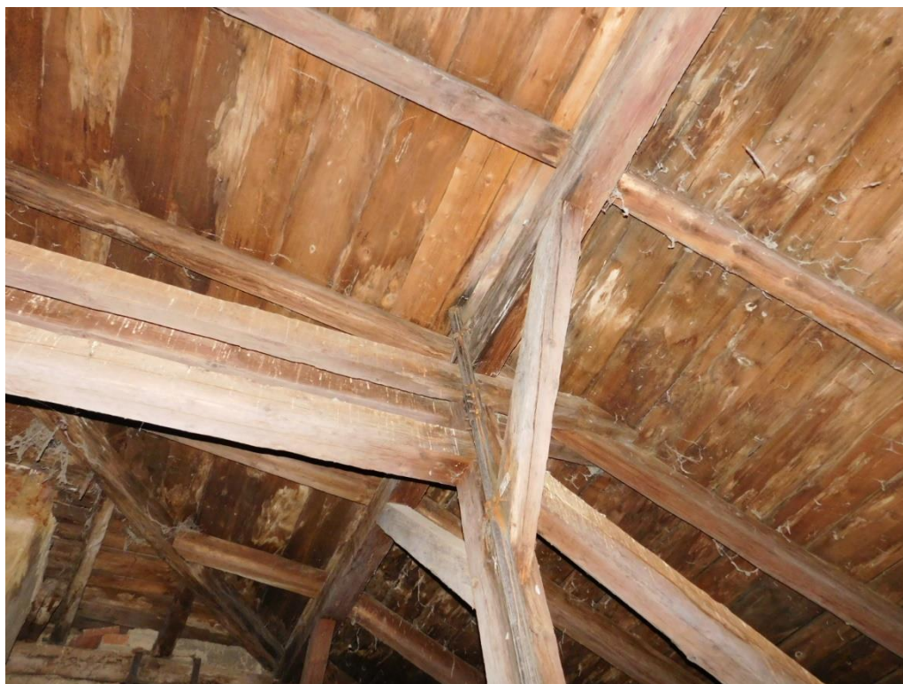
32. ábra: Házi kéreggomba károsítás középszelemenen
