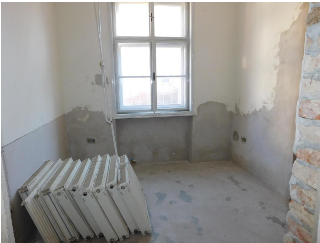
70. ábra: Ép nyílászáró földszinti helyiségben
