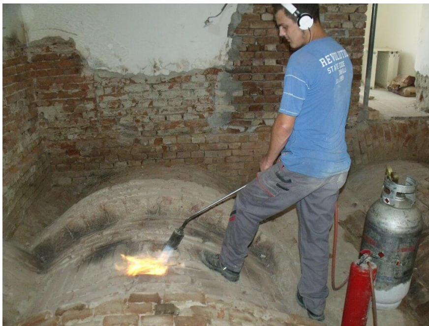
5. ábra: A pince fődém égetéses gombamentesítése 2015-ben a földszint felől
