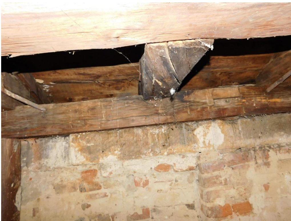
39. ábra: Kifutószálasan repedt fiókgerenda
