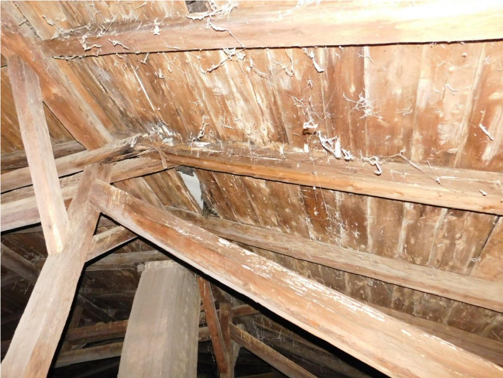
21. ábra: Tartósan beázó tetőszerkezet, aktív házi kéreggomba károsítások
