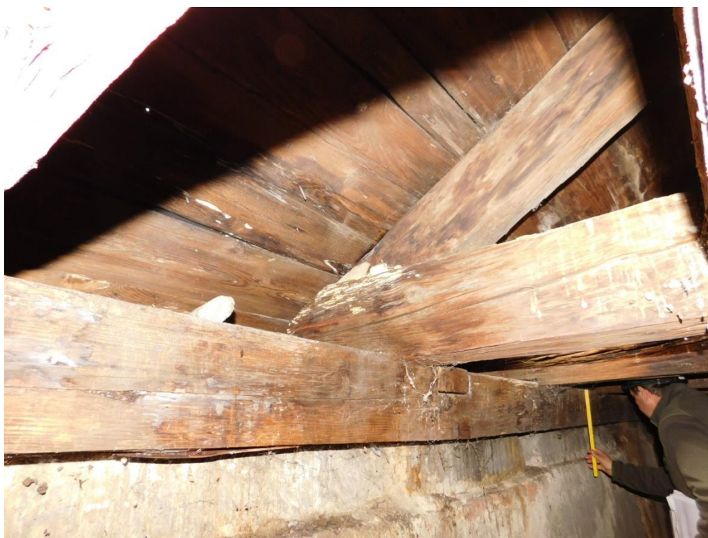
31. ábra: Házi kéreggomba okozta korhadás szerkezeti csomóponton
