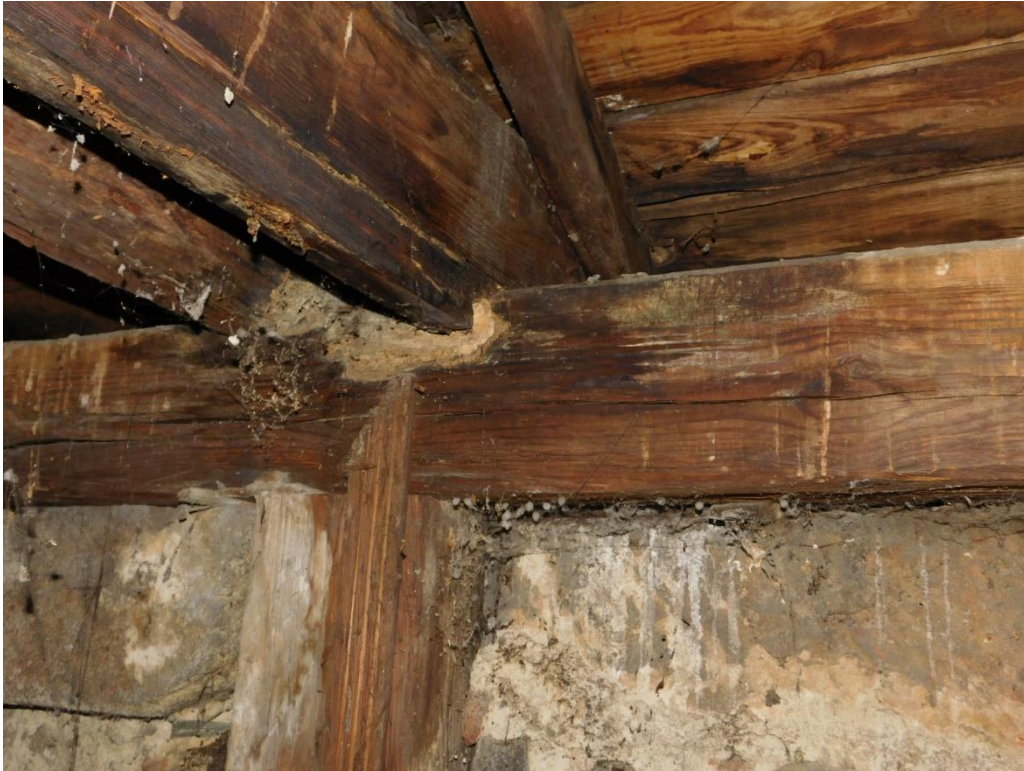
41. ábra: Komplex (gombafertőzés által előre korhasztott anyagot támadta meg a fakárosító rovar) károsítás szerkezeti csomópontban 2
