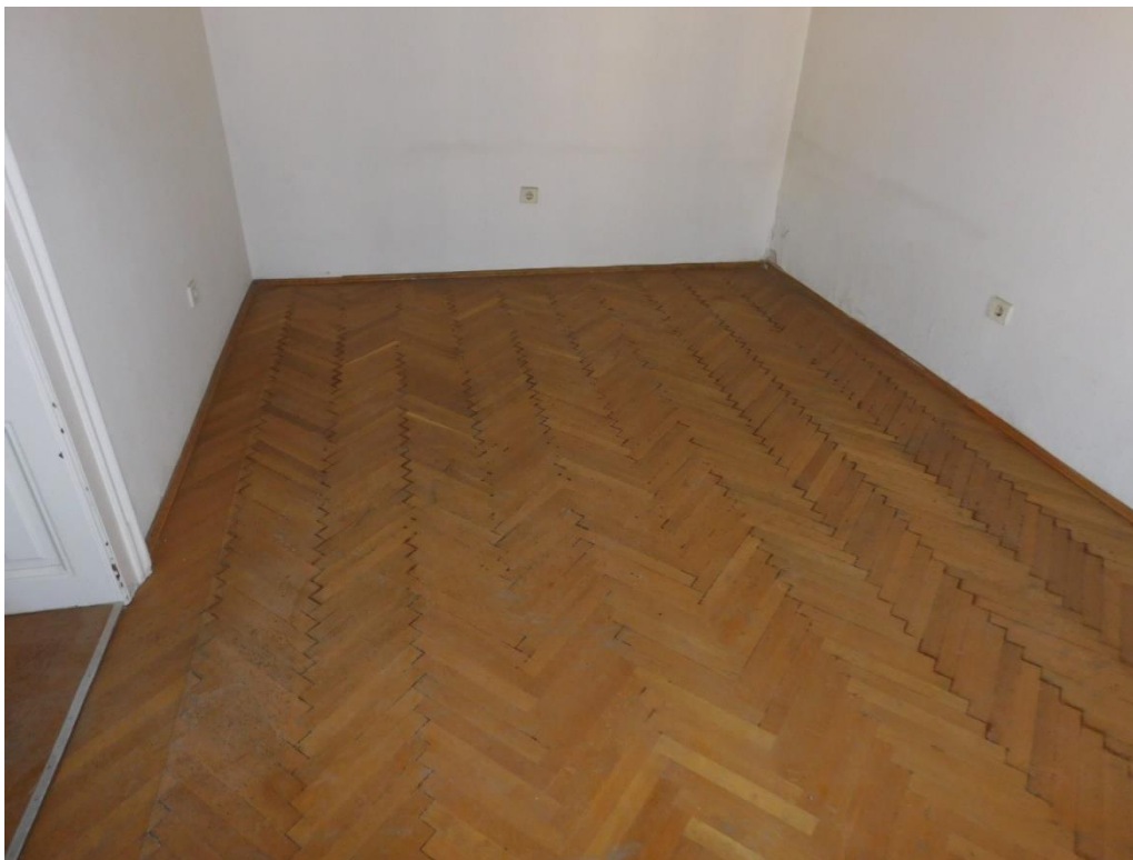
74. ábra: Zsugorodás-dagadással érintett parketta belső átszellőztelen helyiségben 1
