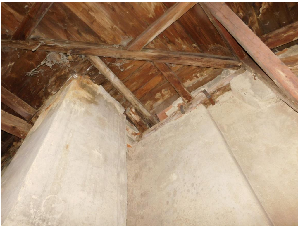
23. ábra: Kémény mellett és a tűzfalba beépített, nem látható szerkezeti elemek
