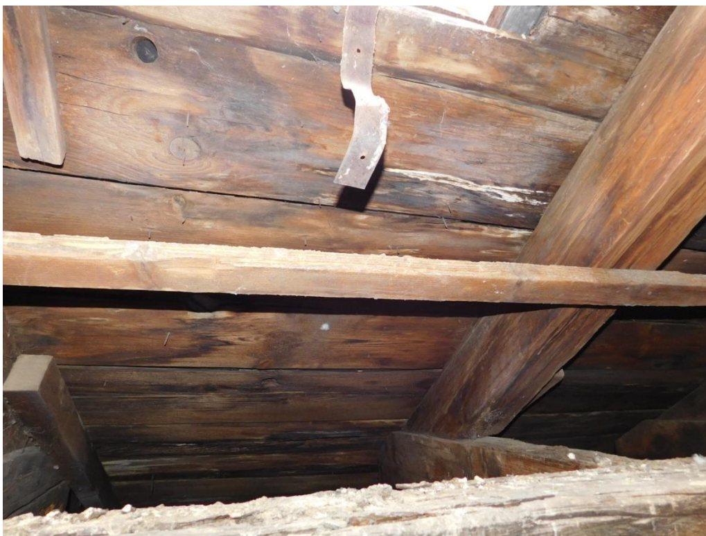
30. ábra: Házi kéreggomba károsítás tetődeszkázaton
