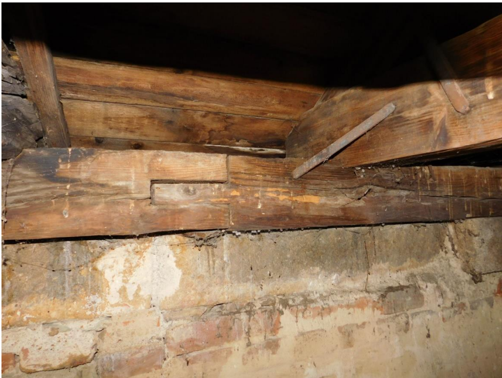
38. ábra: Szétcsúszott hosszoldás, és Házi cincér rágások a sárgerenda-felsőn
