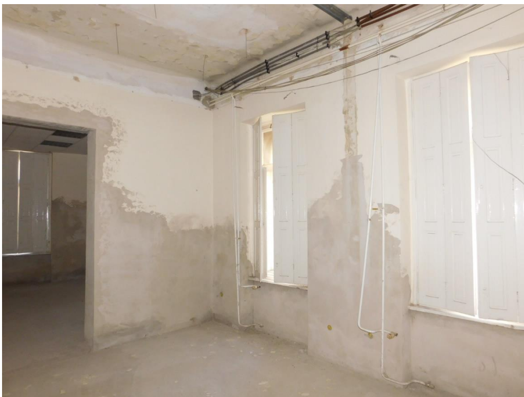
71. ábra: Ép nyílászárók és falazatok földszinti helyiségekben
