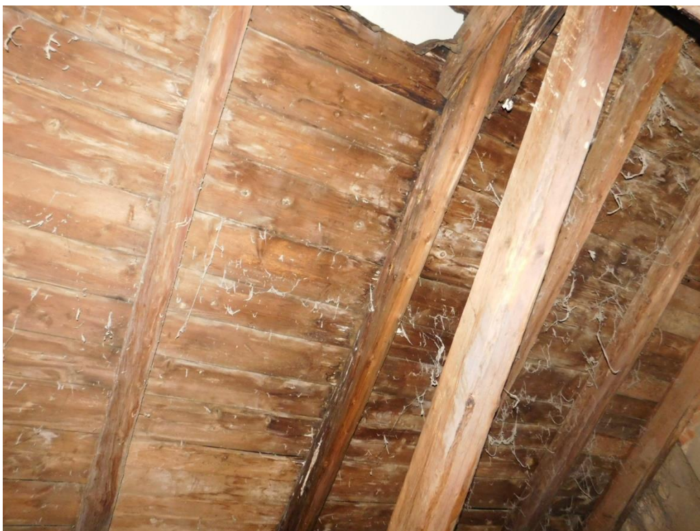
33. ábra: Korhadás miatt hiányzó tetődeszkázat, aktív Házi kéreggomba károsítás szarufán
