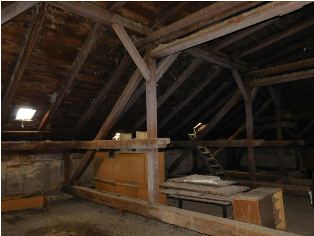
12. ábra: Az épület tetőszerkezetének általános részlete 2
