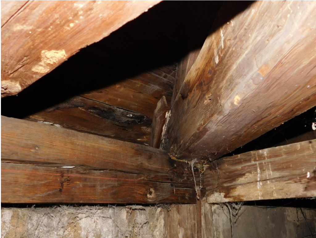
47. ábra: Beázás miatt teljesen szétkorhadt szerkezeti csomópont
