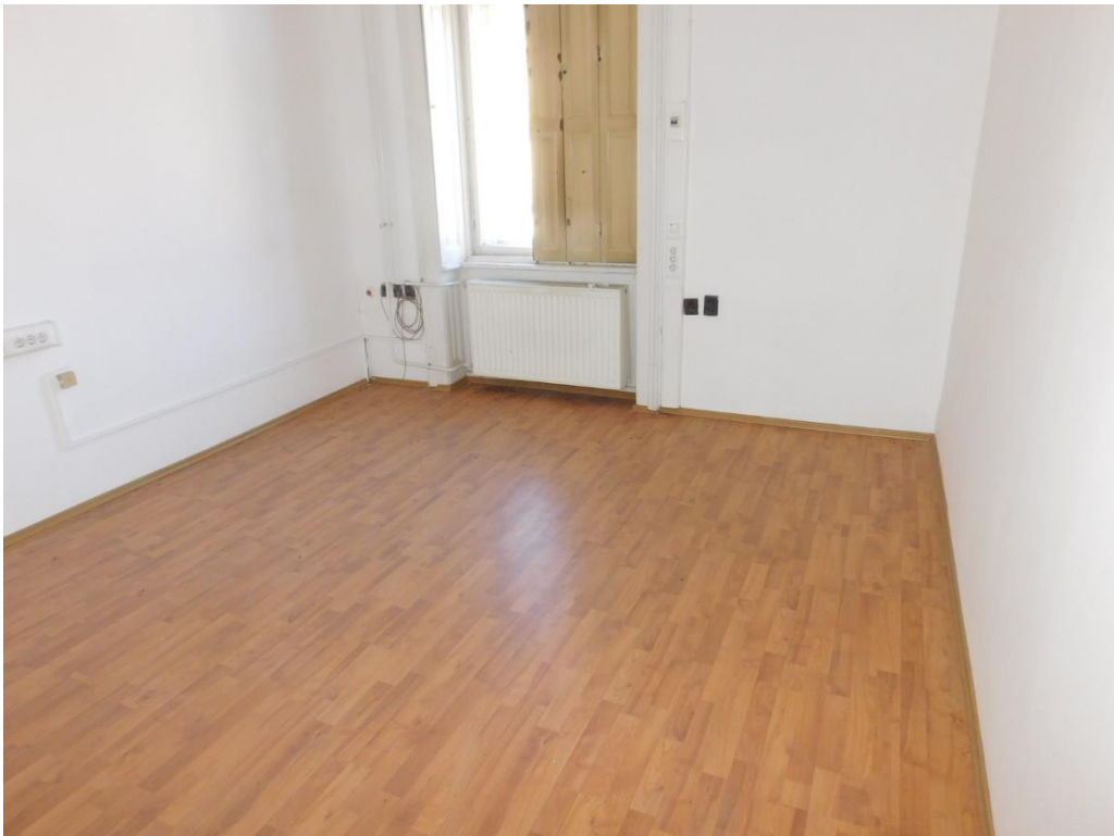
86. ábra: Emeleti ép csaphornyos szalagparkettás helyiség
