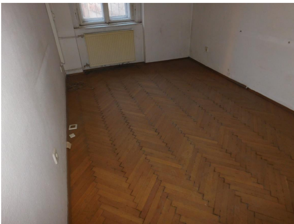
75. ábra: Zsugorodás-dagadással érintett parketta belső átszellőztelen helyiségben 25
