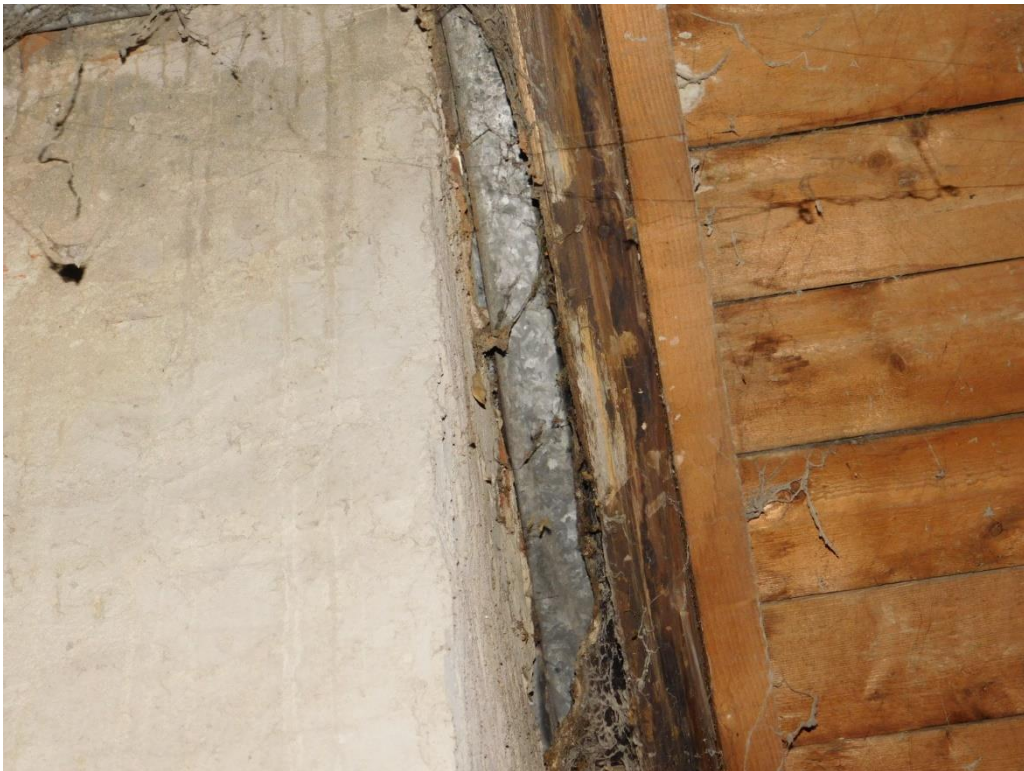
44. ábra: Kémény mellett, a hibás bádogozás miatt beázott, és szétkorhadt szarufa
