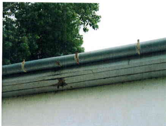
eresz csatorna lukas, deszkázat elkorhadt.
