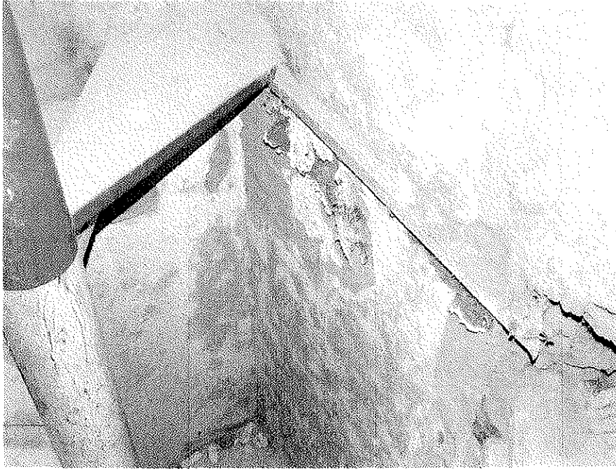
8. ábra Gomba termőtestek az emeletre vezető lépcső melletti falazaton (kapcs. 7. ábra)
