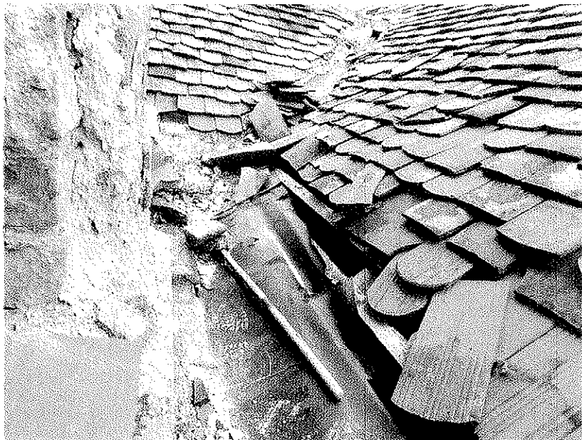
7. ábra Tönkrement tetőburkolat és ereszcatorna az emeleti helyiség külső falzatánál
