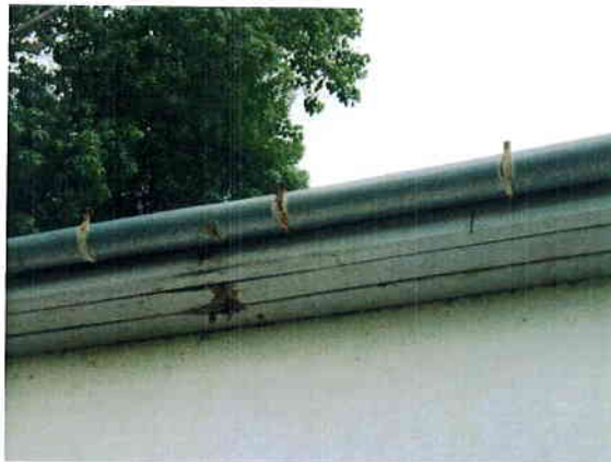
eresz csatorna lukas, deszkázat elkorhadt.
