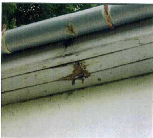
eresz csatorna lukas, deszkázat elkorhadt., Emeleti rész, iroda ablaknál repedés,
