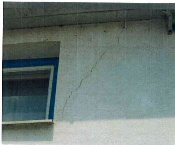
eresz csatorna lukas, deszkázat elkorhadt., Emeleti rész, iroda ablaknál repedés,
