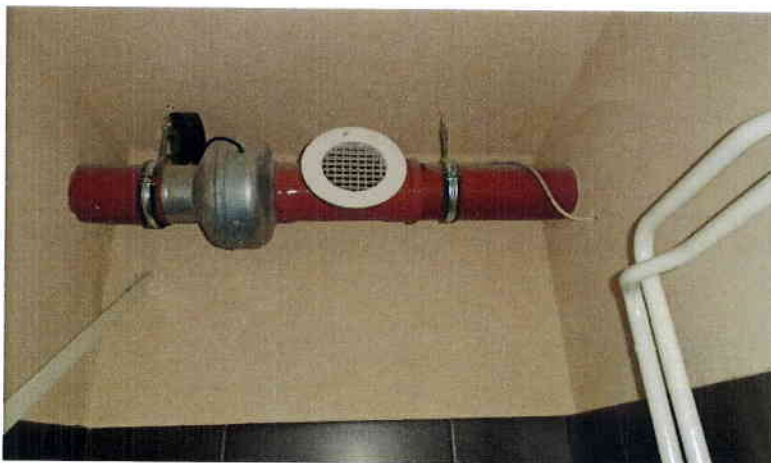
Öltözőkbe kiépített légerszívó,
