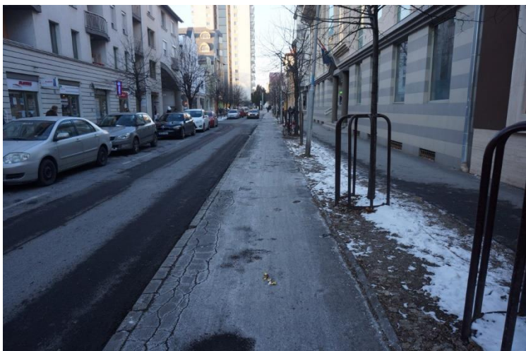
22. fénykép: Kőszegi utca menti meglévő kerékpárút
