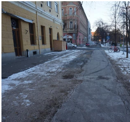
23. fénykép: Gyöngyös-patak menti meglévő kerékpárút
