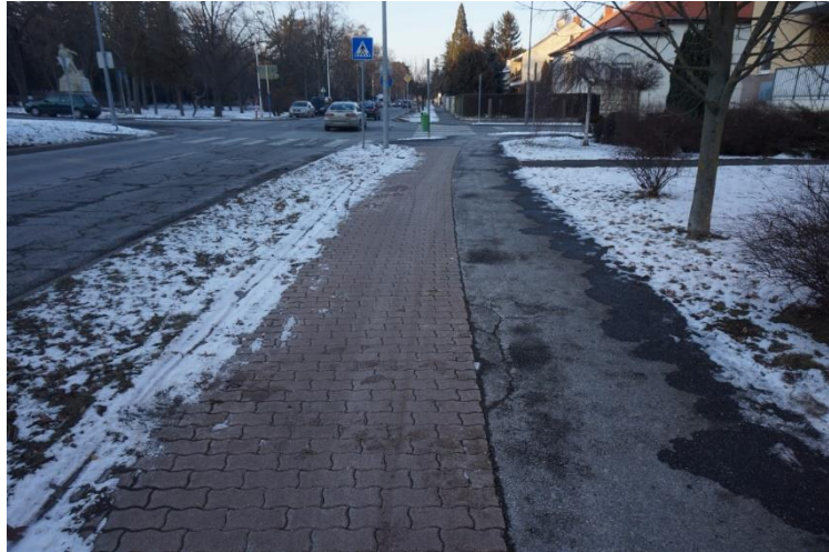
28. fénykép: Brenner Tóbiás körút menti meglévő, elválasztott gyalog- és kerékpárút
