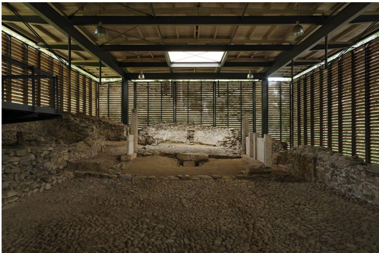
Egyszerű, a romok tartós fennmaradását is szolgáló átszellőztetett védőépület Teurnia-ban (Ausztria), az ókeresztény templomrom felett.
