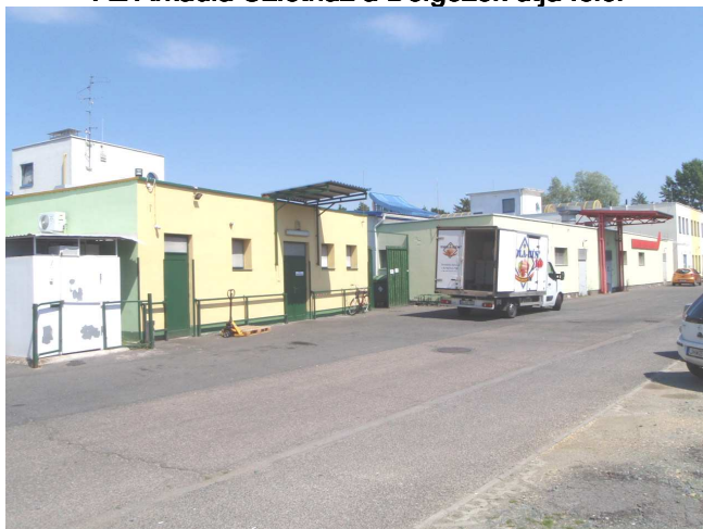
Árkádia Üzletház Novák Piac felüli homlokzata gazdasági bejárattal
