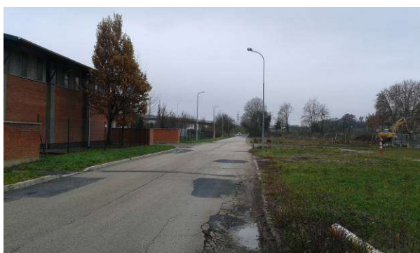
A Mikes Kelemen utca felüljáró felé vezető szakasza a meglévő biomassza fűtőmű elől
