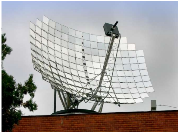
1.3.1.ábra „Szolár parabola” napkövető koncentrált napkollektor (forrás: www.zoldtech.hu )
