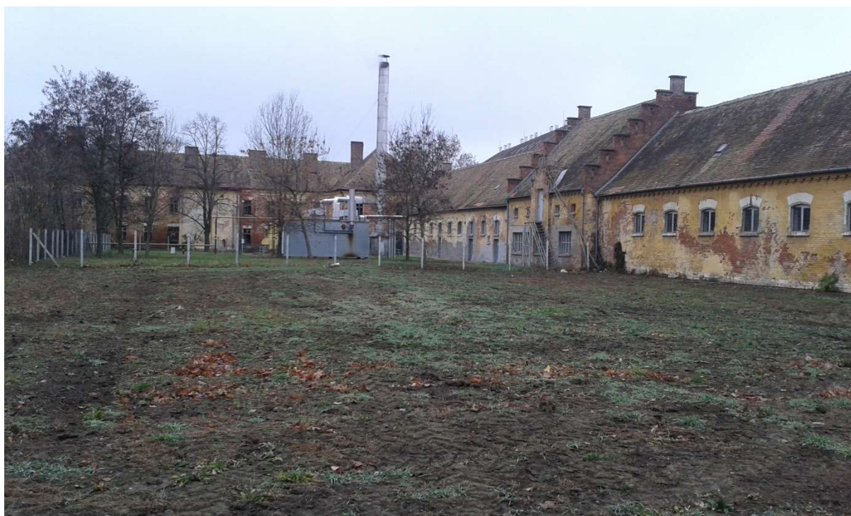
Huszár úti „laktanya” konténerizált gázmotorja (háttérben a konténer kazánok kéménye)
