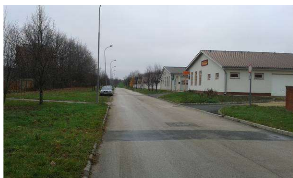
A Mikes K. utca földgáz kazánház felé vezető szakasza a meglévő biomassza fűtőmű elől
