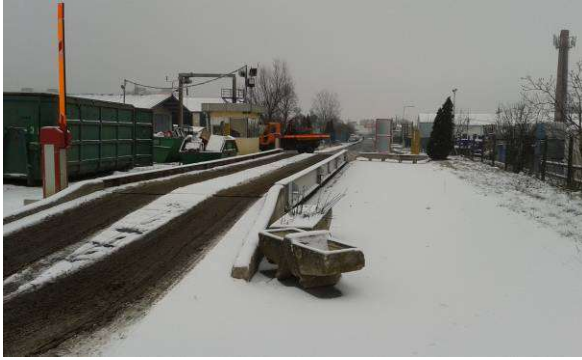
A Körmendi út felől meglévő bejáró út (Pohl-tó utca) a hidmérleggel
