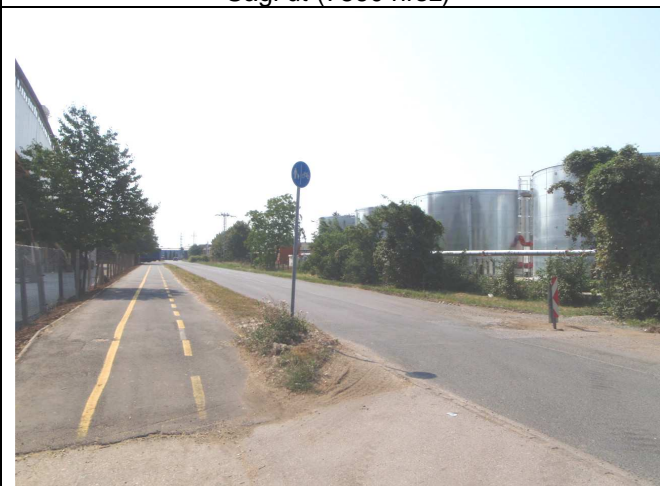
Kolozsvár utca kerékpárúttal, a Sági úttól délre eső szakasz
