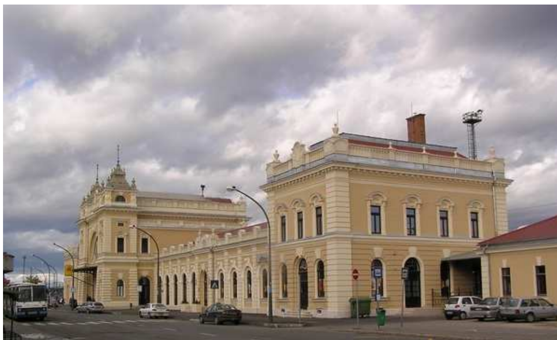
90. A nagyvasúti pályaudvar és felvételi épülete
