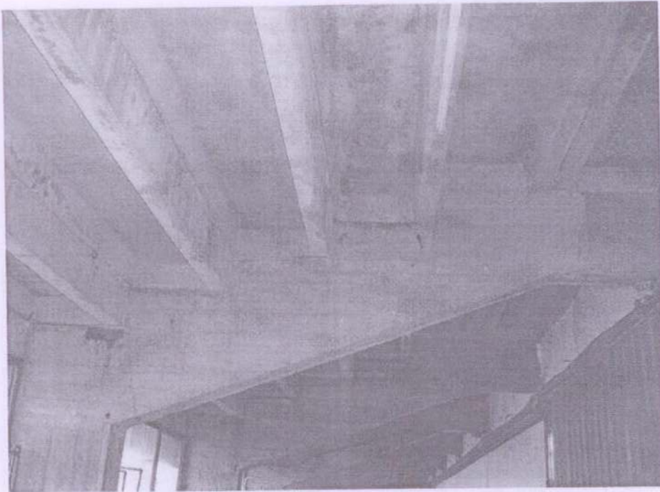
7. kép monolit vasbeton pillér és törtvonalú gerenda
