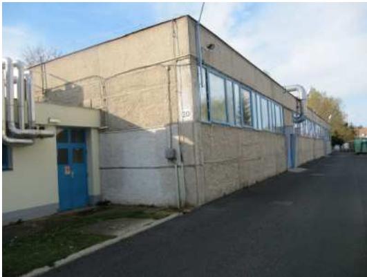
20. jelű épület (gyártócsarnok)
