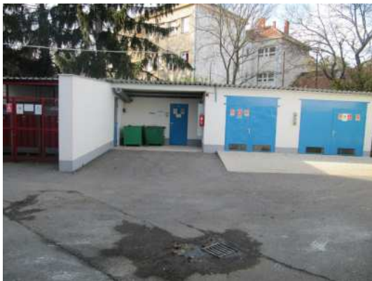
21. jelű épület (gyártócsarnok)
