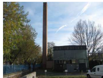
14. jelű épület (kazánház)
