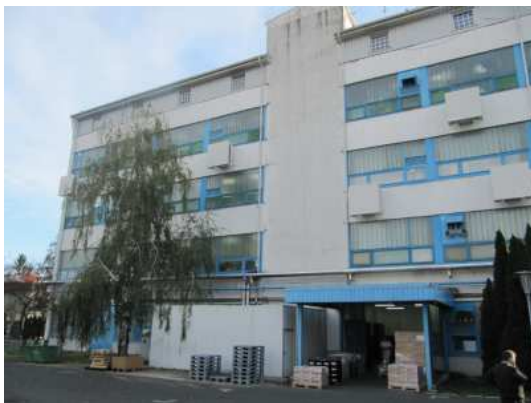
16. jelű épület (gyártócsarnok)
