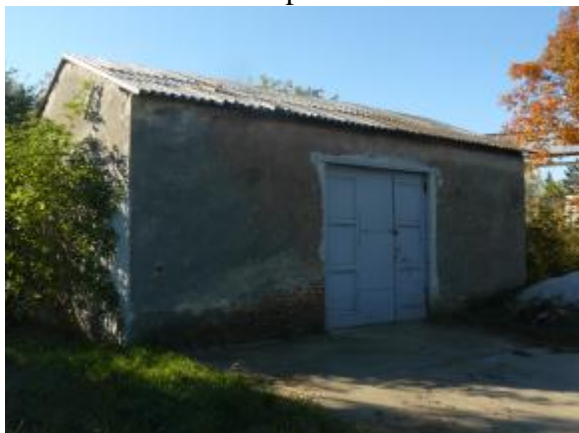
7841/A/8 hrsz raktárépület
