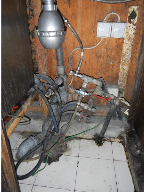
A belső vízvezetékrendszer elavult kaotikus állapota
