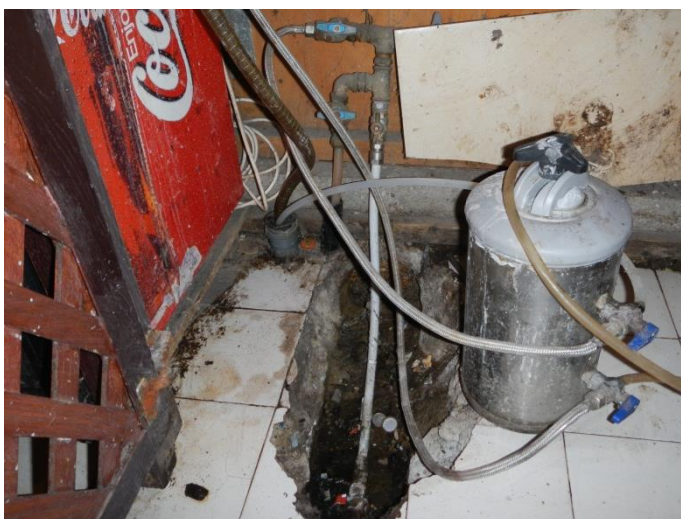
A pult alatti többszöri csőtörés helye.
