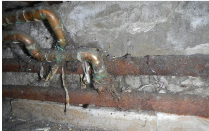
A 2007-es átalakításkor a vascsövekhez behegesztett rézcsövek.
