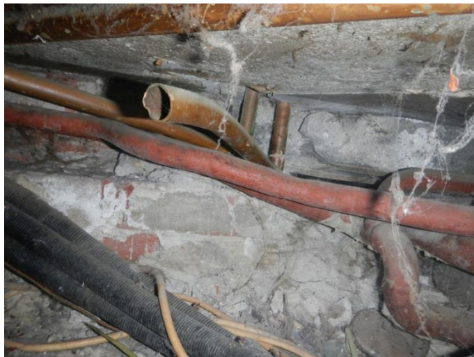
A 2007-es átalakításkor ottmaradt csőmaradványok.
