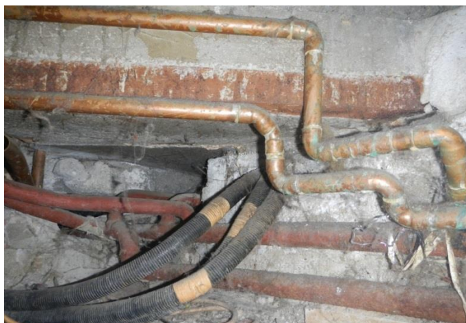
A 2007-es átalakításkor a vascsövekhez behegesztett rézcsövek.
