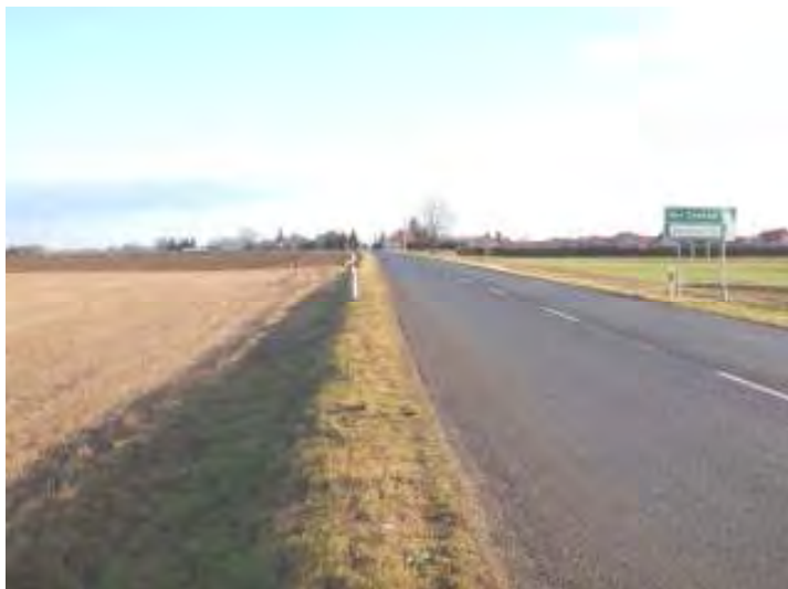
A Külső Zanati út Zanat felé, baloldat a tervezett kerékpárút helye
