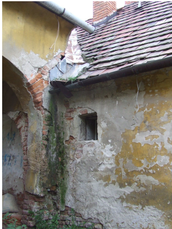
Kőszegi u. 15.-17. udvari épületsarok
