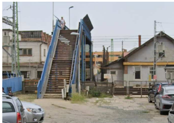
213. ábra: Vasút u. 20. melletti meglévő gyalogos felüljáró
