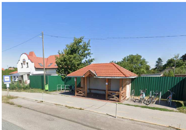
168. ábra: Túraútvonal-szakasz Táplánszentkeresztben, buszmegállóhely kerékpártámaszokkal
