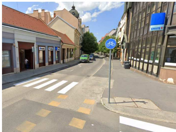
148. ábra: Kőszegi utca, egyirányú aszfalt kerékpárút szakasz
