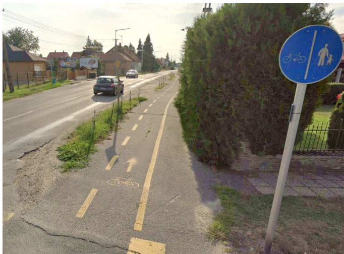
136. ábra: A gyalog- és kp.út lakott területen: hiányzó vízelvezetés
