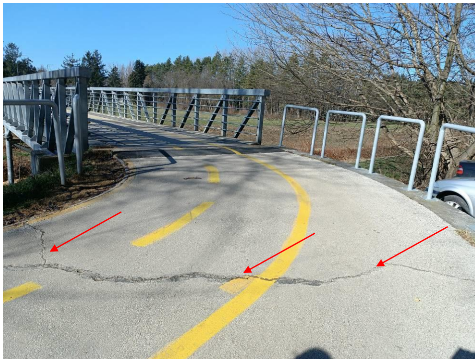
6. kép: Csatlakozó útszakasz állapota a híd bal oldalán. A csatlakozó útpálya repedezett, a süllyedő háttöltés miatt.
