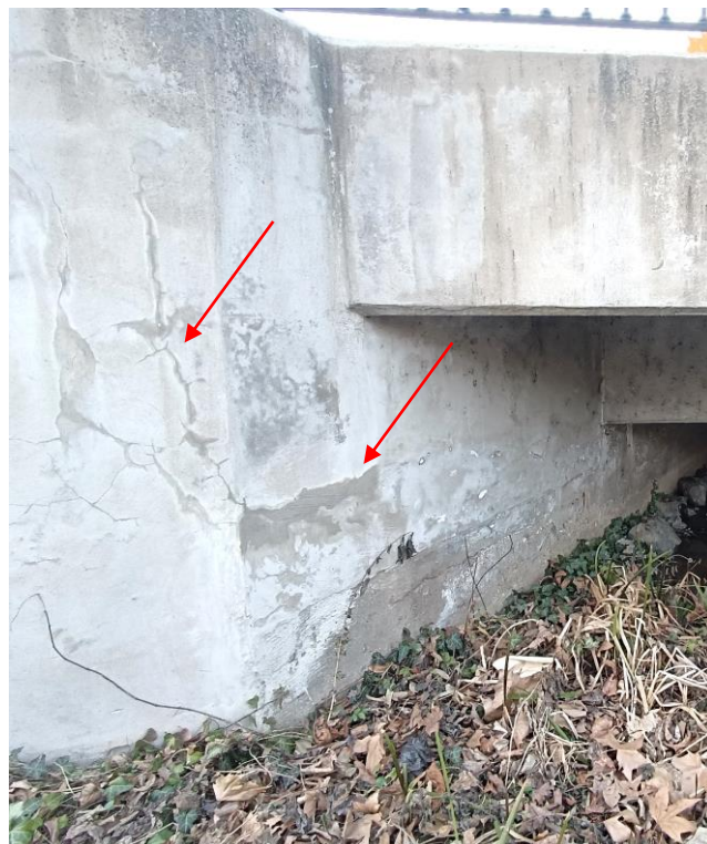
3. és 4. kép: Alvízi bal és jobb oldal, szárnyfal csatlakozások. Repedések, meszes kifolyások jellemzik a felületeket.
