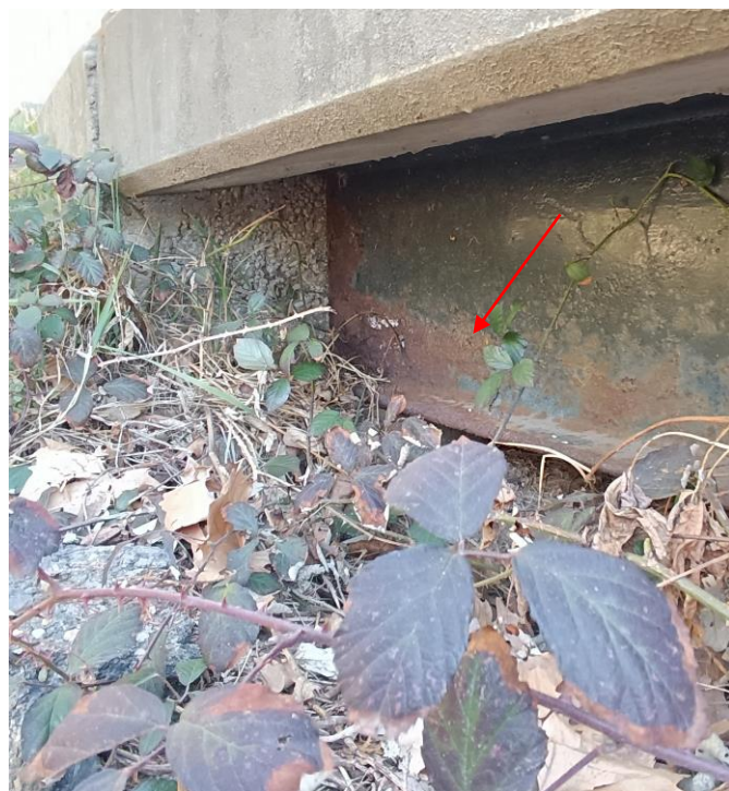
8. és 9. kép: Hídfo, felszerkezet, szegély bal oldalon. Az acél főtartók korróziója a felfekvéseknél nagyobb mértékű.
