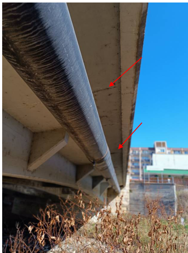
11. és 12. kép: Vízkivezetés és járdakonzol alulnézete.
