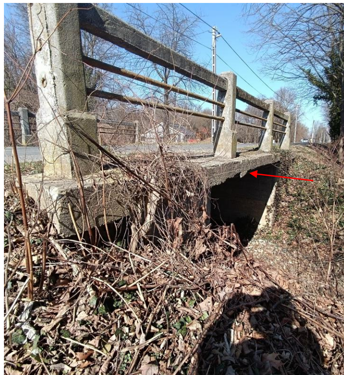
6. és 7. kép: A híd szélé a befolyási és kifolyási oldalon. A növényzet főleg a befolyási oldalon belepte a hídszélet. A vasbeton lemez szélé leválik az acélkorrózió következtében, A korlátok nem szabványosak, balesetveszélyesek!
