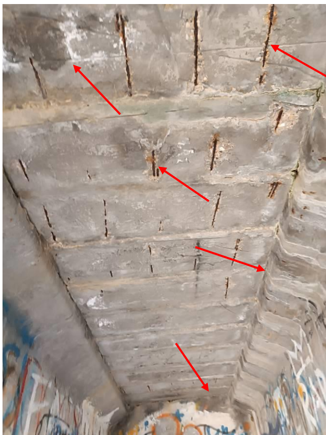
5. és 6. kép: Keresztirányú előregyártott pályatáblák alsó felületén átázások, betonleválás, kilátszó korróziós betonacélok.
