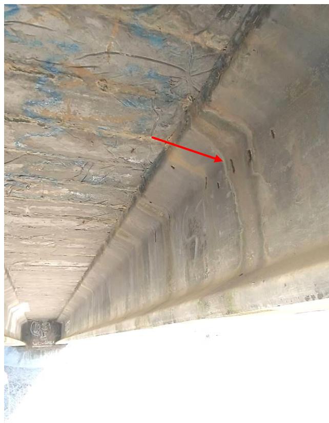
5. és 6. kép: Keresztirányú előregyártott pályatáblák alsó felületén átázások, betonleválás, kilátszó korróziós betonacélok.
