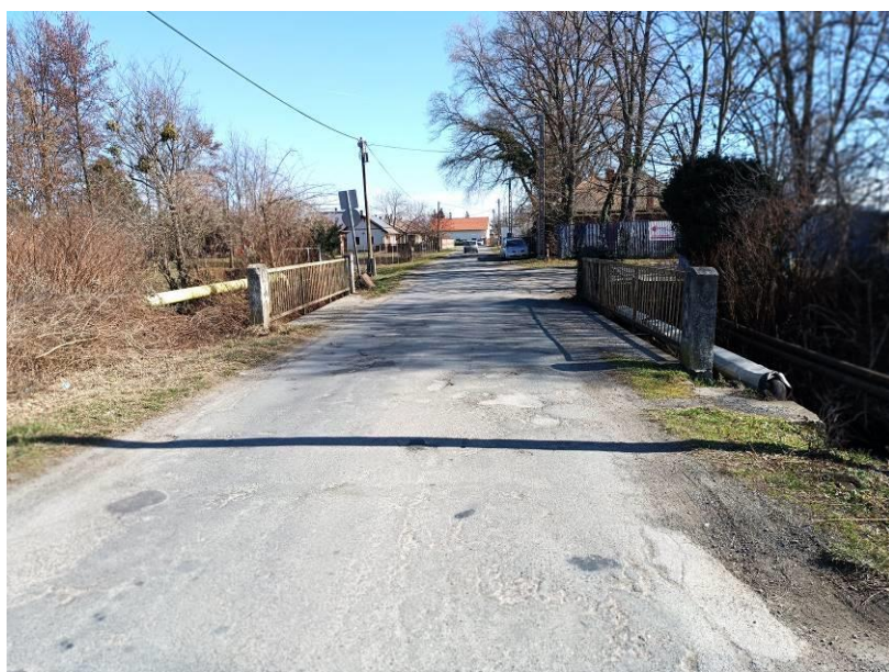
1. kép: Pályanézet Tönkrement útburkolat.
