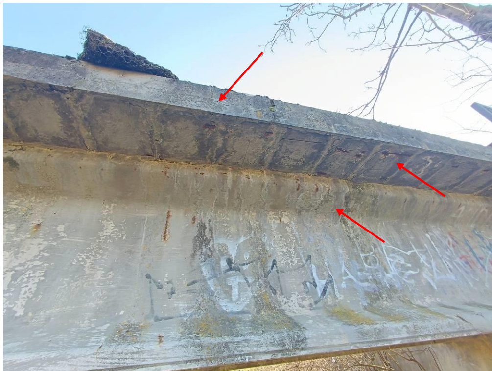
7. kép: Főtartó és konzol a befolyási oldalon.
