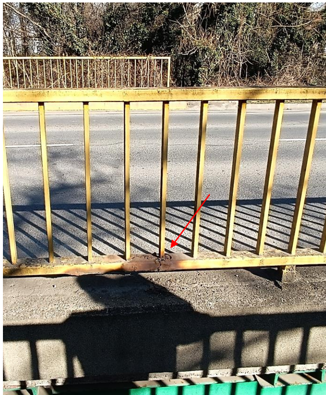
11. kép: Kifolyási oldal A korlát alsó hevederje erősen korrodált, eltört. Korróziós korlátokfelület.
