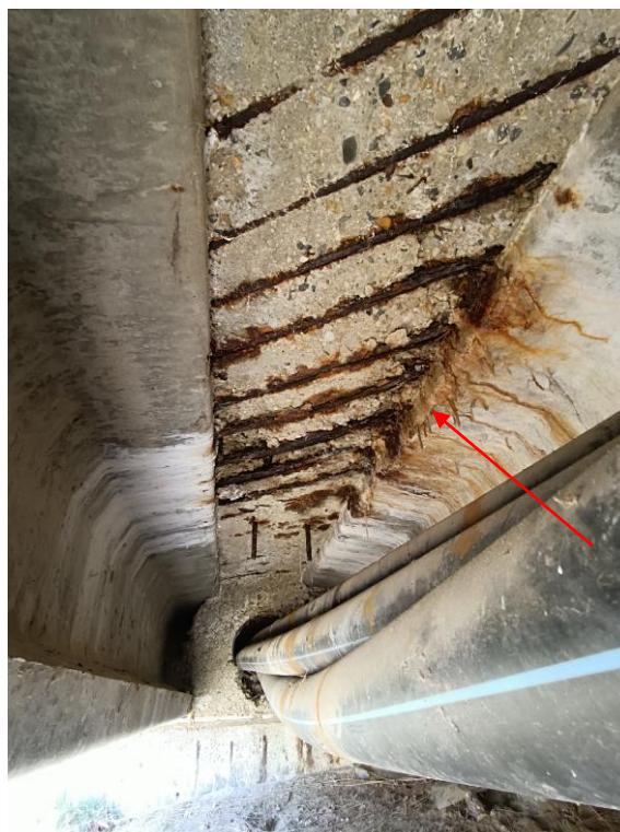
11. és 12. kép: szélső tartó és pályalemez az alvízi oldalon. Jelentős korrózió.
