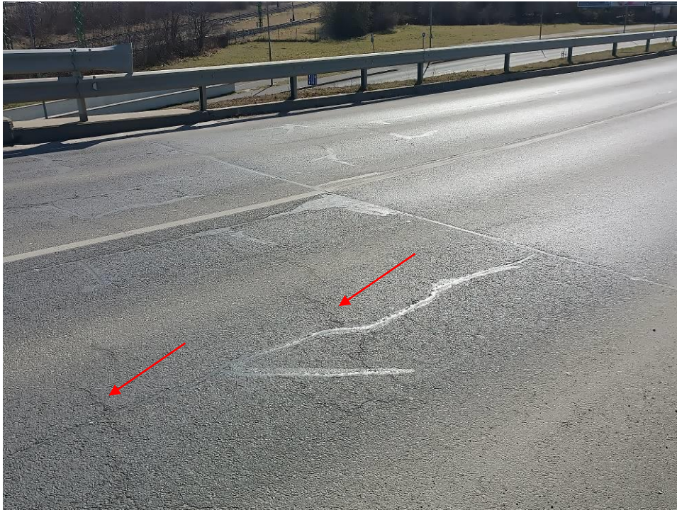
30. kép: Útburkolat a hídon a Ny-i hídfő előtt. A háttöltés felett az aszfaltburkolat repedezett, nyomvályúsodó, kiöntéssel részben javított. Több helyen új repedések, kátyúsodás figyelhető meg.
