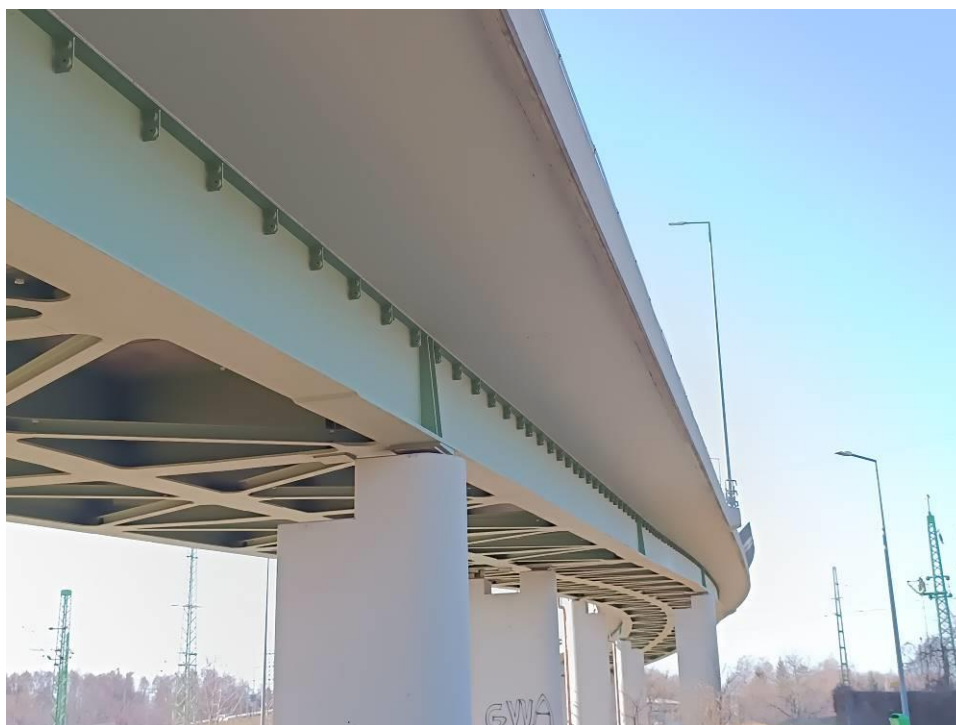
6. kép: É-i oldal a K-i hídfőtől nézve A felszerkezet és konzol jó állapotú.
