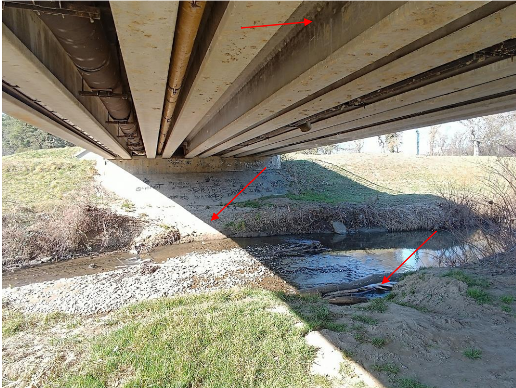
5. kép: Felszerkezet és medertér a bal part felől nézve. A gerendák felső részén meszes, korróziós lefolyásnyomok láthatók. A meder mindkét oldalon erodálódik, a mederben uszadék.
