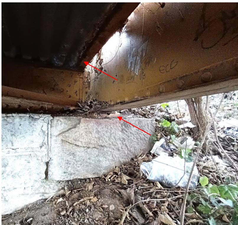
4. és 5. kép: Hídfe és tartó felfekvések a jobb és bal oldalon.
