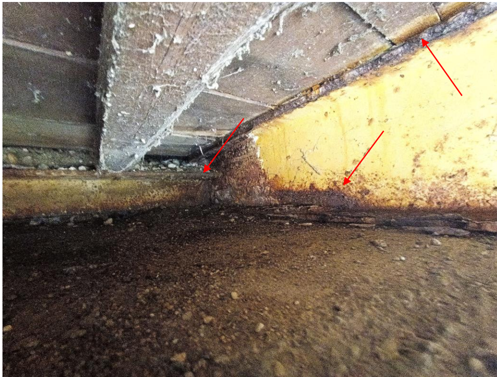
5. kép: Hídfeletti acél gerendavég. A leázás következtében a korrózió még nagyobb mértékű.
