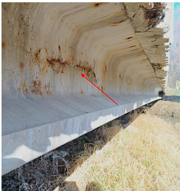
11. és 12. kép: szélső tartó és pályalemez az alvízi oldalon. Jelentős korrózió.
