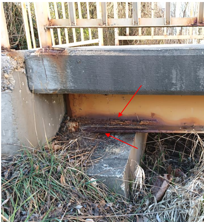
5. és 6. kép: Hídfő, saru, tartóvég, korlát a jobb oldalon. Erősen korrodált felületek.
