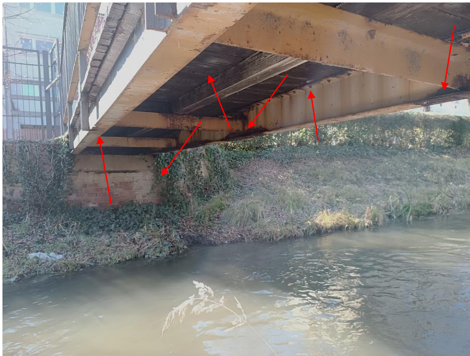
3. kép: Felszerkezet és jobb oldali hídfő.
