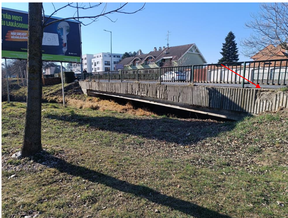
24. kép: A híd és környezete az alvízi oldalon. A kőburkolatokat belepte a növényzet, itt rendezettebb a híd környezete, mint a másik oldalon. A szegélyelem nagyfokú leválása is látható.
