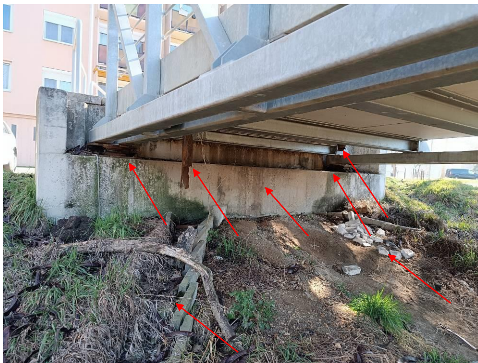
7. kép: Híd bal oldali hídfőjének és környezetének állapota. A hídfőn erős leázás nyomok láthatók, mivel a vízelvezetés a hídon nem működik. A vízelvezető csövek már nem csak korrodáltak, hanem hiányosak is. A lefolyó víz a sarukat nagymértékben korrodálja. Surrantók eltömődtek. A hídfők felülete cementpép hiányosak. Nagy mennyiségű hordalék, illetve építési törmelék található a hídfő közelében. Előrézsű nincs szakszerűen kialakítva, ezért a talaj erodálódik.
