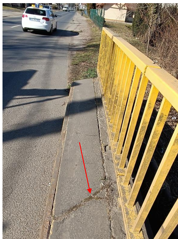
11. kép: Kifolyási oldal A korlát alsó hevederje erősen korrodált, eltört. Korróziós korlátokfelület.
