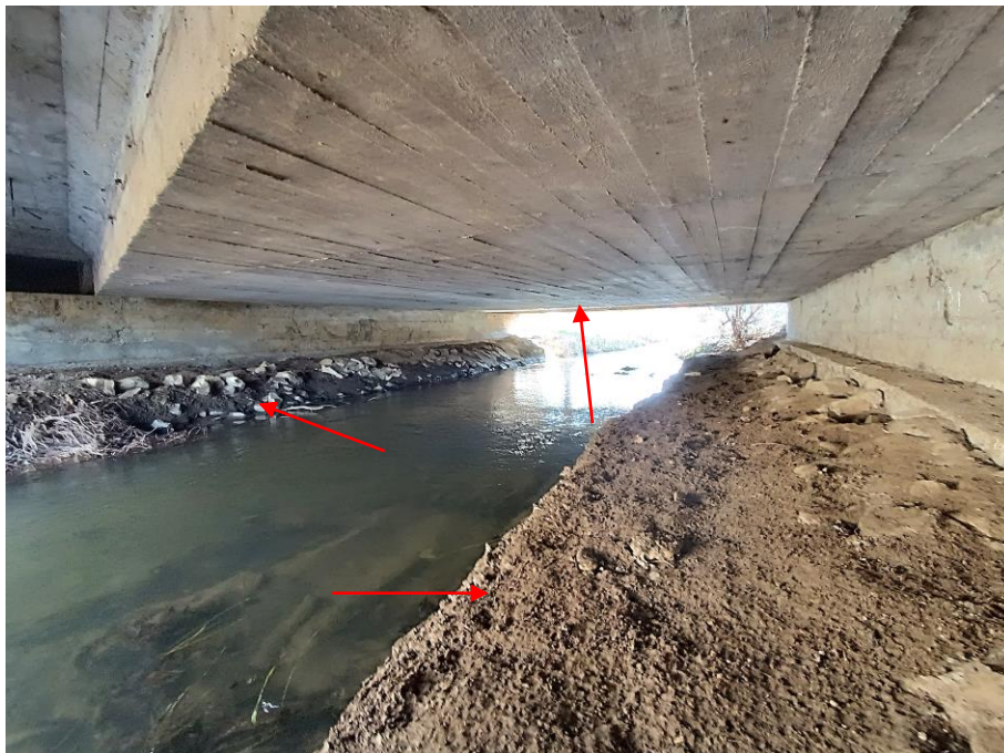
10. kép: Balparti hídfő, felszerkezet és medertér.
