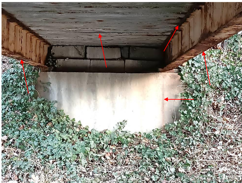
3. kép: A folyás szerinti bal oldali hídfő és felszerkezet.
