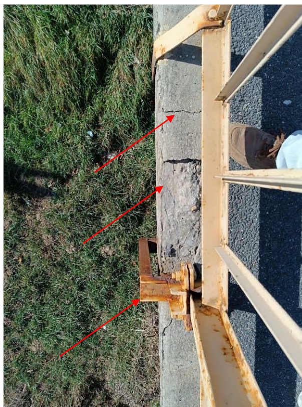
6. és 7. képek: Hídszegély állapota a kifolyási oldalon A szegélyen a hengerelt aszfalt járdaburkolat repedezett, hiányos. A korlátok talplemeze és csatlakozásai korrodáltak. A konzol szélén az utólagos rábetonozás repedezett, levált, hiányos. Az útburkolaton az ellenék ki van alakítva, de a felgyülemelő vizet nem vezeti el semmi a hídpályáról. A közmű átvezetés rögzítő elemei korrodáltak. A korlát több helyen erősen korrodált.
