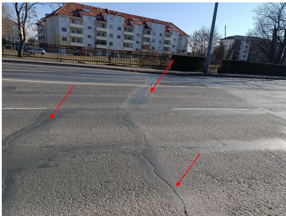
6. kép: Csatlakozó pályaburkolat, a 86 sz. út felől
