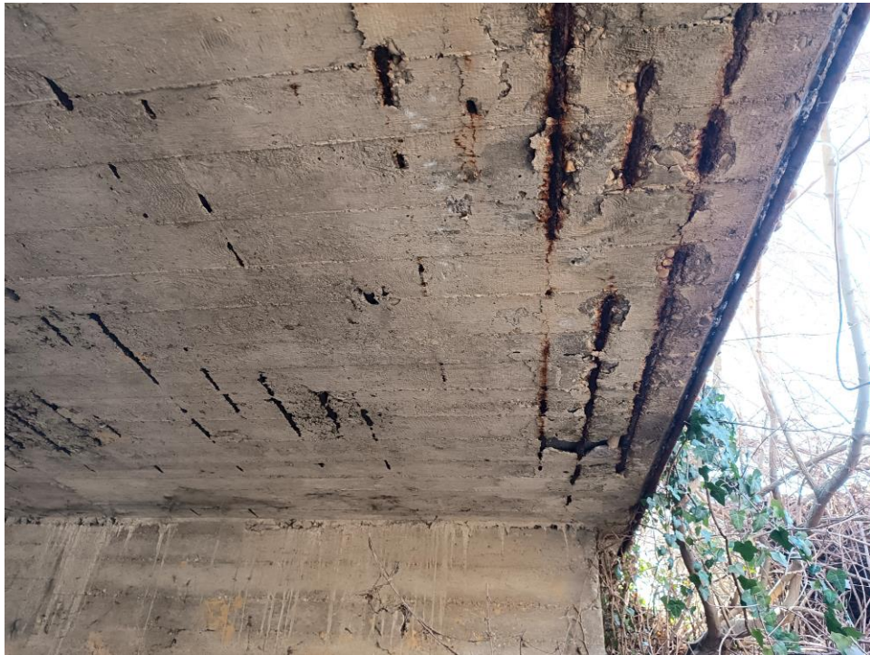
5. kép: A felszerkezet vége a befolyási oldalon A szerkezeten vízorrr, kiemelt szegély nincs. A víz a vb. lemez oldalán folyik le. Betonacélokról levált a beton, erősen korróziósak.
