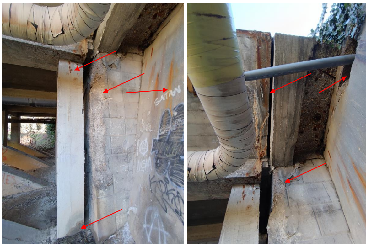
8. és 9. kép: Befolyási jobb oldal dilatációs szerkezete
