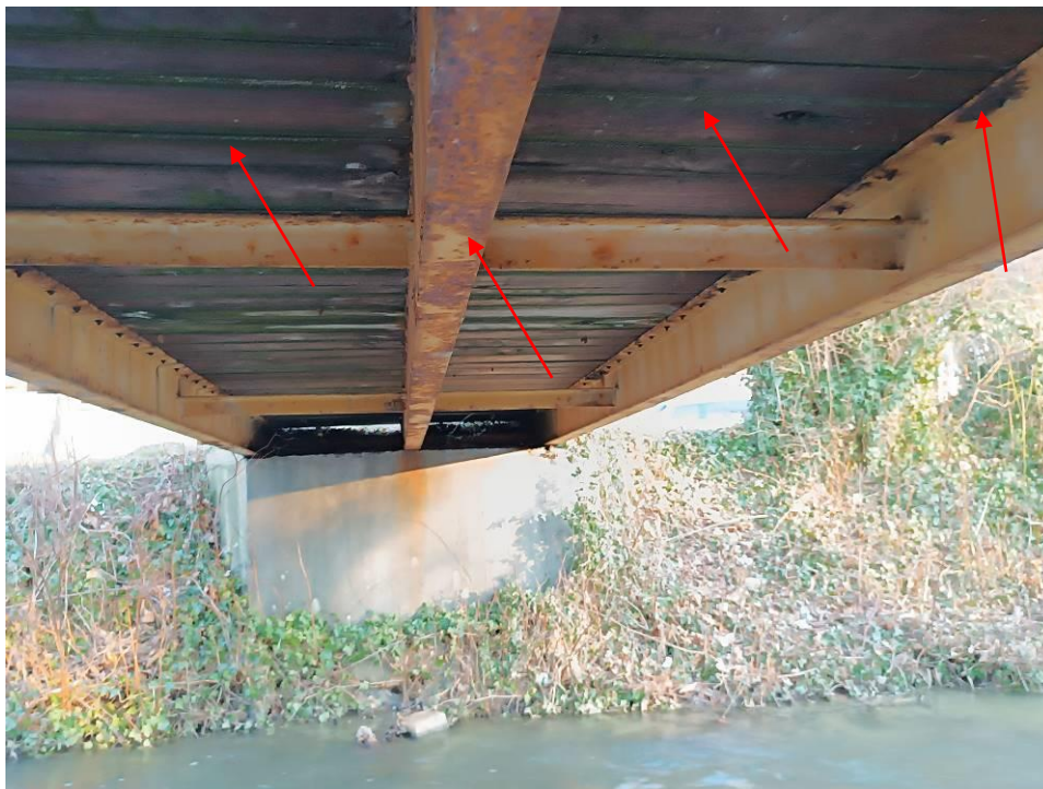
5. lép: Felszerkezet a park felől nézve. Az acél főtartókon és pallókat rögzítő csavarokon erős korrózió. A járópallók szélei korhadnak. A hídfőn erős leázások nyomai.
