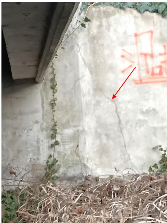
3. és 4. kép: Alvízi bal és jobb oldal, szárnyfal csatlakozások. Repedések, meszes kifolyások jellemzik a felületeket.
