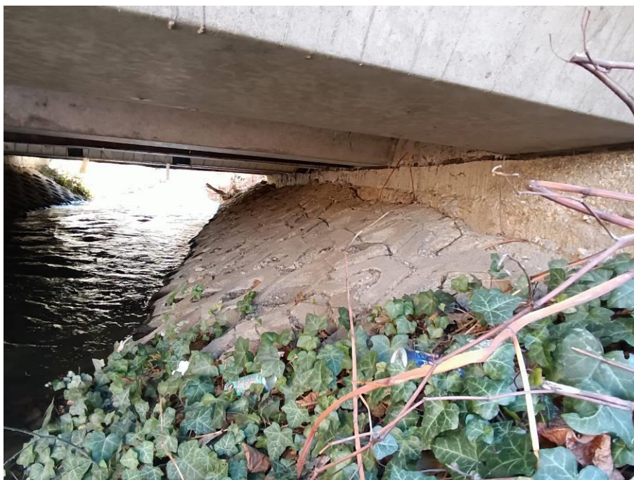
8. kép: Jobb oldali hídfő és mederburkolat.
