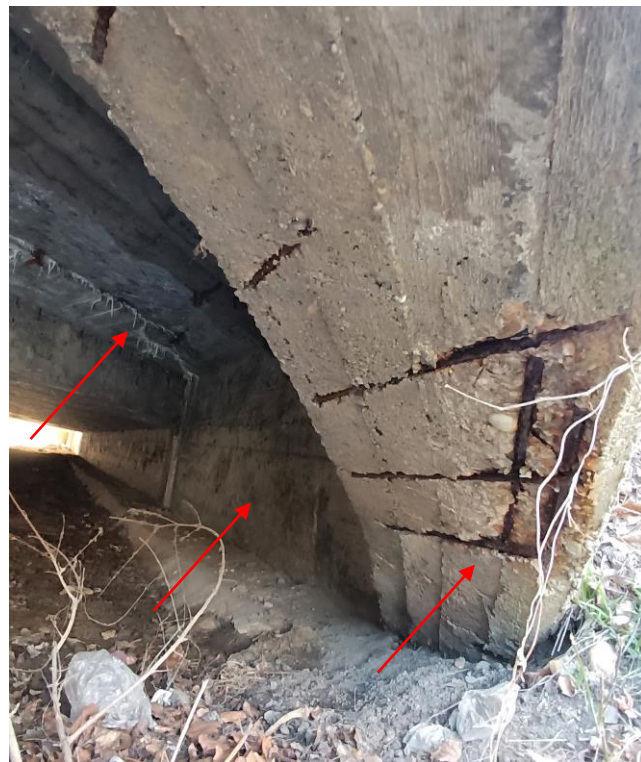
16 és 17. kép: Felszerkezet, hídfők, medertér alvízi oldal.
