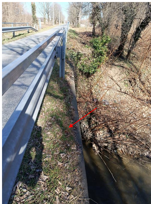
10. kép: Kiemelt szegély nincs kialakítva a hídon, a korlát sávjában megtelepedett a növényzet, a csapadék közvetlenül a tartószerkezetbe jut.
