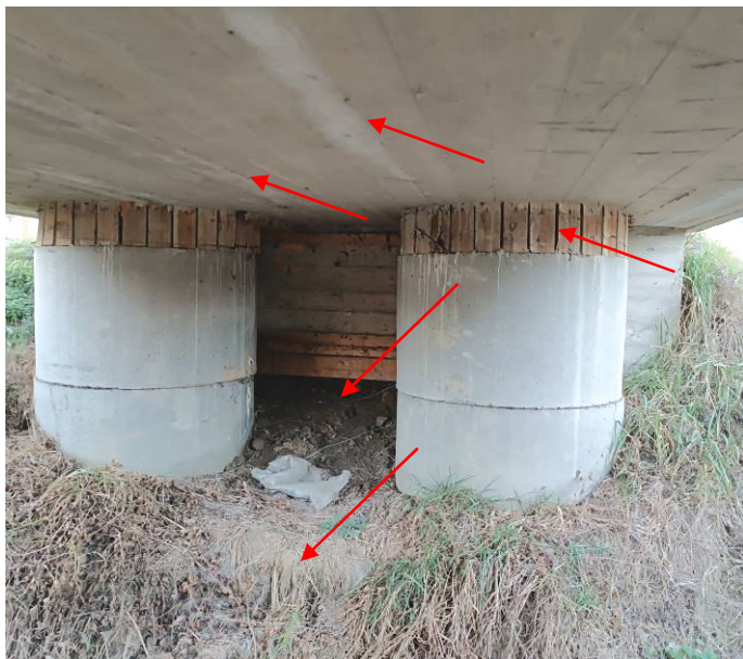
3. és 4. kép: Felszerkezet, pillérek, kötényfal, illetve üregelődés és süllyedés.
