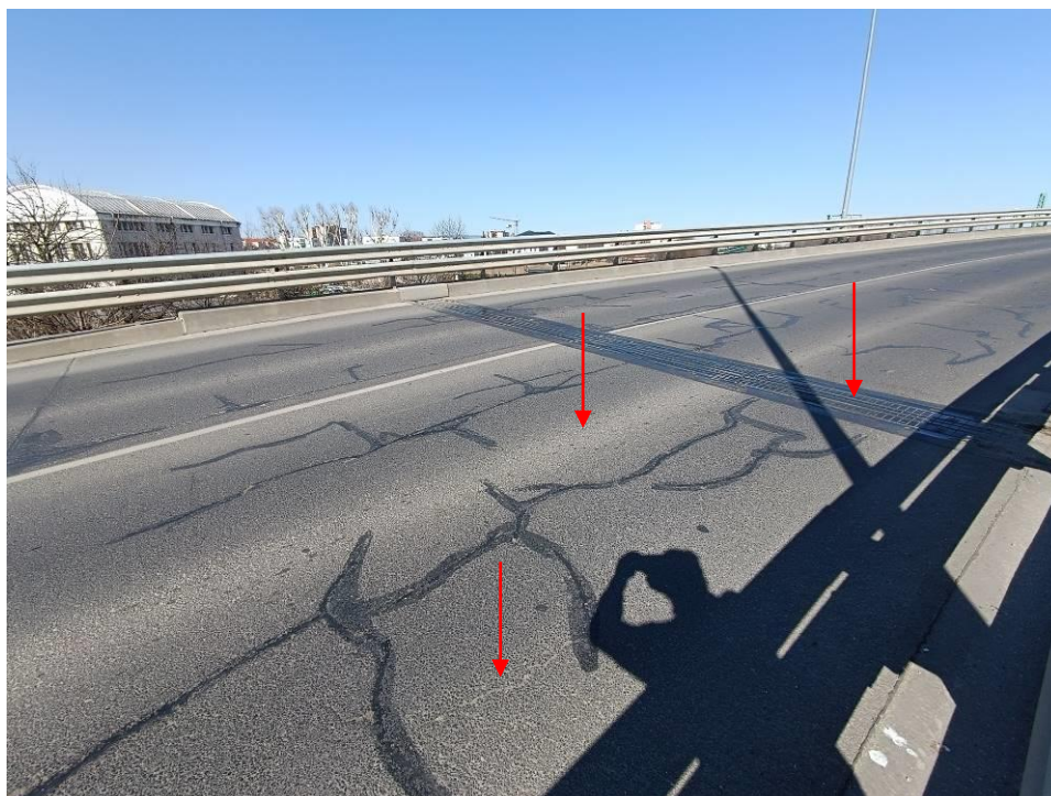
26. kép: Útburkolat, háttöltés, dilatációs szerkezet a Ny-i hídfőnél Az aszfaltburkolat repedezett, nyomvályúsodó, kiöntéssel részben javított. A dilatációs szerkezet eltömődött hordalékkal.
