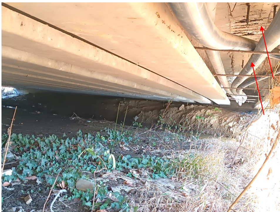
16. kép: Hídfő és felszerkezet a folyás szerinti bal oldalon. A hídfő az iszaphalom miatt nem látszik.
