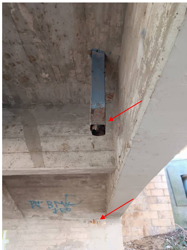
11. és 12. kép: Vízkivezetés és járdakonzol alulnézete.
