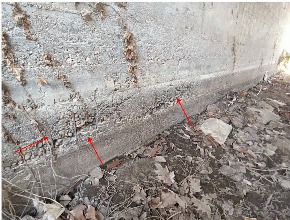
4. kép: Hídfele a folyásirány szerinti bal oldalon. A mindkét hídfele betonfelülete fészkes, cementpép hiányos, kilátszó korróziós betonacélokkal.
