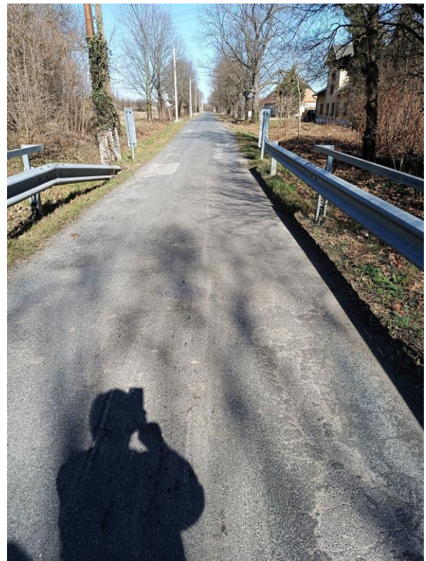
8. és 9. kép: Repedezett, kátyús, megsüllyedt burkolat a hídon.
