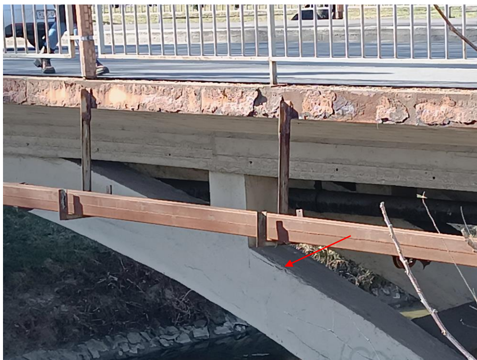
7. kép: Kifolyási oldal konzol oldallemeze és közmű tartószerkezete. A kifolyási oldalon lévő konzol oldallemeze, a közmű tartószerkezete és a védőcsövek erősen korrodáltak. Több helyen a híd ívgerendáin repedések láthatók, amelyeket a korábbi vizsgálatok is leírtak.
