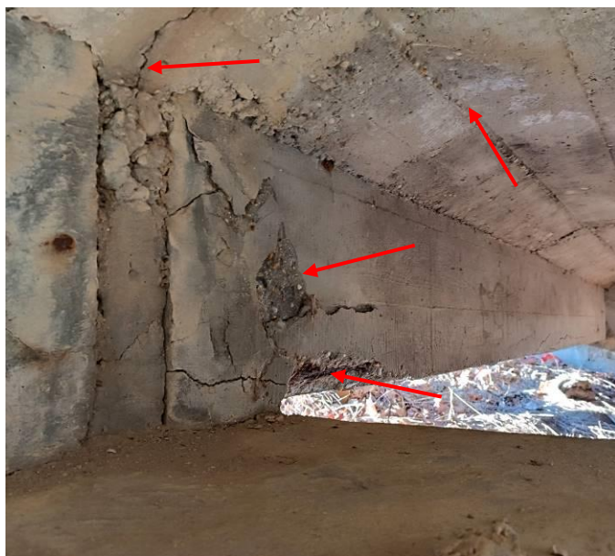
4. és 5. kép: A bal oldali támasz, tartók felfekvése.
