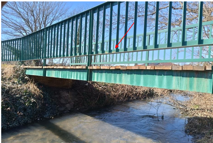
6. kép: Alvízi oldal. A pallók vetemedése megindult, a csavarok is meglazulnak. A korláton a mázolás foltokban kezd leválni.
