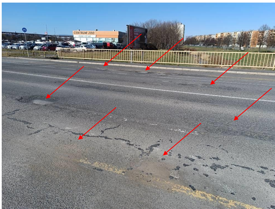
5. kép: Burkolat kifolyási oldalról nézve. Útburkolat nyomvályús, repedezett, kátyús. A csapadékvíz megáll a burkolaton, nem tud távozni.
