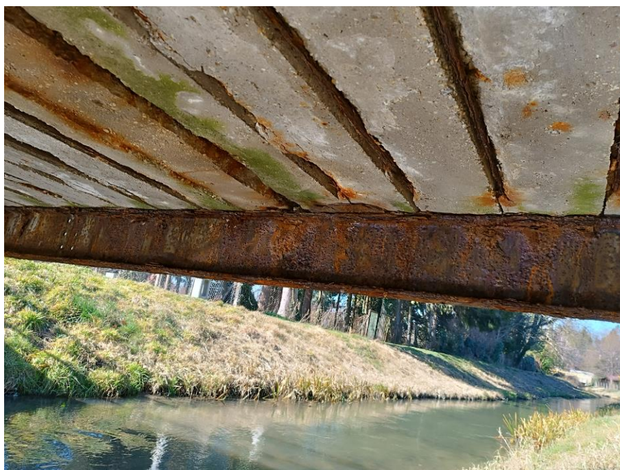
7. kép: Felszerkezet Minden szerkezeti elemen nagyfokú állapotromlás tapasztalható.
