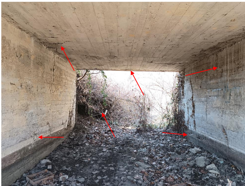
3. kép: Hídfelek és felszerkezet a kifolyási oldal felől. Bevonat nélküli, fészkes betonfelületek, lefolyásokkal, kilátszó korróziós betonacélokkal. A mederteret és a híd környezetét belepte a növényzet.
