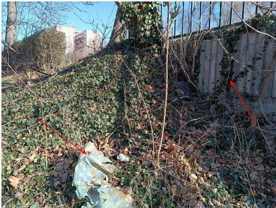
23. kép: Rézsűkúp, felvízi oldal. A kőburkolatot belepte a növényzet, ami a hídra is felkapaszkodott.
