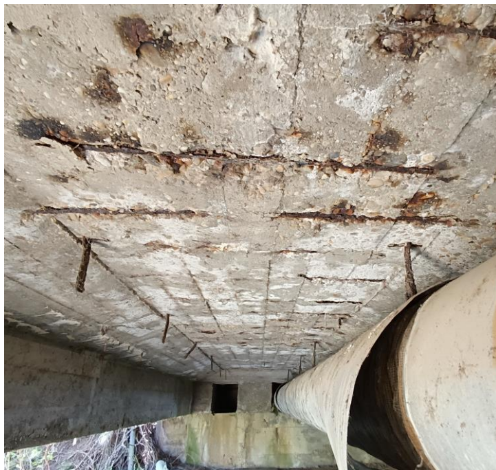
19. és 20. kép: Felszerkezet, hídfő és közmű átvezetés az alvízi oldalon.
