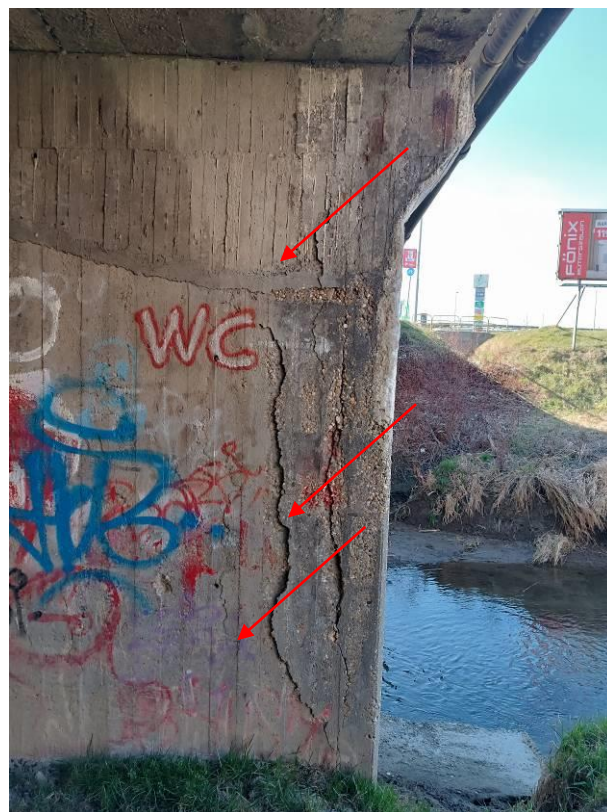
15. és 16. kép: Befolyási oldal, bal pillér repedései.
