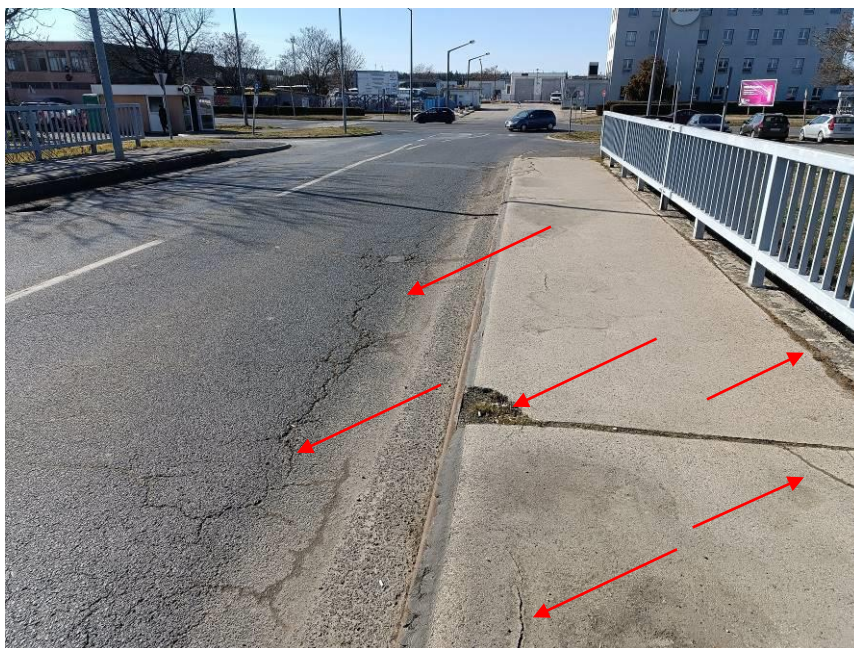
3. kép: Befolyási oldal nyílásközép aszfalt és járdaszegély állapota.
