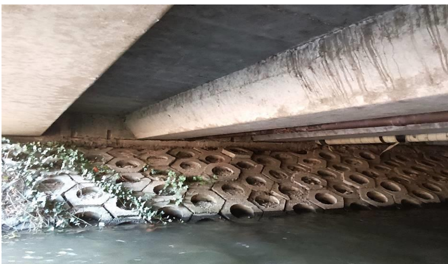
7. kép: Bal oldali hídfő és mederburkolat.
