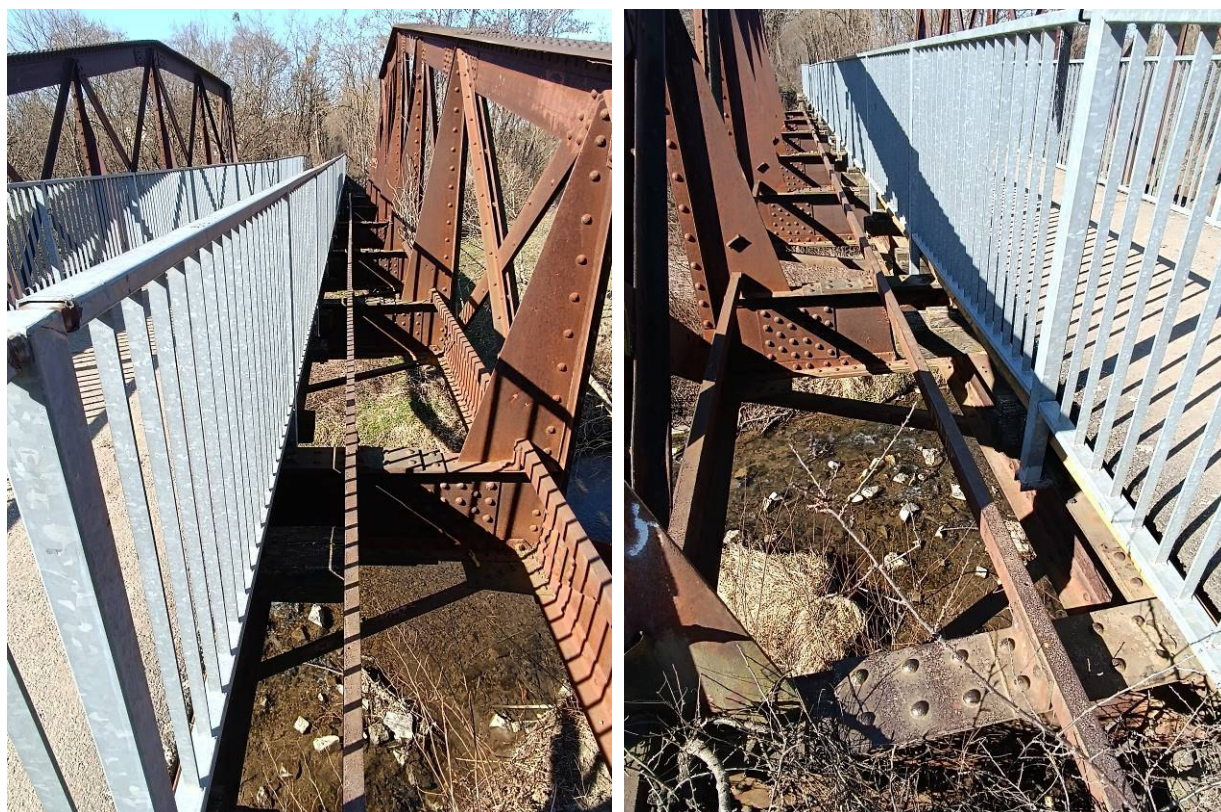
4. kép: Kétoldali korlát és acél tartószerkezet.
