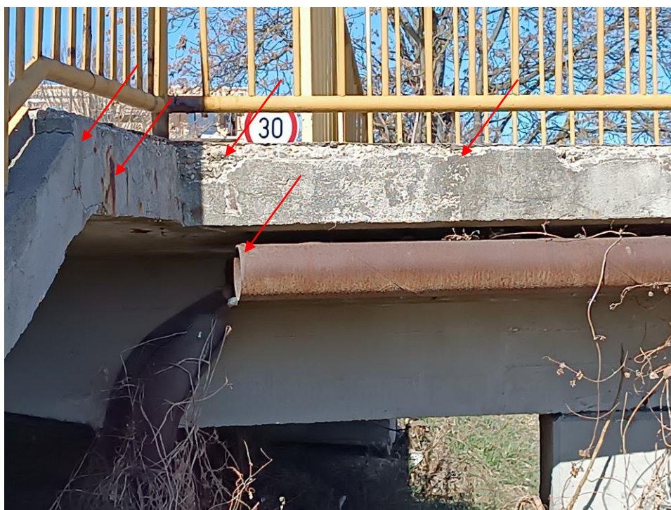
10. kép: Közművezeték és szegély állapota.
