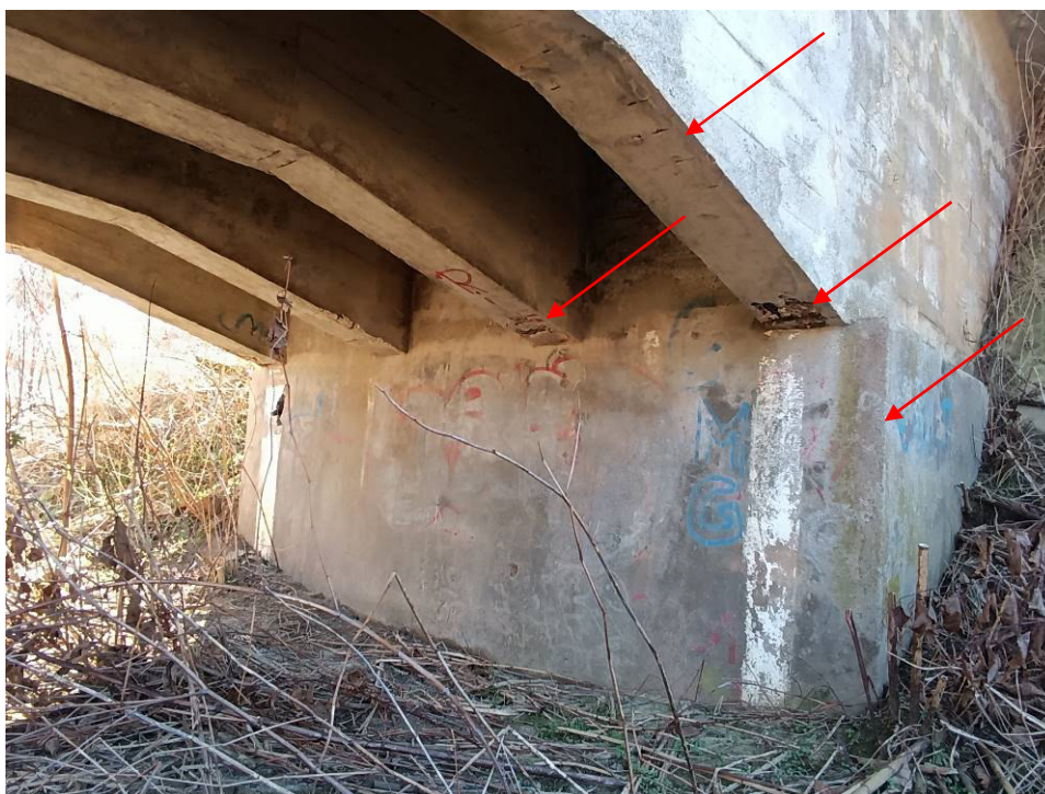
9. kép: Jobb oldali hídfő és főtartó csatlakozás A hídfő és főtartók csatlakozásánál a főtartók alsó síkján betonhiány látható. Látszódnak az erősen korrodált betonacélok.
