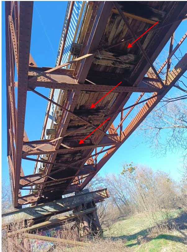
5. kép: Acél tartószerkezet és fa gerendák állapota a medertér felett.
