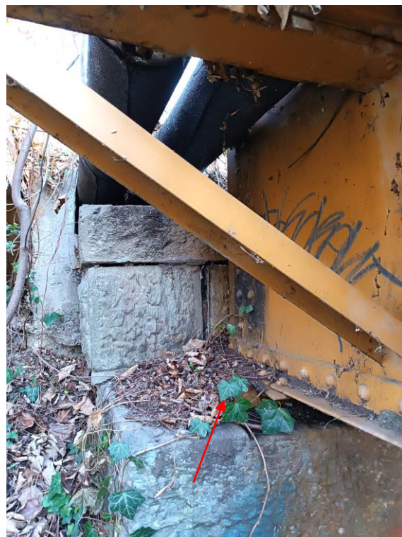
4. és 5. kép: Hídfe és tartó felfekvések a jobb és bal oldalon.
