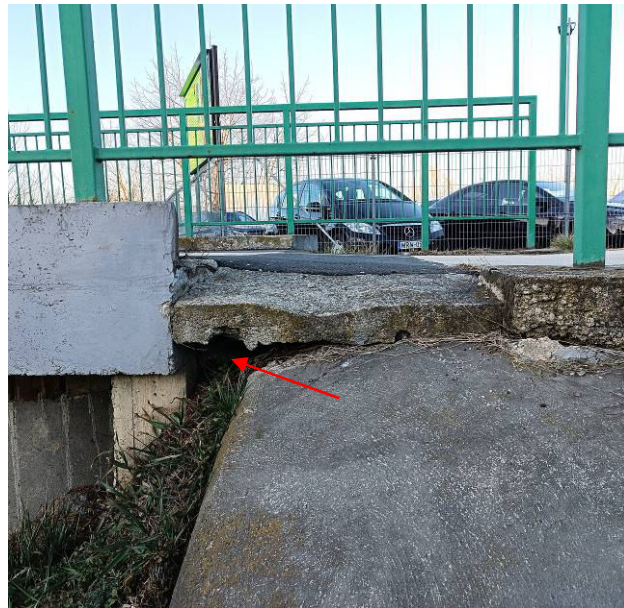
3. és 4. kép: Felszerkezet, pillérek, kötényfal, illetve üregelődés és süllyedés.
