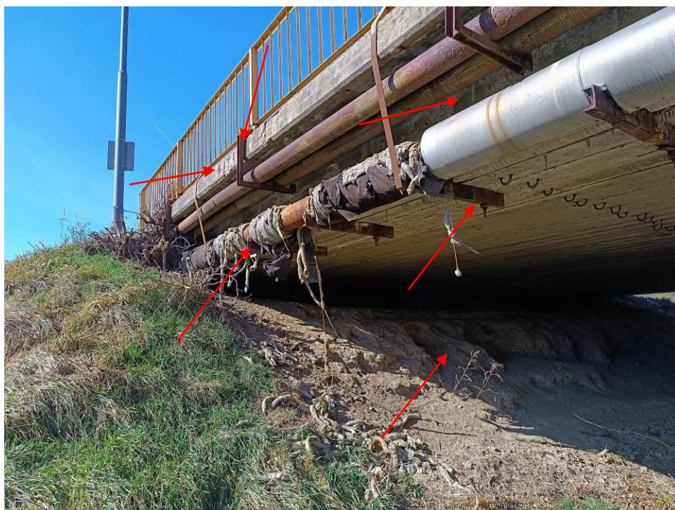
9. kép: Kifolyási oldal felszerkezet és közmű állapota. Konzol oldalán leázások, repedések láthatók. A csövek mögött, a szélső tartón korróziós, meszes lefolyások A szélső tartók alatt a közműtartók erősen korrodáltak. Az alul futó közművezeték védelme hiányos. Az burkolatlan előtöltés erodálódik.
