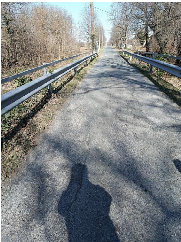
8. és 9. kép: Repedezett, kátyús, megsüllyedt burkolat a hídon.
