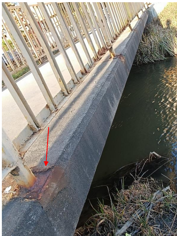
5. és 6. kép: Hídfő, saru, tartóvég, korlát a jobb oldalon. Erősen korrodált felületek.
