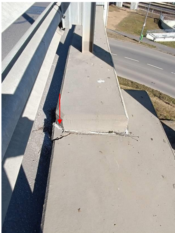
27. és 28. kép: Pótpadkák a Ny-i hídfőnél, D-i és É-i oldal A pótpadkák megsüllyedtek, a rugalmas tömítések elváltak, betonleválás is látható. Az É-i oldalon erős növényzet telepedett meg a szerkezet mellett.
