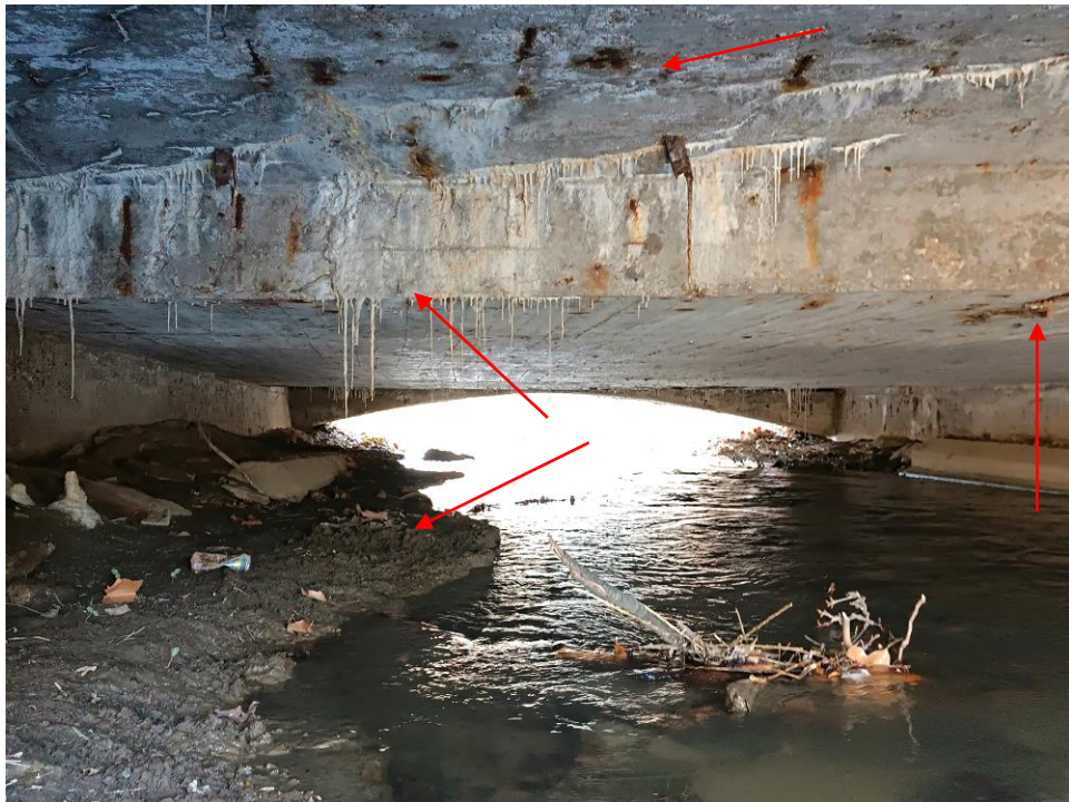
10. kép: Híd fő, felszerkezet és meder a felvízi oldalon. A medertér elfajult, kimosódások, feltöltődések, uszadék és szemét jellemzi. Lásd a 8. képnél leírtakat!
