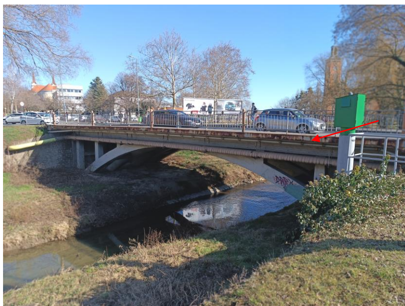
2. kép: Oldalnézet, befolyási oldal. Konzol fém oldallemeze korrodált. Meder és környezete rendezett.
