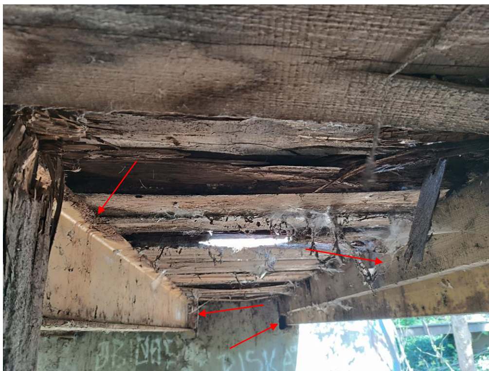
9. kép: Tartók és pályaburkolat az alvízi oldalon. Az acél tartók erősen korróziósak, a felfekvések téglára és téglakiékeléssel történtek.
