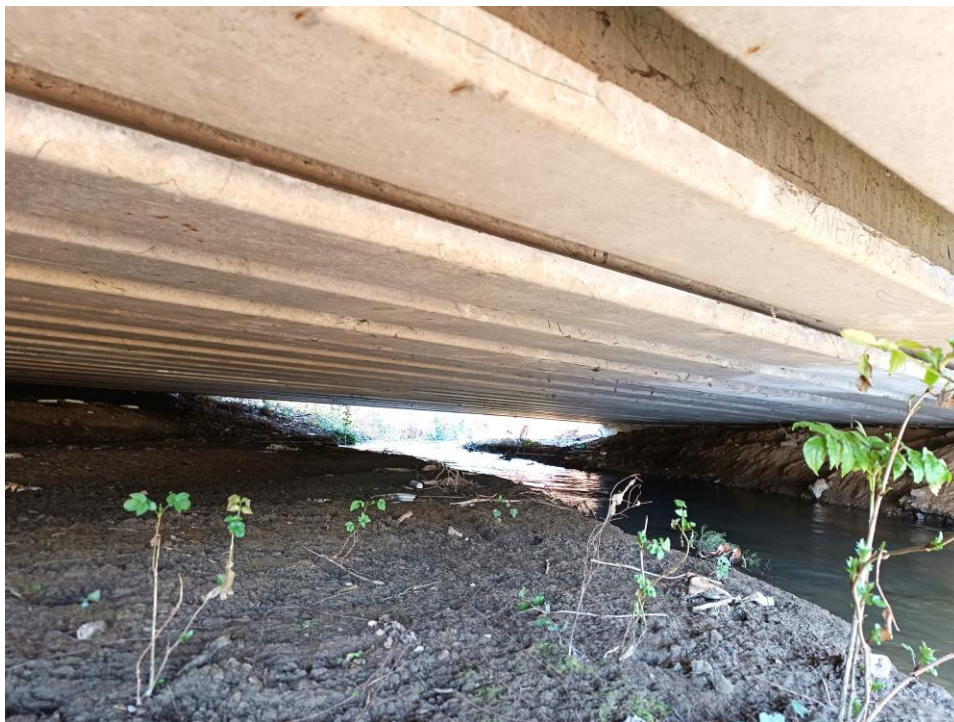
15. kép: Felszerkezet és medertér az alvízi oldal felől. A sodorvonal a bal hídfő felé tolódott el.
