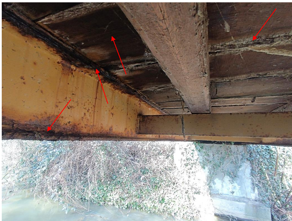
6. kép: Felszerkezet A főtartókon acélkorrózió, az aszfalt alatti faszervezet ázik, korhad.
