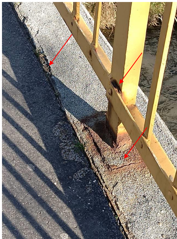
9. és 10. kép: Szegély-vízorr a felvízi oldalon, ill. korlát Meszes leázási foltok láthatók, a szegély hosszézag tömítetlensége miatt. A korlátok talpain és csomópontjain jelentős korrózió látható.
