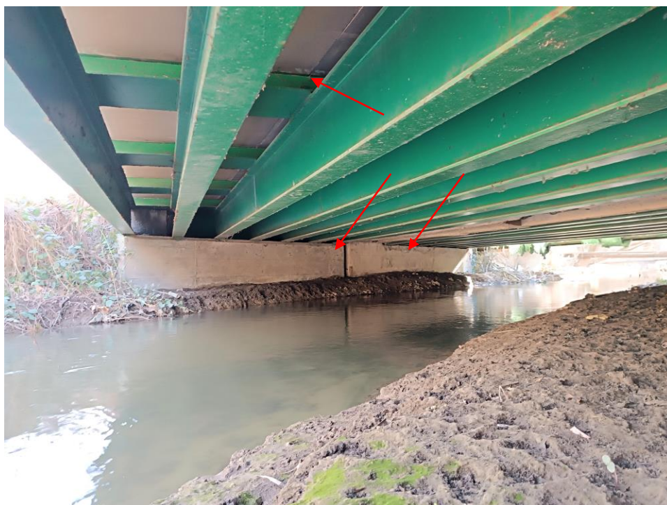
3. kép: A folyásirány szerinti bal oldali hídfő és felszerkezet.
