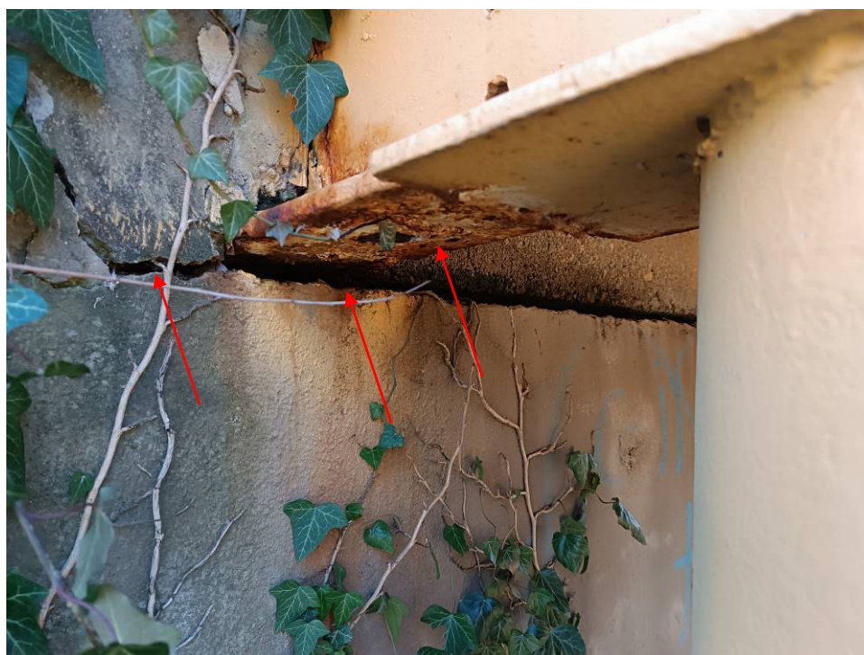
8. kép: A hídfő és felszerkezet csatlakozása.
