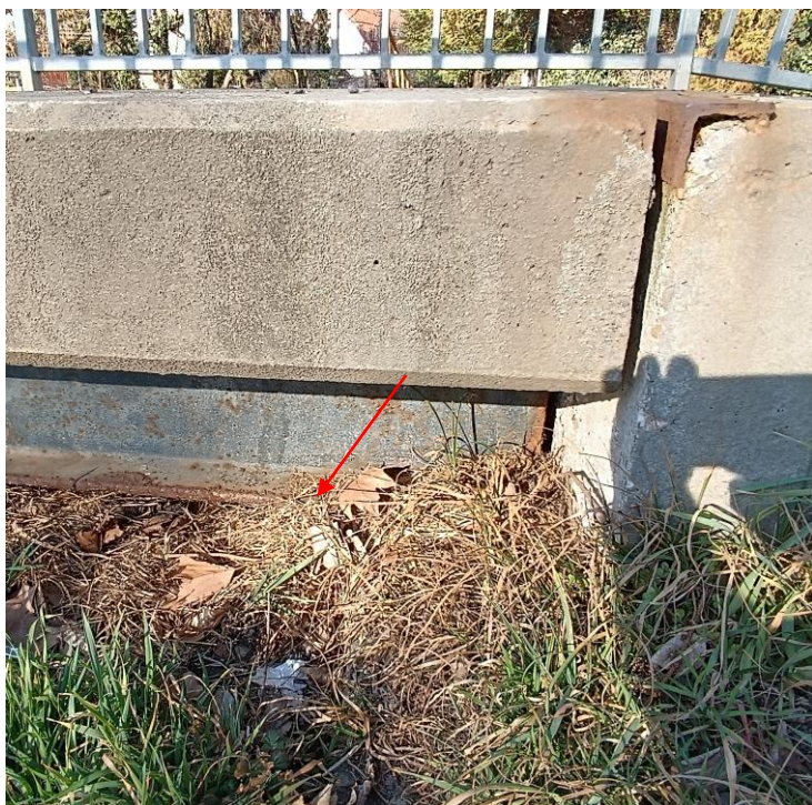
8. és 9. kép: Hídfo, felszerkezet, szegély bal oldalon. Az acél főtartók korróziója a felfekvéseknél nagyobb mértékű.
