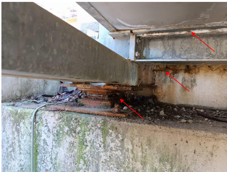
10. kép: Korrodált saru állapota. Lásd a 9. képnél leírtakat!
