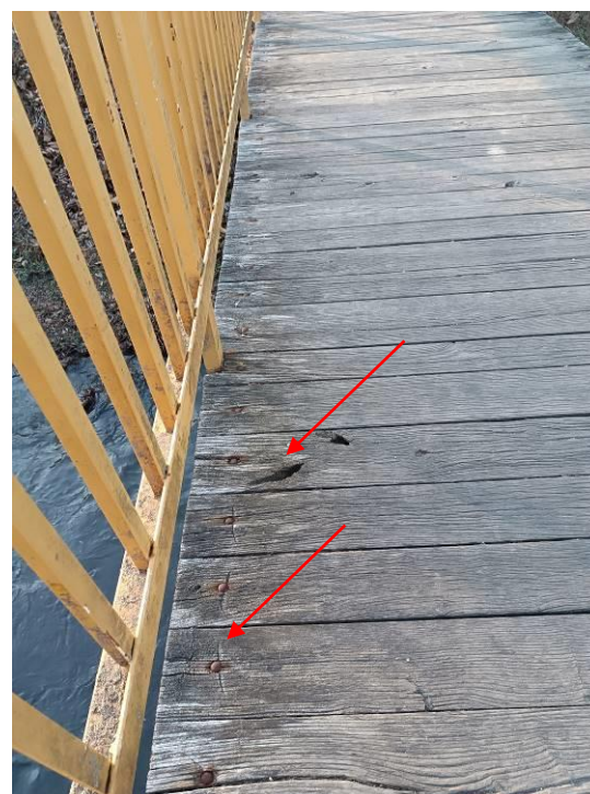
5. lép: Felszerkezet a park felől nézve. Az acél főtartókon és pallókat rögzítő csavarokon erős korrózió. A járópallók szélei korhadnak. A hídfőn erős leázások nyomai.
