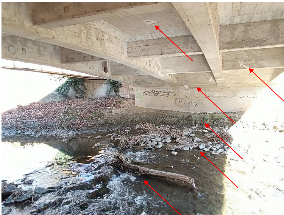
9. kép: Bal oldali hídfő és felszerkezet alulról.
