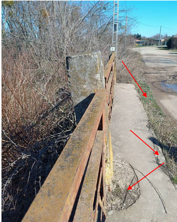
3. és 4. kép: Híd befolyási- és kifolyási oldalán lévő korlát és szegély állapota.
