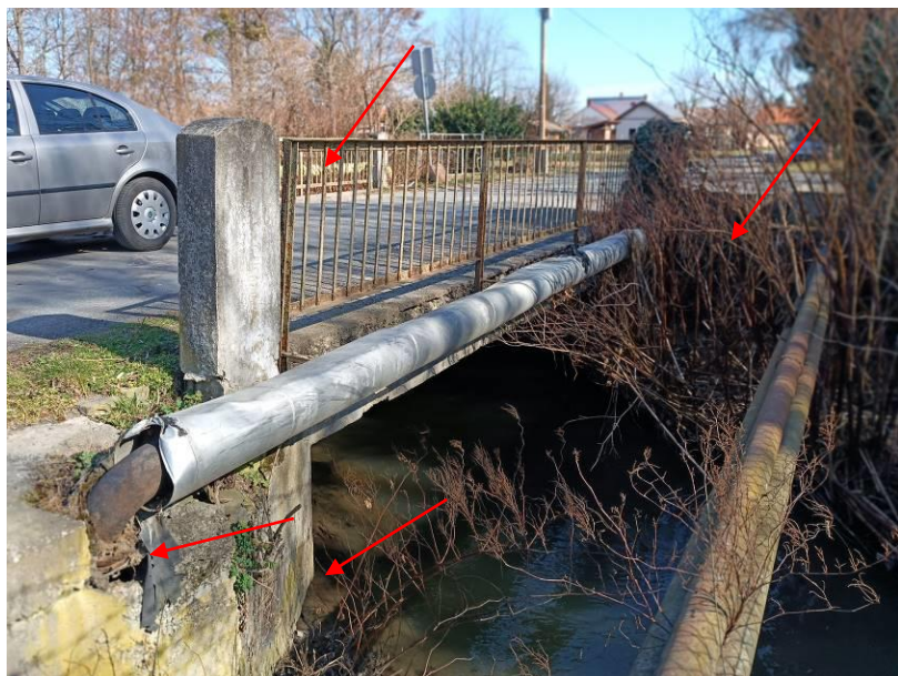
2. kép: Oldalnézet, kifolyási oldal Korróziós korlát, túlbujánczott növényzet, régi kimosódás, korlátra rögzített közmű átvezetés, károsodott aknafal.
