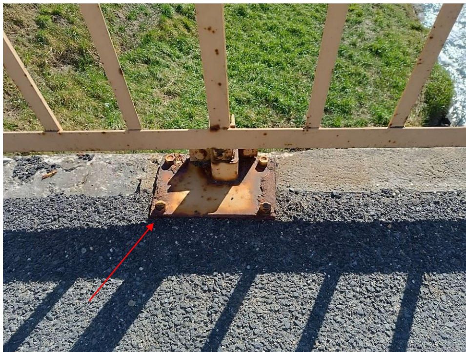
8. kép: Korlát talp közelről kifolyási oldalon. A hiányzó bevonatok miatt a korláttalpakon előrehaladott korrózió látható.
