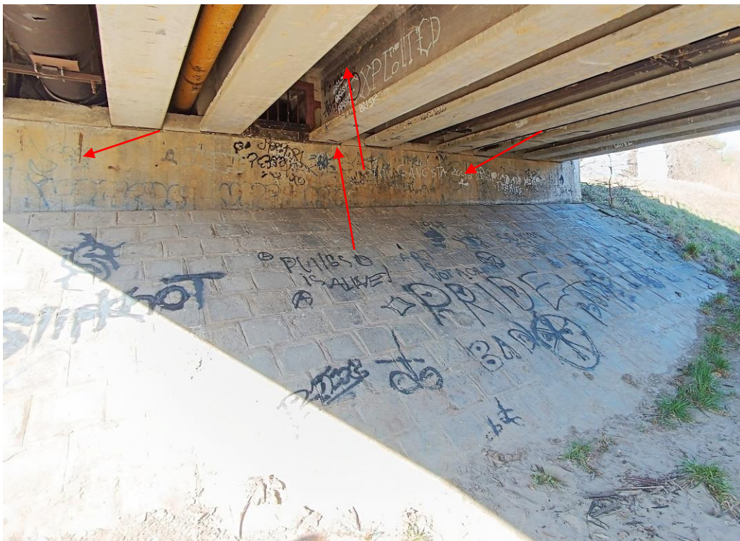
6. kép: Felszerkezet és hídfő a jobb parti oldalon. A jobb oldali hídfő jobb állapotú, de már itt is lefolyásnyomok és korróziós betonacélok láthatók. A hídfő felülete az árnyékos részen nedves, itt a fesztített gerendák felfekvése is jobban érintett. A nedvesség hatására alul acélkorrózió látható. A rézsűburkolat több helyen megsüllyedt, a széleket belepte a növényzet.
