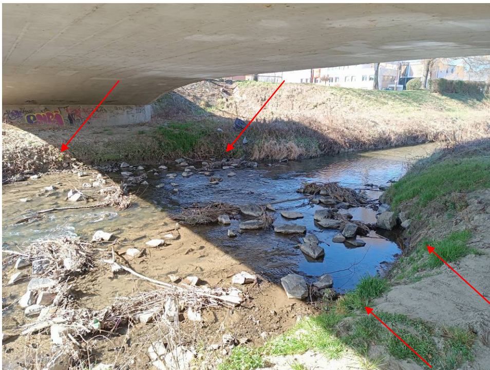
14. kép: Meder állapota. A meder elfajult, medervédelem nincs kialakítva, ezért mindkét partoldal kimosódott. A mederben a lemosódott kövek és sok uszadék látható.
