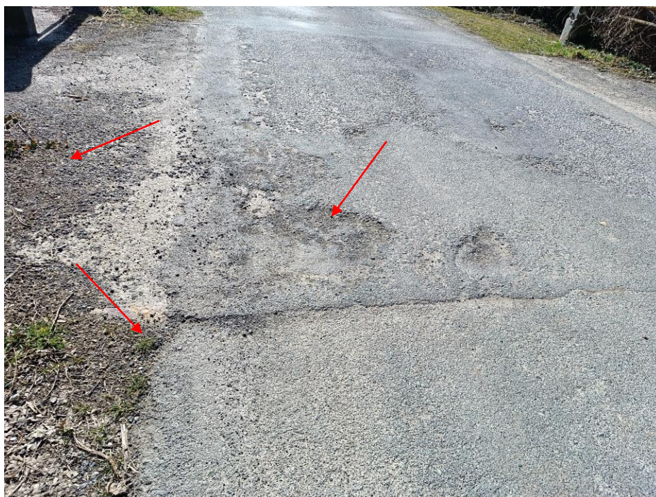
8. kép: A híd pályaburkolata és csatlakozása. A csatlakozó út burkolata keskenyebb a híd szélességénél. A hídon lévő aszfaltburkolat kátyús, repedezett, a széleken hordalékkal szennyezett.
