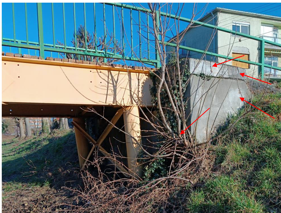
7. kép: Jobb oldali hídfő, szárnyfal állapota.
