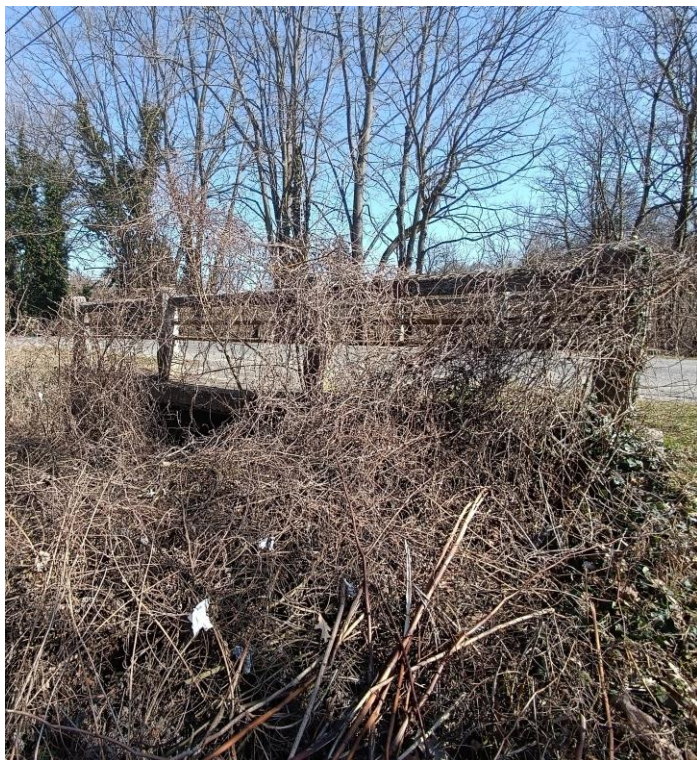
6. és 7. kép: A híd szélé a befolyási és kifolyási oldalon. A növényzet főleg a befolyási oldalon belepte a hídszélet. A vasbeton lemez szélé leválik az acélkorrózió következtében, A korlátok nem szabványosak, balesetveszélyesek!
