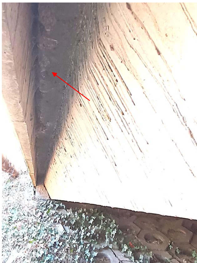
9. és 10. kép: Szegély-vízorr a felvízi oldalon, ill. korlát Meszes leázási foltok láthatók, a szegély hosszézag tömítetlensége miatt. A korlátok talpain és csomópontjain jelentős korrózió látható.
