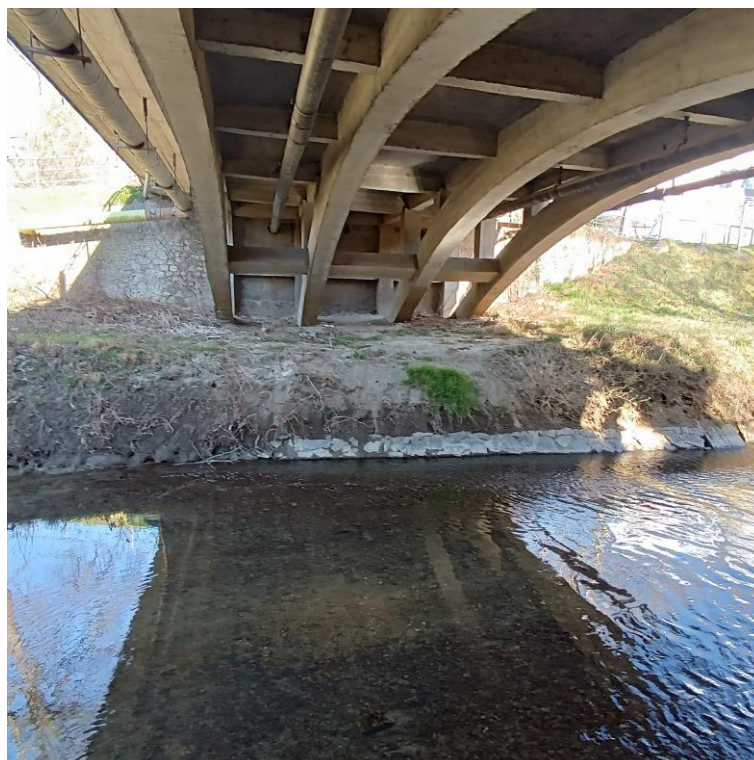
15. és 16. kép: Kifolyás oldali konzol, ill. bal oldali hídfő és medertér.
