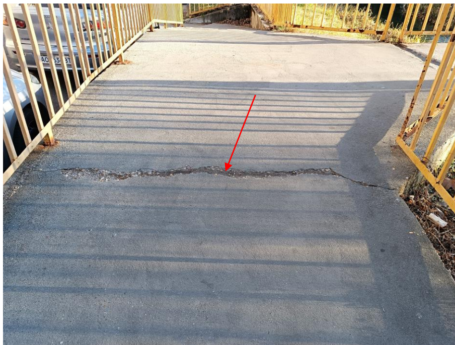
12. kép: Csatlakozó rámpa, K-i hídvég. Elrepedt, eltört betonlemez.
