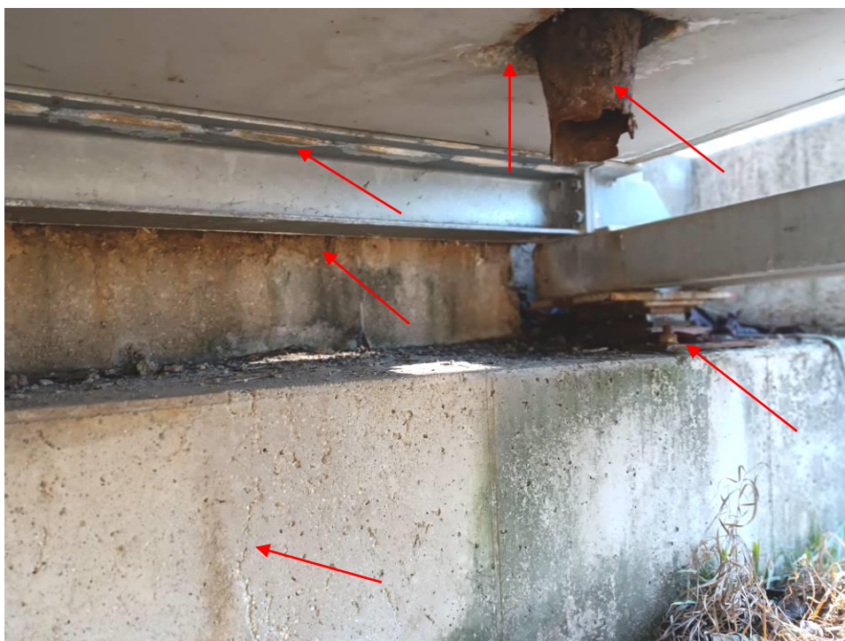
9. kép: Korrodált saru állapota.
