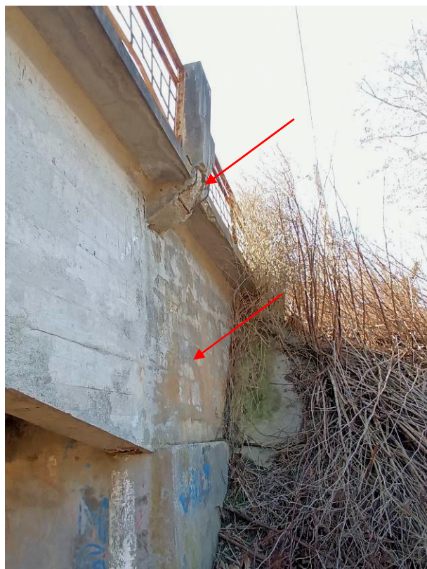
10. és 11. kép: Főtartók állapota.
