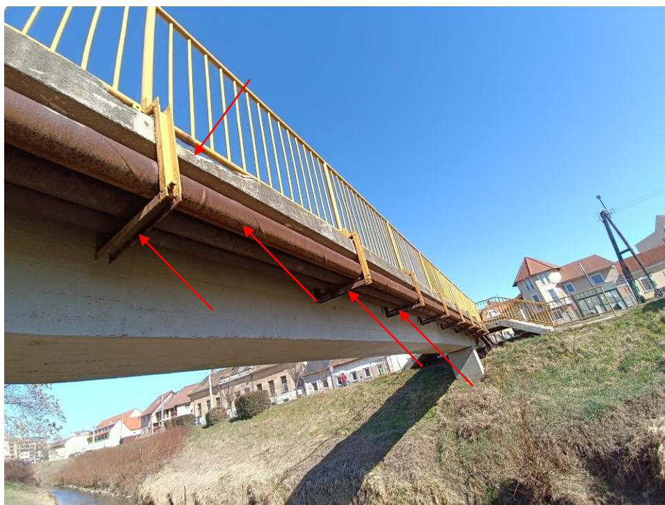
9. kép: Közművezetékek felfüggesztése, kifolyási oldal.
