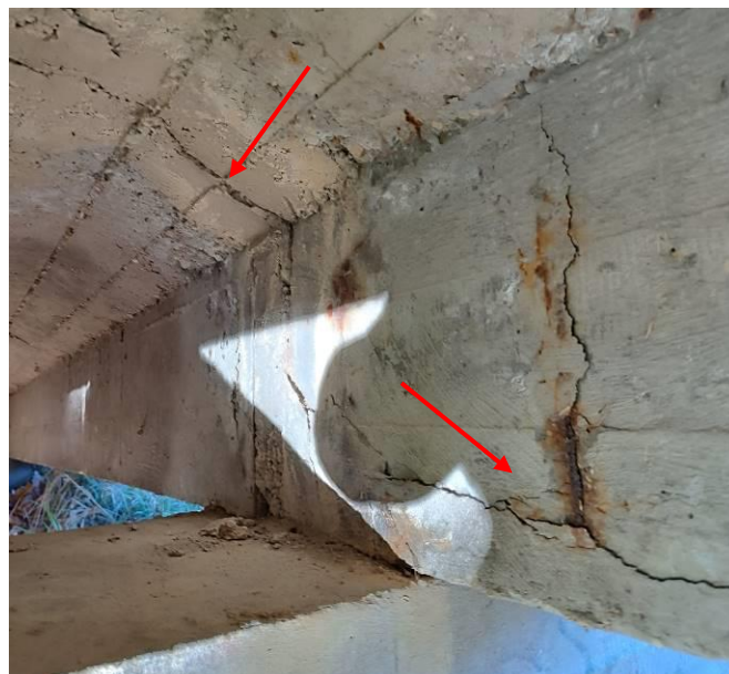
4. és 5. kép: A bal oldali támasz, tartók felfekvése.
