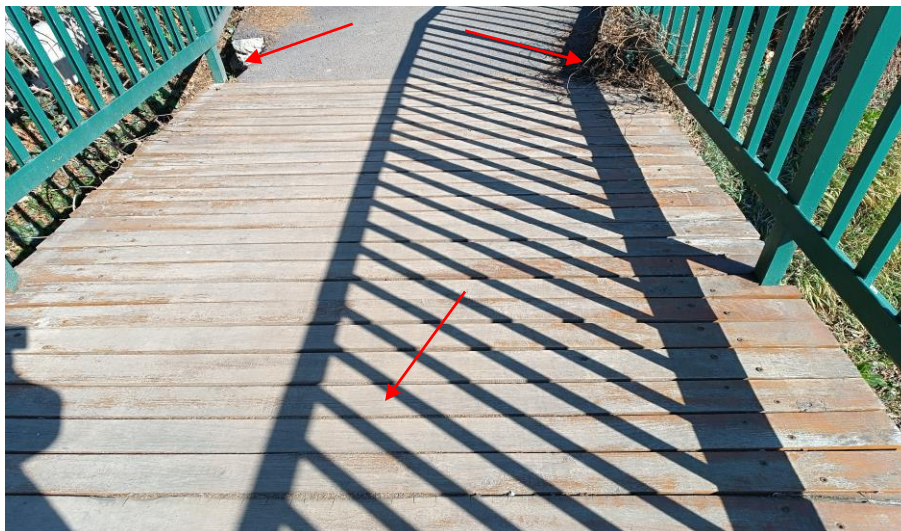
7. kép: Járófelület és csatlakozás A pallók favédelme megkopott, a csatlakozások megfelelőek. A levált betonsaroknál balesetveszély!
