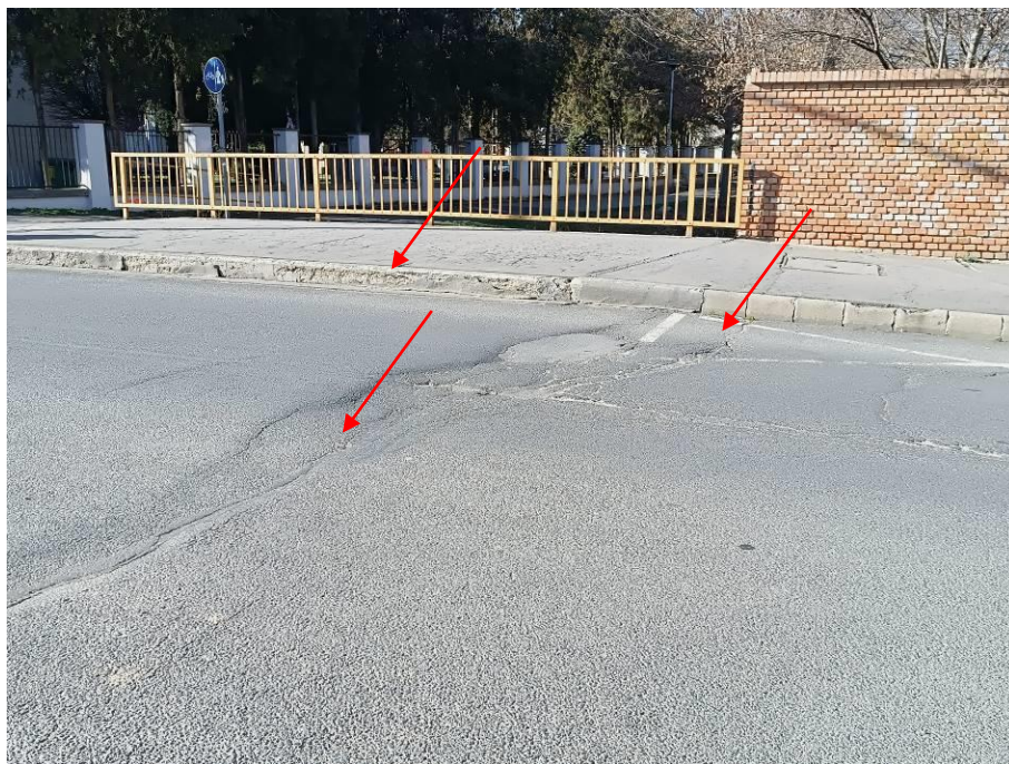
4. kép: Hídvég és burkolatcsatlakozások, bal (K-i) oldal.
