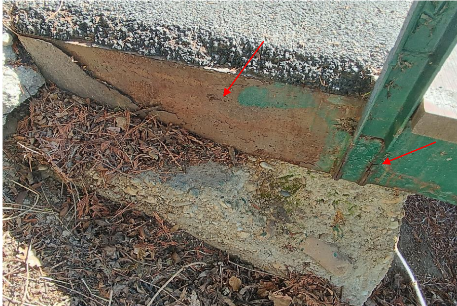
5. kép: Bal parti hídfő és felszerkezet. Levált betonsarok (vasalat nem látható), a gerendavég jelentős korróziója.
