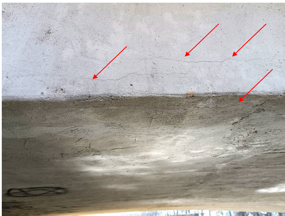
9. kép: Tartószerkezeti repedések.
