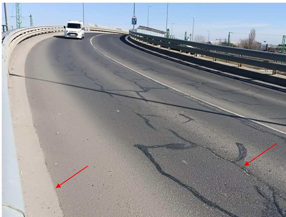
29. kép: Útburkolat a hídon a Ny-i hídfő után Az aszfaltburkolat repedezett, nyomvályúsodó, kiöntéssel részben javított. Több helyen új repedések, kátyúsodás figyelhető meg. A hosszanti hézagtömítések megfelelőek.
