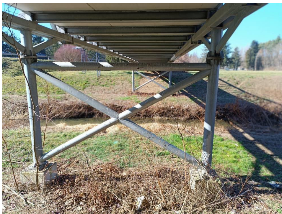
11. kép: Bal oldali pillér. A pillér stabil, tűzihorgonyzása megfelelő, nem korrodálódik. A híd felszerkezetének főtartói megfelelő állapotúak.
