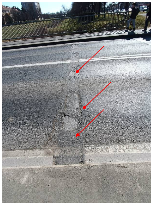
7. kép: Jobb oldali aszfalt dilatáció.
