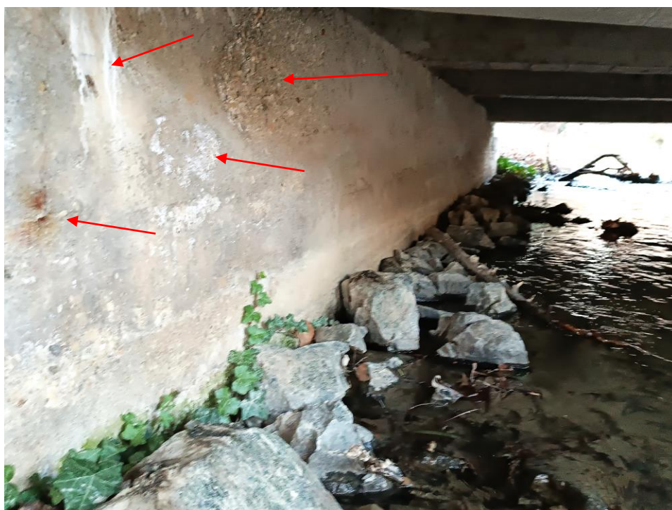
5. kép: Hídő a vízfolyás szerinti jobb oldalon. A hídők felületén repedések, meszes leázások, fészkes területek, korróziós foltok tapasztalhatók. A mederben uszadék fák hevernek.
