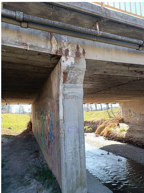
15. és 16. kép: Befolyási oldal, bal pillér repedései.
