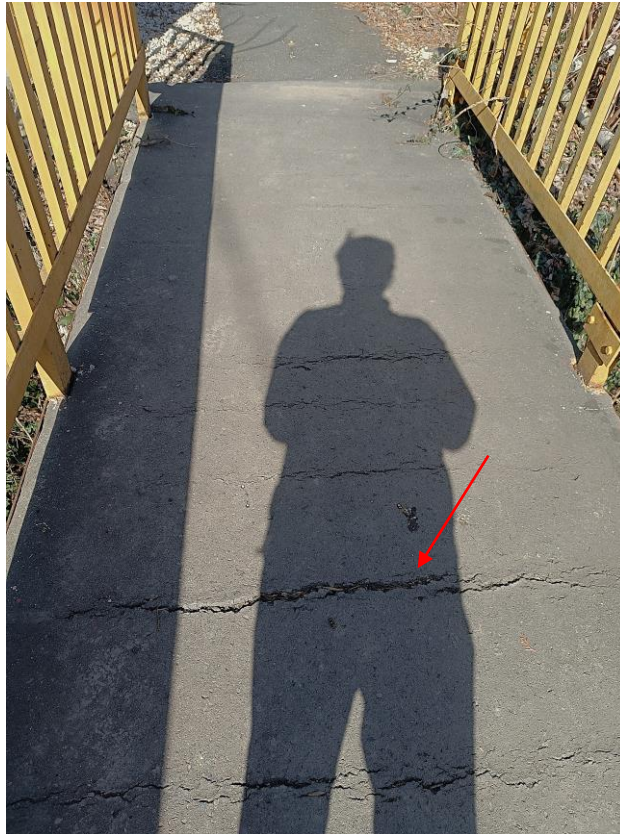
9. kép: Aszfalburkolat a hídon. A híd pályaburkolata öntött aszfalt. A keresztirányú repedések megnyíltak, tovább növelve a szerkezet leázását.
