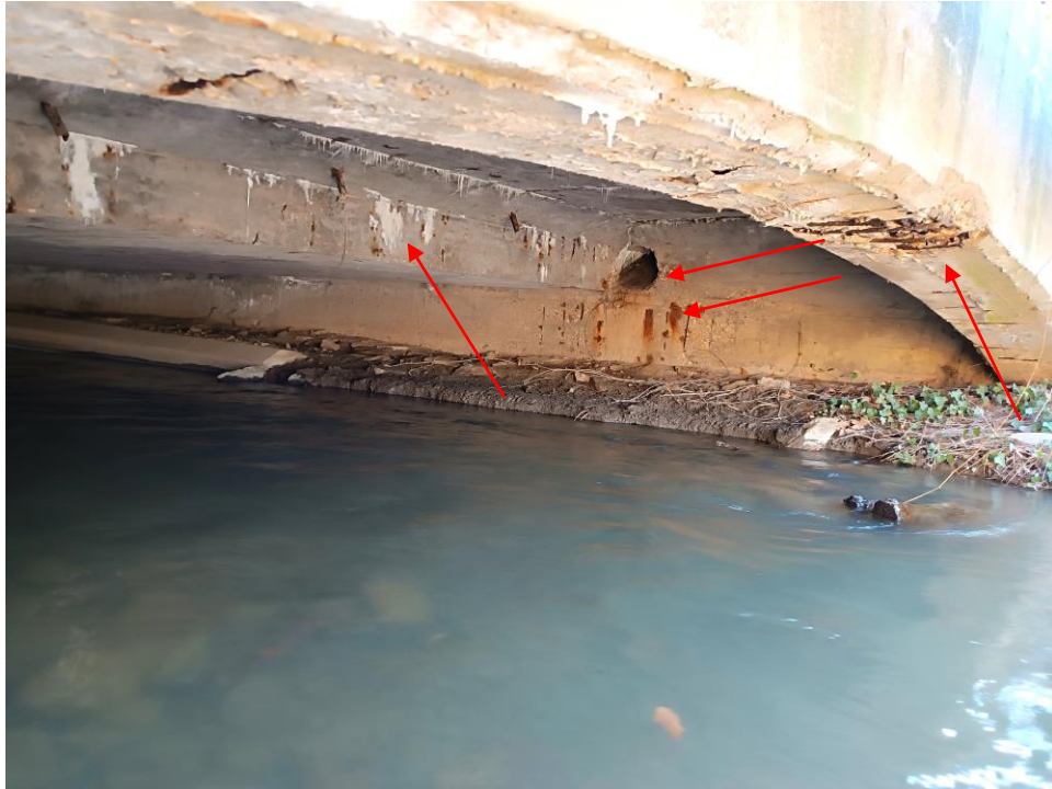
9. kép: Híd fő és felszerkezet a felvízi oldalon. A felhagyott csőáttörések tömítetlenek maradtak. Lásd a 8. képnél leírtakat!
